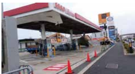
強風によりキャノピーの天井が落下したSS（2018.9.6撮影）
