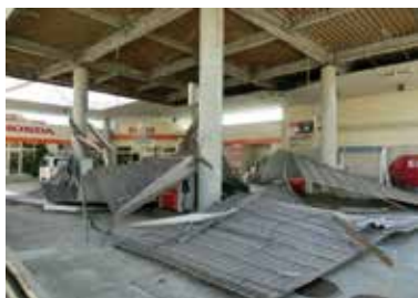
台風21号の強風により天井が落下し、SS敷地を覆いつくしたSS（2018.9.5撮影）
