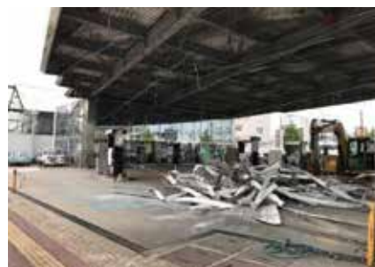
台風による強風によりキャノピーの天井が落下したSS（2018.9.6撮影）
