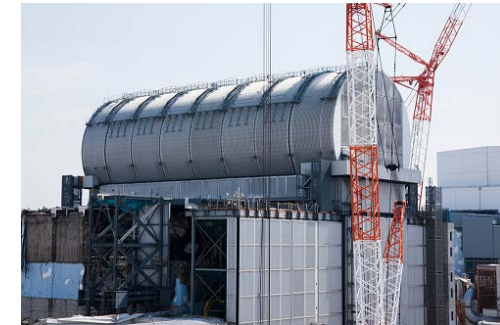
3号機原子炉建屋ドーム屋根
