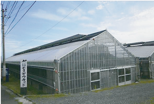
発電後の熱水を供給する周辺のハウス栽培施設
