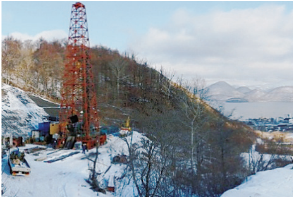
地熱資源掘削調査現場
