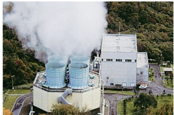
北海道森地熱発電所
