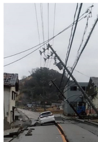
地震により倒壊した電柱(2024年1月能登半島地震)
