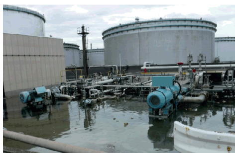
冠水した製油所敷地 (2019年10月台風)
