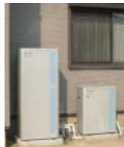
設置状況(名古屋)
