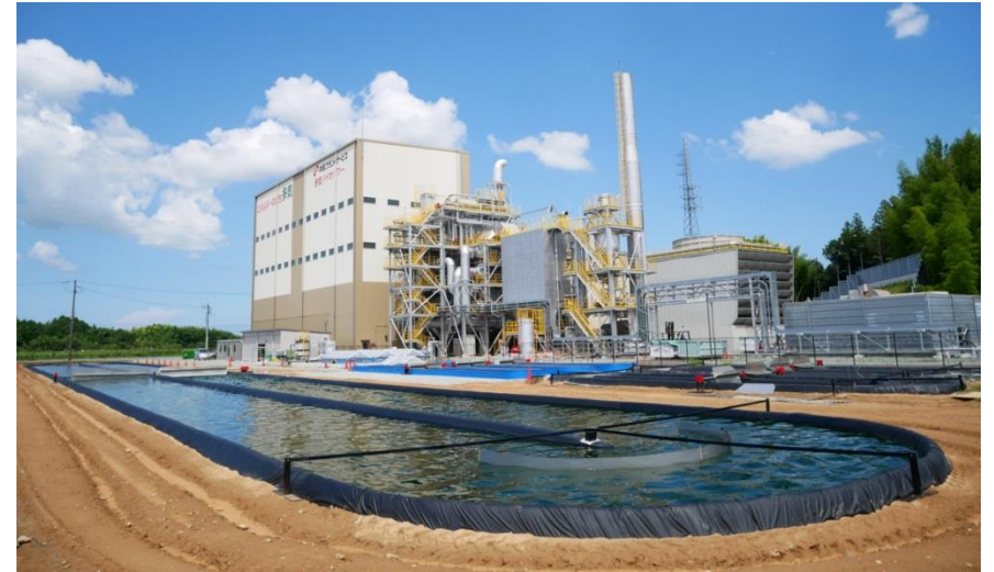
②三重県多気町で稼動する微細藻類培養プール (株式会社ユーグレナ)
