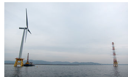
福岡県北九州市沖 （提供：電源開発（株））
