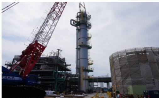
<CO 2 分離・回収設備の建設>
