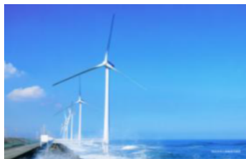
【風力発電設備】
