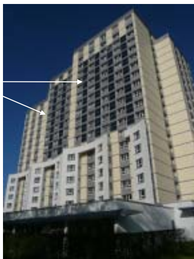
写真 1.5.2 ドイツフランクフルトの大規模集合住宅（集熱面積：252.1m 2 ）
