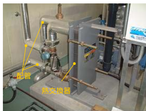
写真 4.2.4 熱交換器周り
