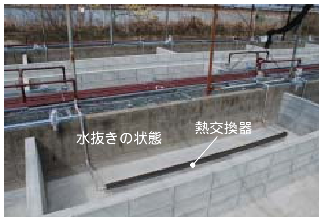
<養殖水槽内の熱交換器設置状況>
