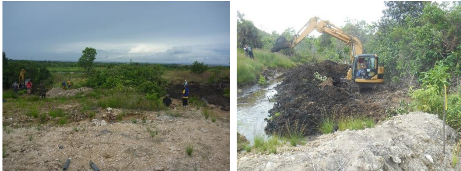
図 2.5.1-3 トレンチ 7 掘削状況
