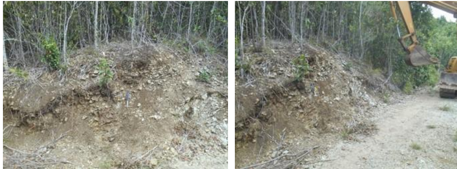
図 2.2.2-8 ストリッピング 3 掘削状況 (着手前 (左)、表層掘削 (右))
