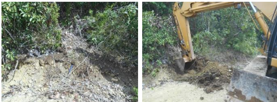
図 2.6.1-3 ストリッピング 2 掘削状況 (着手前 (左)、表層掘削 (右))
