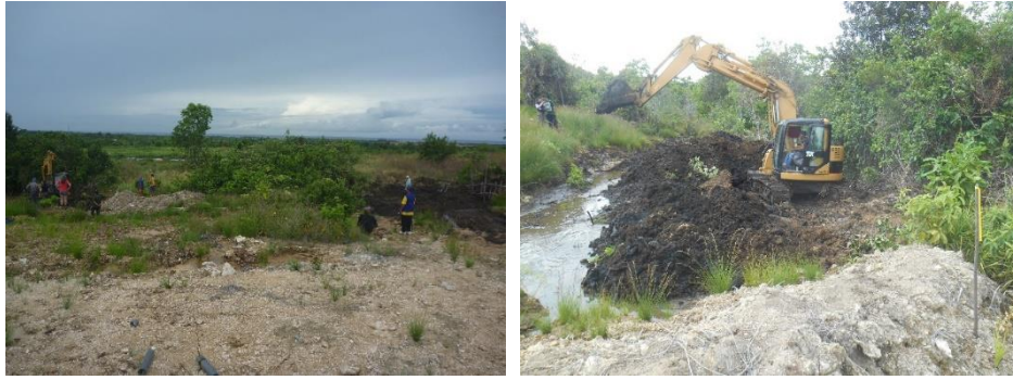
図 2.2.2-15 トレンチ 7 掘削状況
