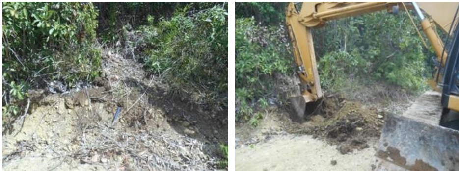
図 2.2.2-6 ストリッピング2掘削状況（着手前（左）、表層掘削（右）
