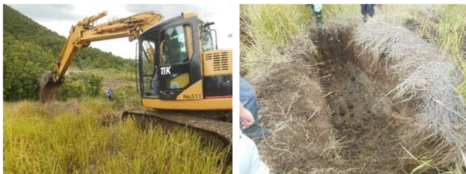
図 2.2.2-10 トレンチ 8 掘削状況
