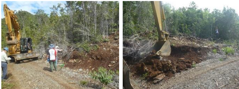
図 2.6.1-2 ストリッピング 1 掘削状況 (着手前 (左)、表層掘削 (右))
