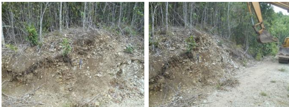
図 2.6.1-4 ストリッピング 3 掘削状況 (着手前 (左)、表層掘削 (右))
