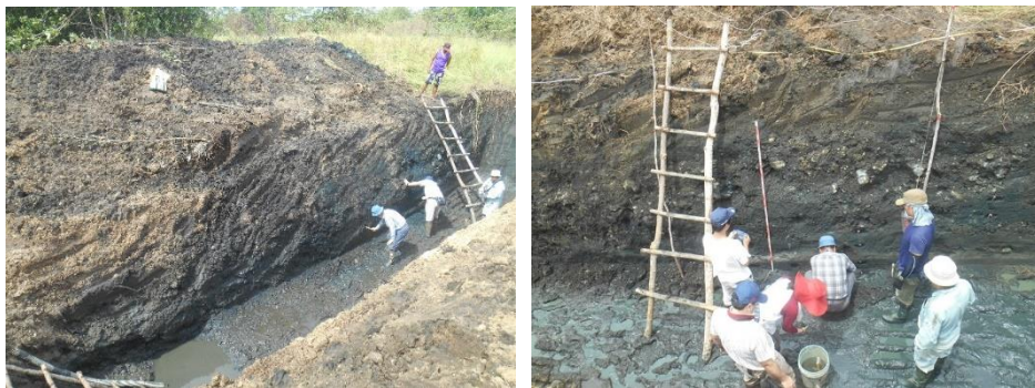
図 2.2.2-16 トレンチ 7 の壁面削りだし (左)、サンプリング (右)
