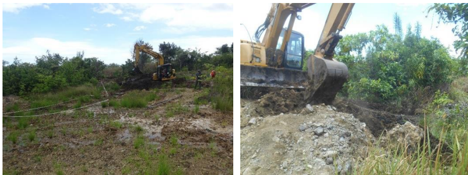
図 2.5.1-2 トレンチ 6 掘削状況
