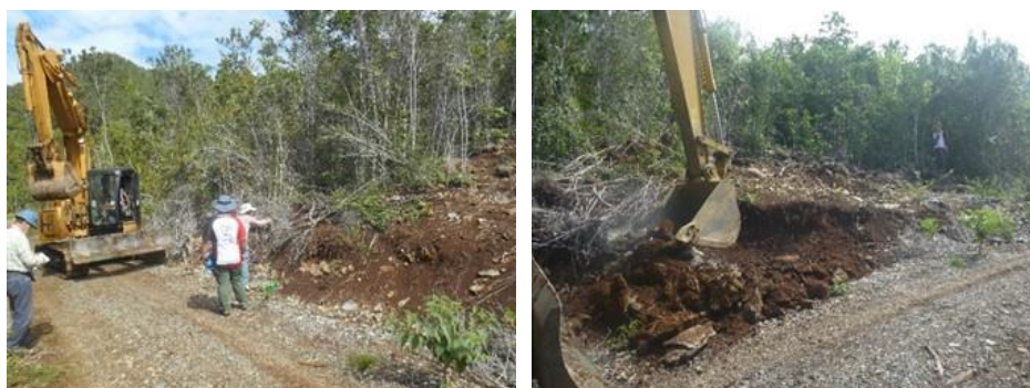
図 2.2.2-4 ストリッピング 1 掘削状況（着手前（左）、表層掘削（右））
