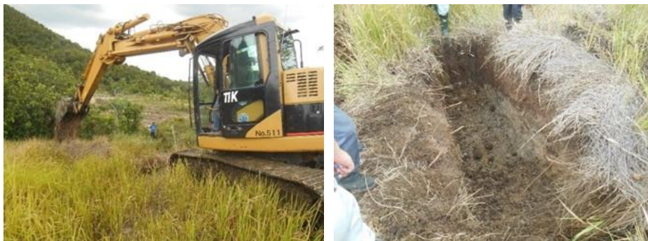
図 2.5.1-4 トレンチ 8 掘削状況
