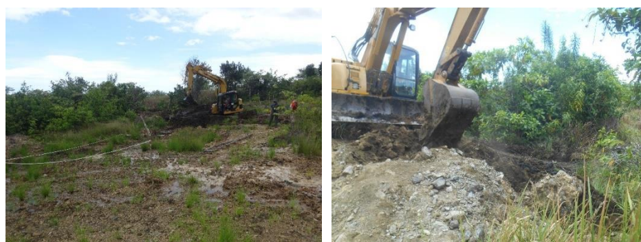
図 2.2.2-12 トレンチ 6 掘削状況
