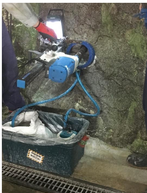
図21 ボーリング孔掘削時の様子
