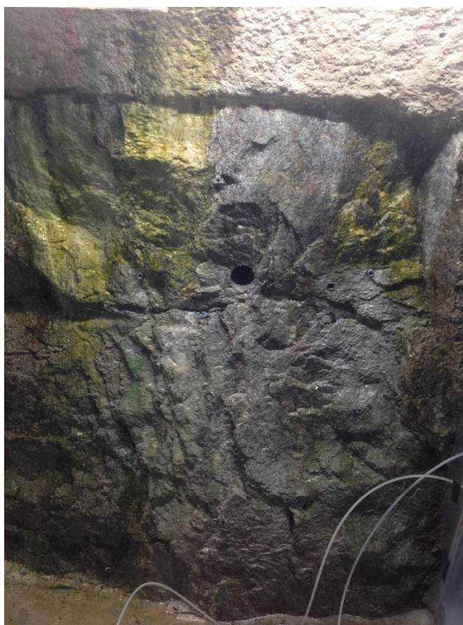
図3-1 原位置岩盤透水試験終了後の試験孔
