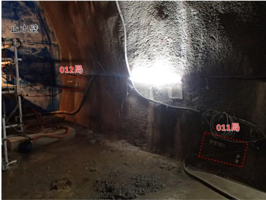
図 3.2.6-7 冠水坑道内の小型送信器
