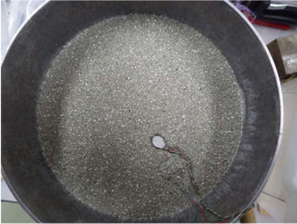
図 3.5.1-11 土圧計および水位センサー設置状況
