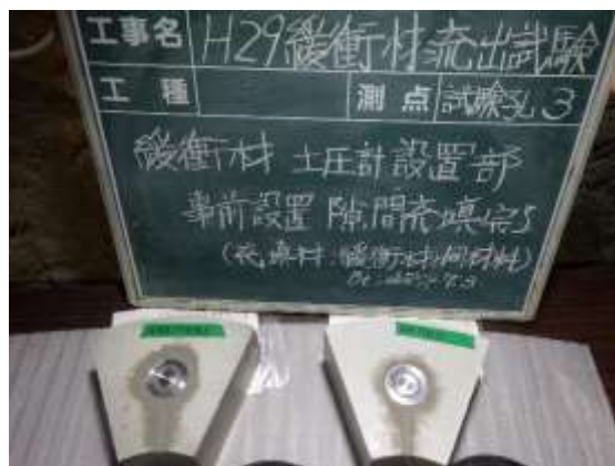
図 4.2.4-16 土圧計設置状況
