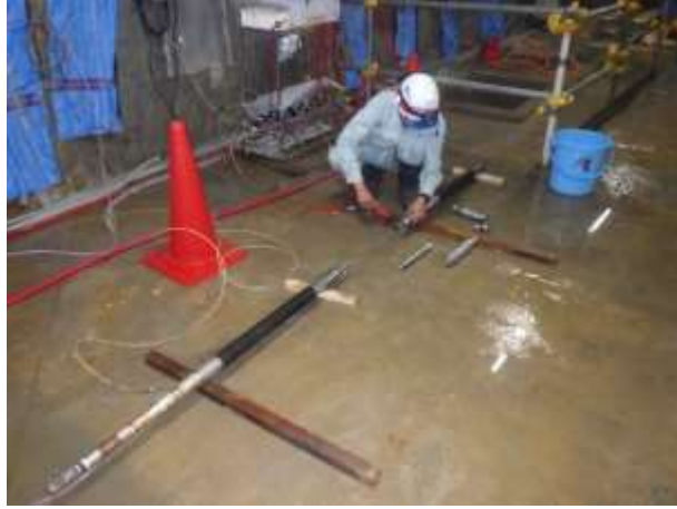
図 4.2.4-2 注水区間のパッカー、圧力計（水位計）組立状況
