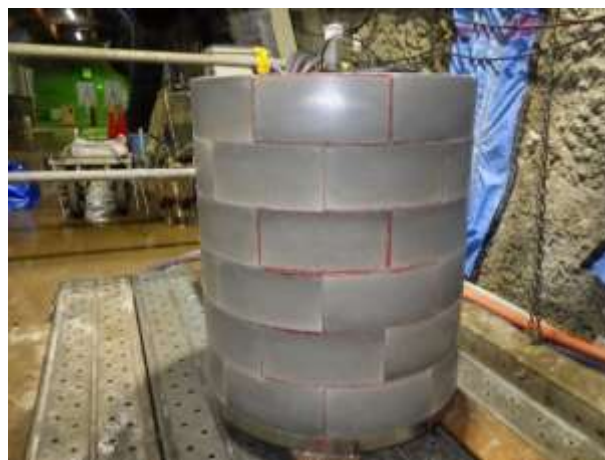
図 4.2.4-11 緩衝材ブロック間の境界の一部に油性マーカによるマーキング状況
