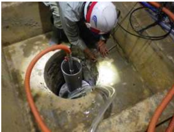
図 4.2.4-19 側部土圧計の設置状況
