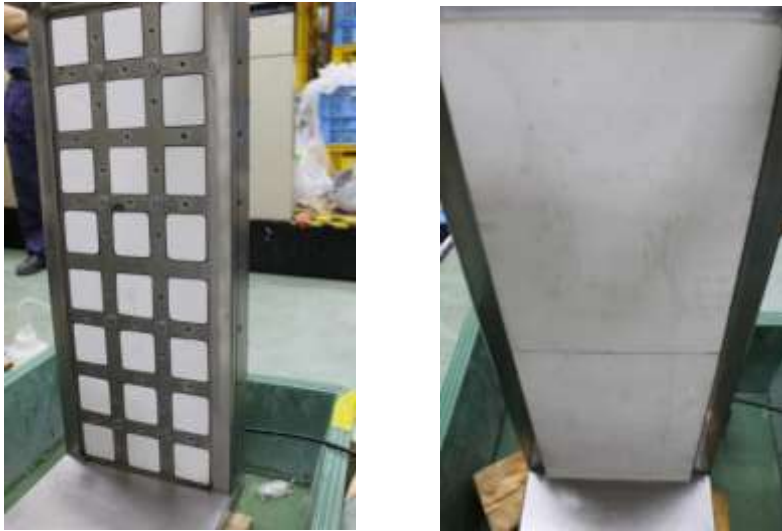
図 4.1.3-3 多孔質板の設置状況
