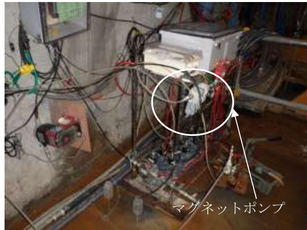
図 4.2.4-21 自動採水装置 マグネットポンプ
