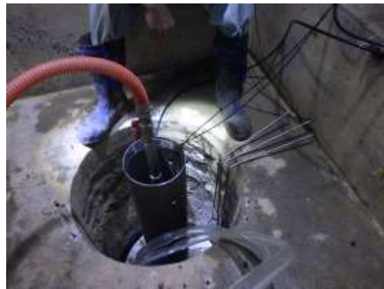
図 4.2.4-19 側部土圧計の設置状況
