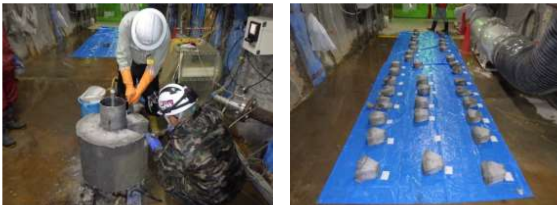
図 4.2.5-20 緩衝材の解体状況
