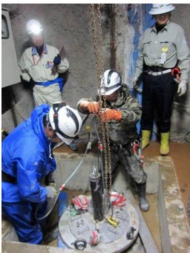
図 3.3.1-34 幌延 URL 工学規模試験 M30 アイボルト取付け (4か所)
