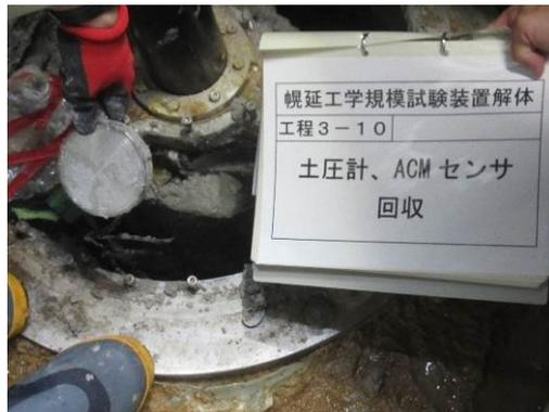
図 3.3.1-25 幌延 URL 工学規模試験 土圧計、ACM センサー回収
