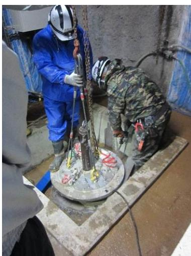
図 3.3.1-33 幌延 URL 工学規模試験 上蓋Φ33 穴のコーキング材撤去
