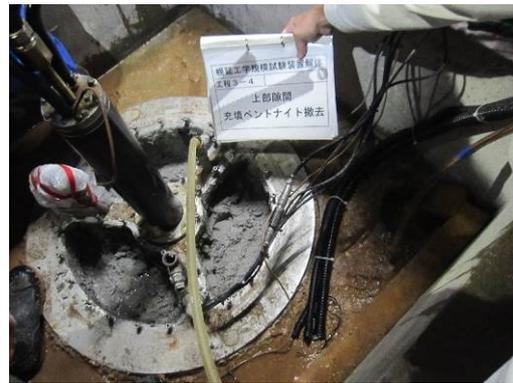
図 3.3.1-21 幌延 URL 工学規模試験 上部隙間充填ベントナイト撤去
