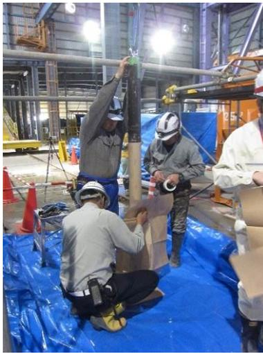
図 3.3.1-67 幌延 URL 工学規模試験 輸送のための防錆養生（防錆紙）
