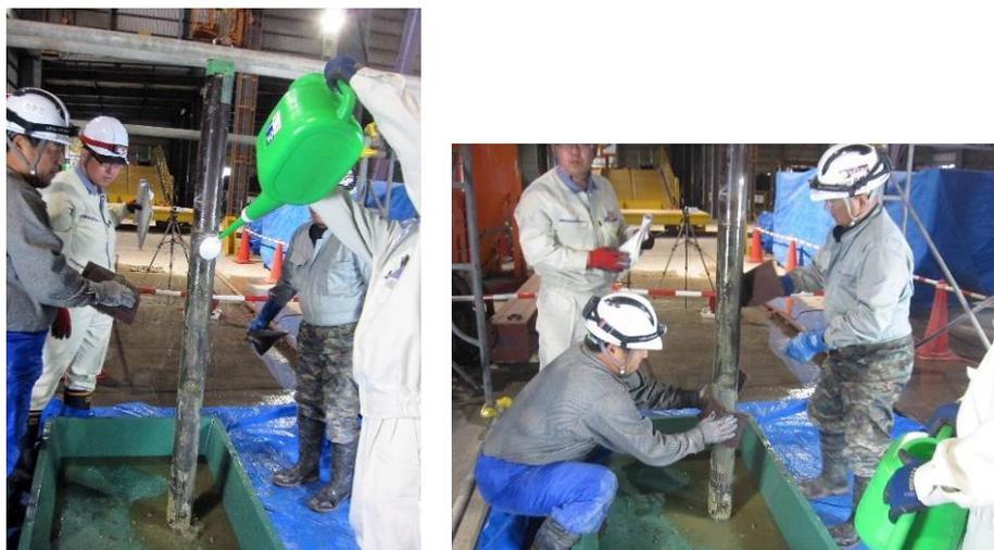
図 3.3.1-62 幌延 URL 工学規模試験 模擬オーバーパック現場洗浄（水洗い：精製水）
