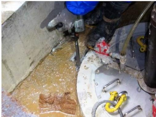
図 3.3.1-31 幌延 URL 工学規模試験 上蓋コーキング材撤去
