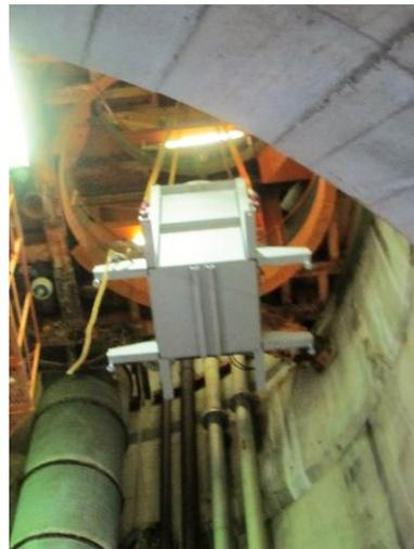
図 3.3.1-42 幌延 URL 工学規模試験 搬送容器の地下 350 m 坑道からの搬出
