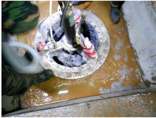
図 3.3.1-26 幌延 URL 工学規模試験 試験孔側部の珪砂・地下水の回収完了
