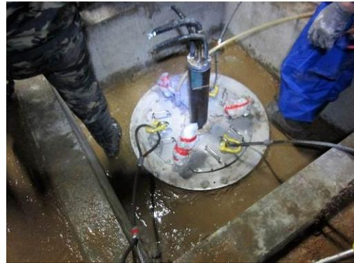
図 3.3.1-27 幌延 URL 工学規模試験 アイボルト付投入口カバー取付け（3か所）
