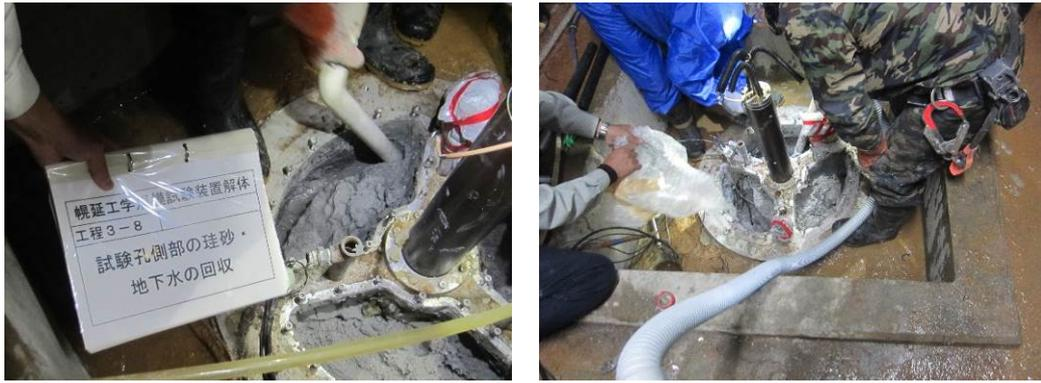
図 3.3.1-23 幌延 URL 工学規模試験 試験孔側部の珪砂・地下水の回収状況 (1/2)
