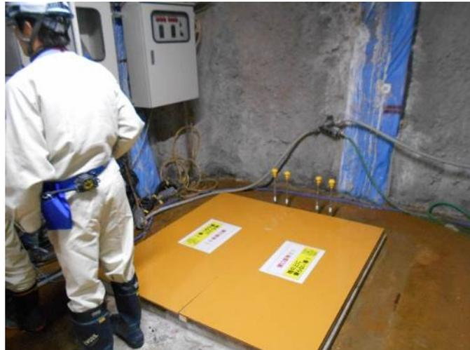
図 3.3.1-71 幌延 URL 工学規模試験 試験孔 1 開口部養生（木蓋設置）
