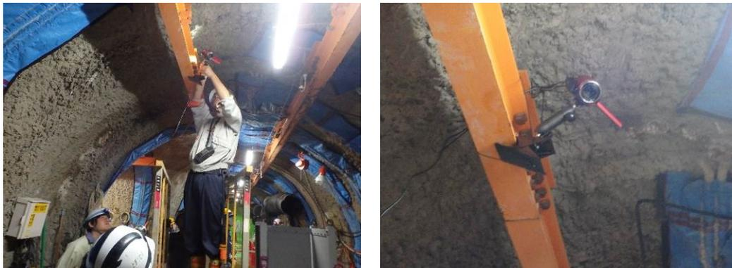
図 3.3.1-18 幌延 URL 工学規模試験 記録用固定カメラ設置状況
