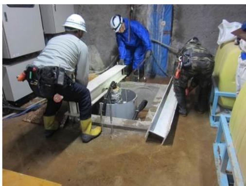
図 3.3.1-19 幌延 URL 工学規模試験 試験体固定フレームの撤去
