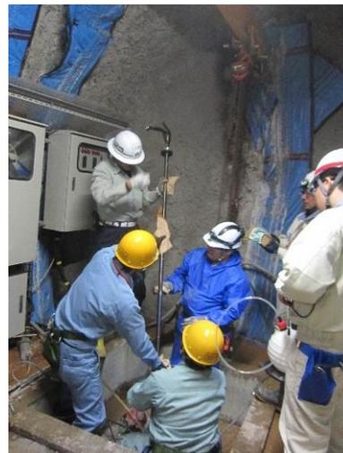
図 3.3.1-28 幌延 URL 工学規模試験 ヒータ引抜き・撤去
