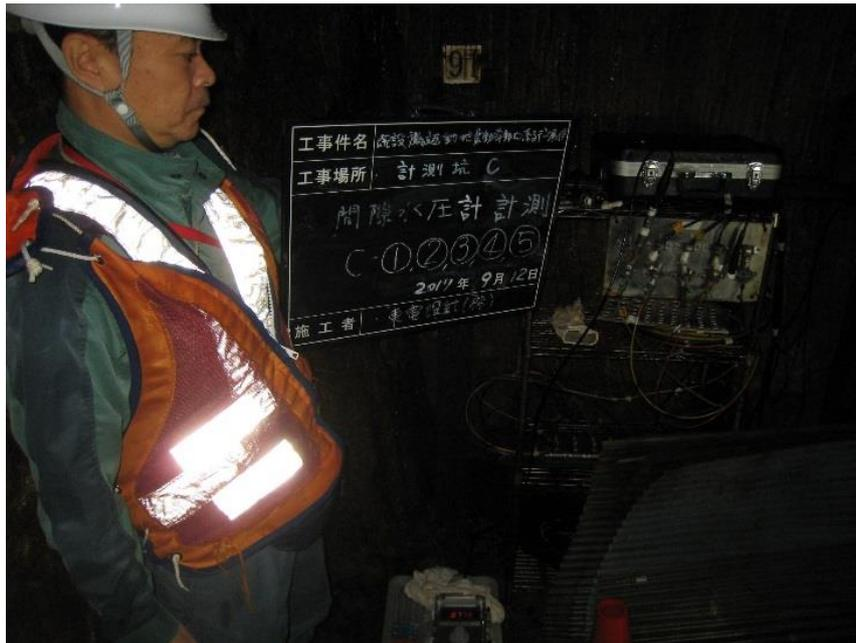
図 1.2-3 間隙水圧計計測（計測坑 C）
