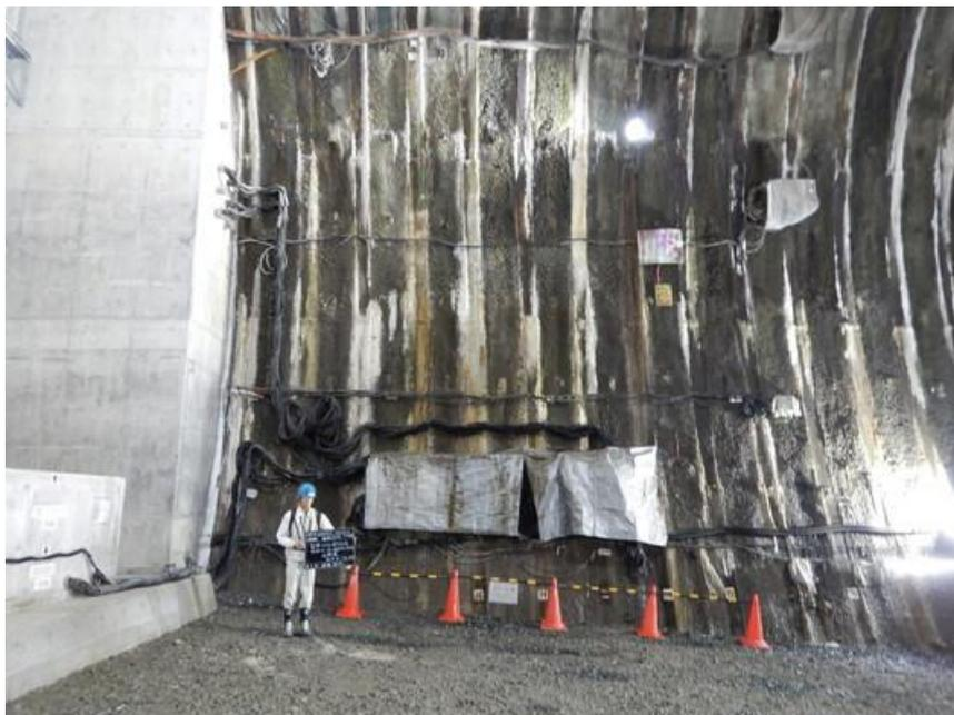
図 1.4-9 センサーケーブルおよび仮置き用棚の撤去（右側壁）（1/2）
