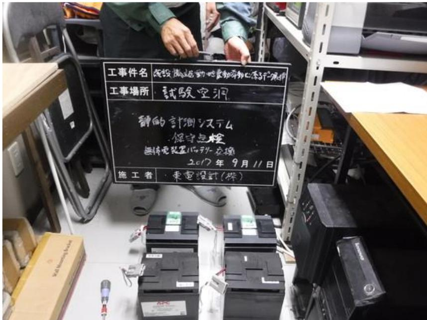
図 1.4-3 無停電装置バッテリー交換 (1/2)
