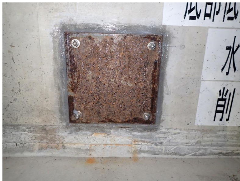
写真 4.1-4 観察孔鉄板養生後（拡大）
