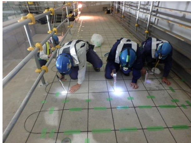
写真 3.5-7 センサー設置作業（上部）
