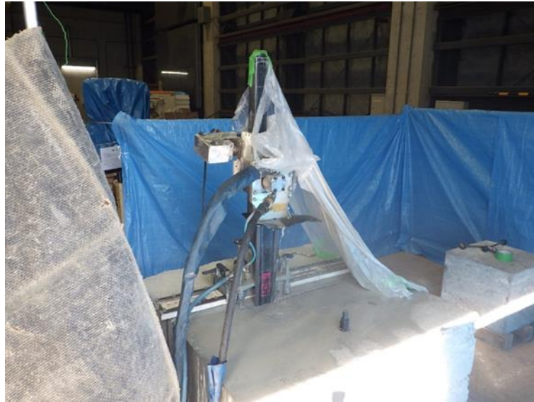
図 2.5-51 試験体のスリット導入状況(1/2)
