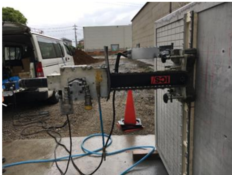
図 2.5-54 壁部材におけるダイヤモンドチェーンソウの施工状況
