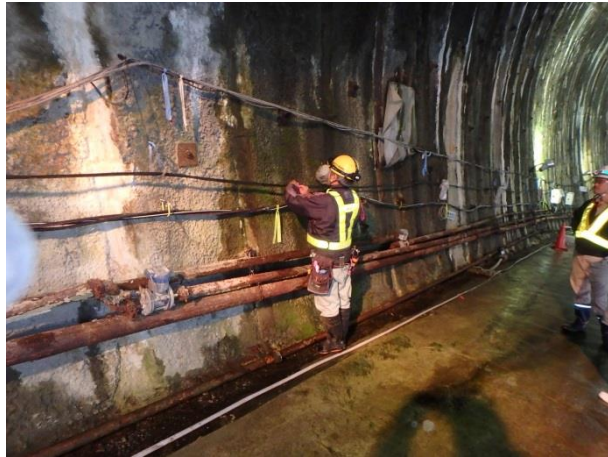
写真 3.5-29 温度計測用光ケーブル配線作業
