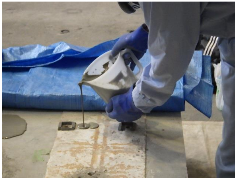
図 2.5-18 静的破碎剤の充填状況
