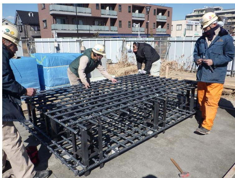
図 3.5-52 鉄筋の組立状況(1/2)
