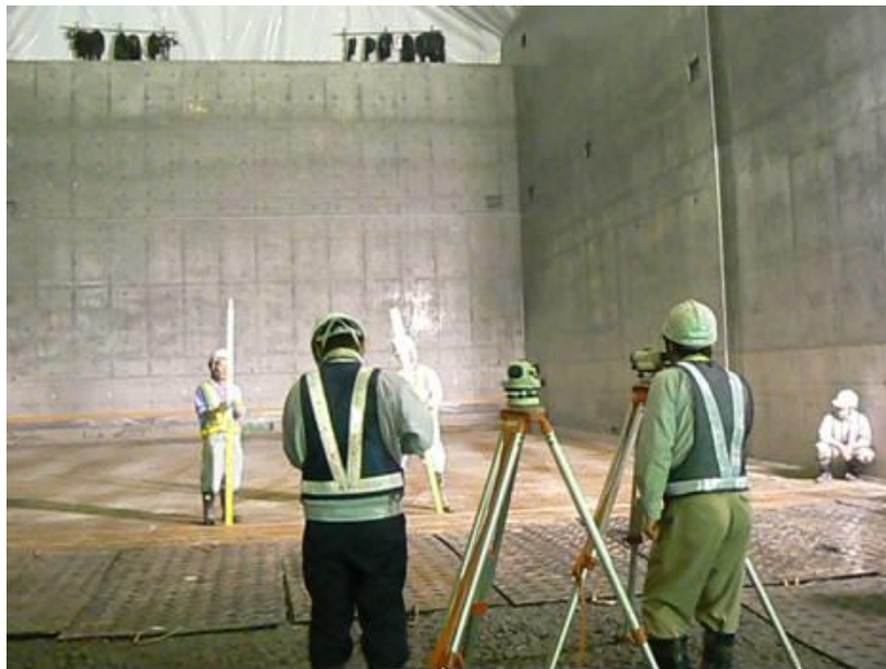
図 3.3-5 レベル測量による計測状況[3]
