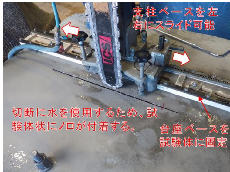
図 2.5-52 試験体のスリット導入状況(2/2)
