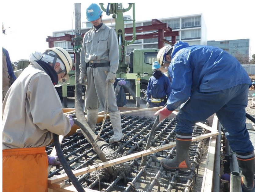
図 3.5-59 鉄筋コンクリート試験体打設状況
