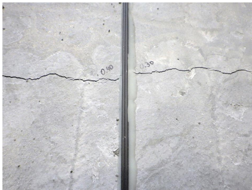
図 2.5-90 ひび割れ発生状況 (0.3mm~0.4mm 程度)
