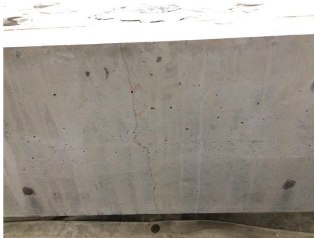
図 2.5-27 供試体中央部側面のひび割れの発生状況 (1/2)
