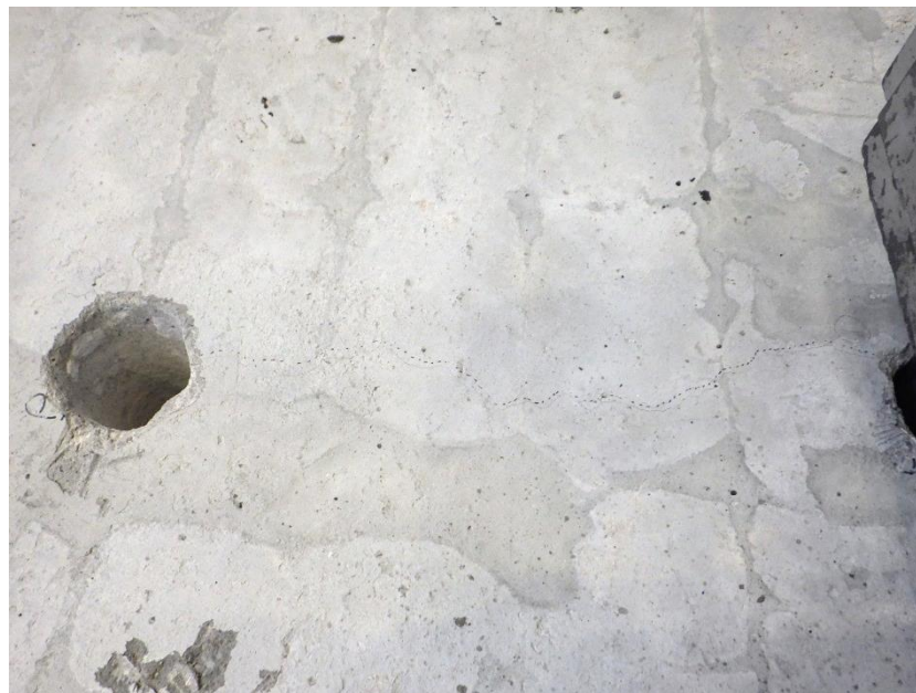
図 2.5-85 無筋コンクリート（光ファイバセンサー無し）ひび割れ発生状況
