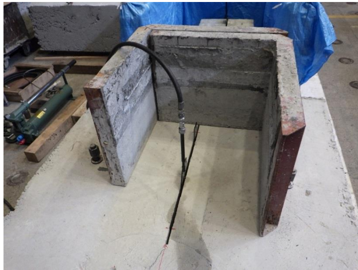
図 2.5-55 板ジャッキの挿入状況(1/2)
