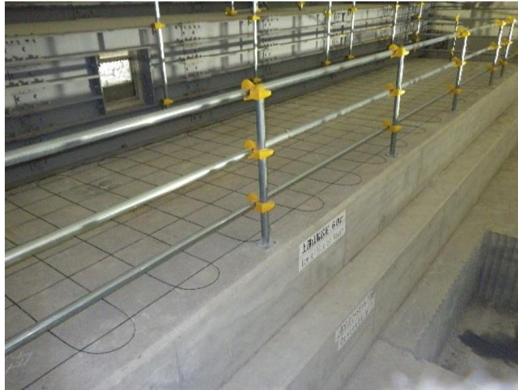
図 2.5-9 光ファイバセンサーの設置状況（上部低拡散層）
