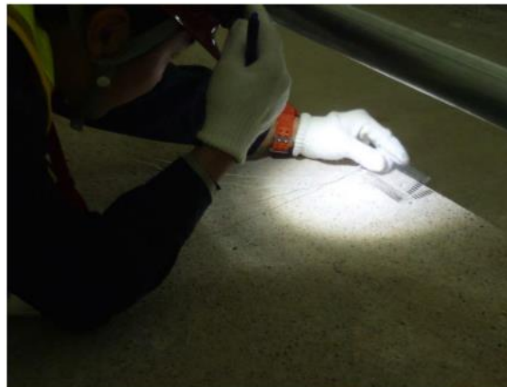
図 3.3-20 クラックスケールによるひび割れ幅の計測状況[14]
