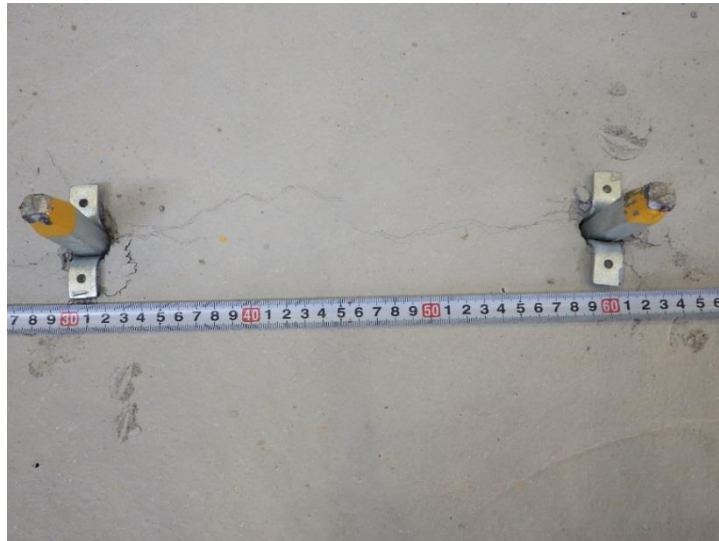
図 2.5-40 ひび割れの発生状況 (①、②貫入後)
