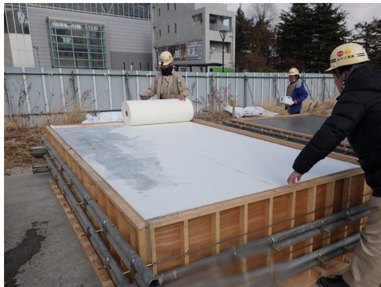
図 3.5-64 湿潤養生マット敷設状況
