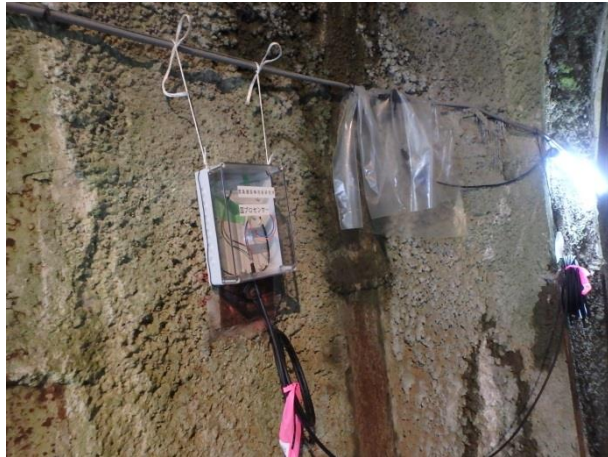
写真 3.5-32 端子箱（坑口側）
