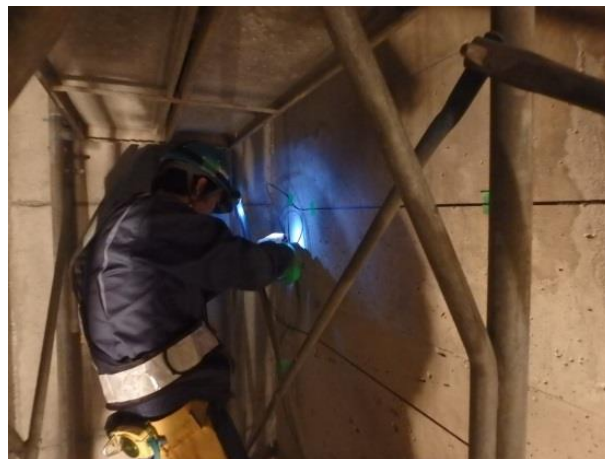
写真 3.5-3 センサー設置作業 (側部)
