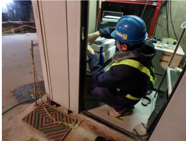
写真 3.5-23 計測器設置作業（計測小屋）
