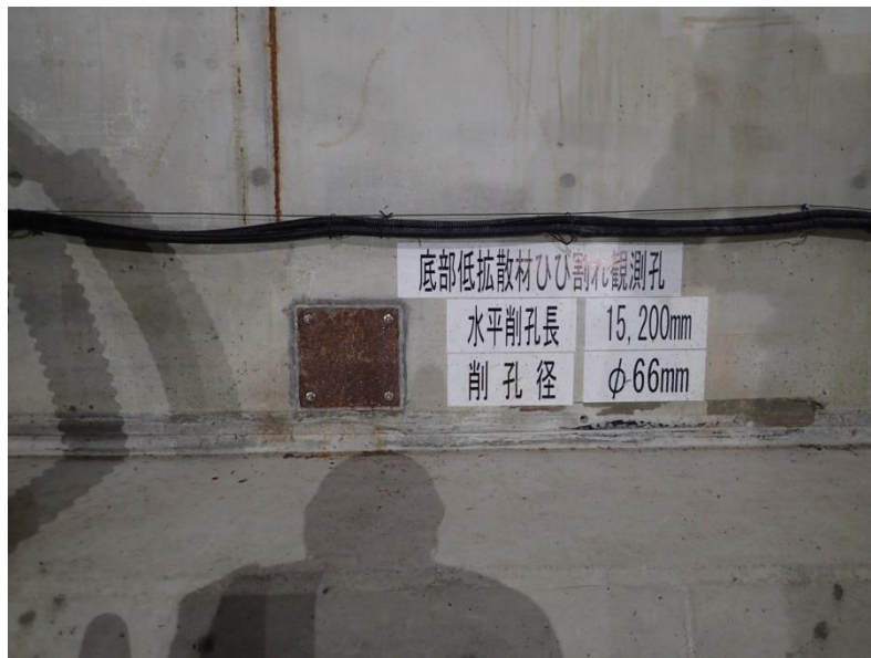
写真 4.1-3 観察孔鉄板養生後
