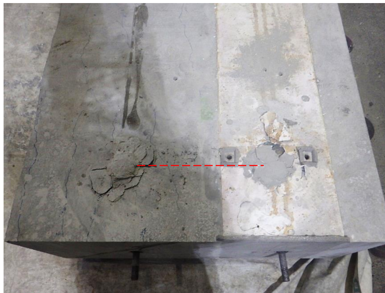
図 2.5-24 供試体端部のひび割れの発生状況（1/2）
