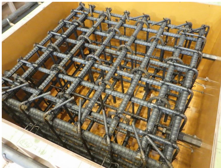
図 2.5-69 鉄筋の組立状況
