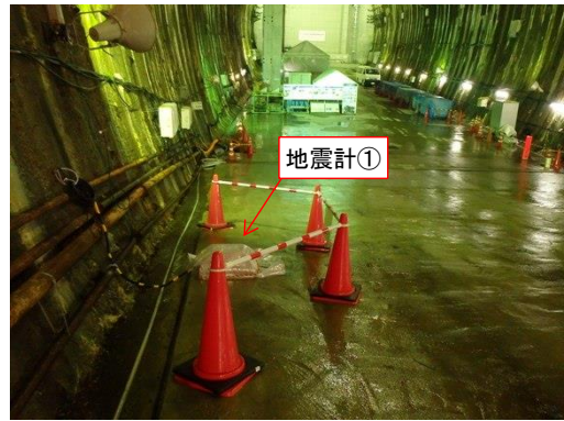
(2) 地震計① (移設後)
