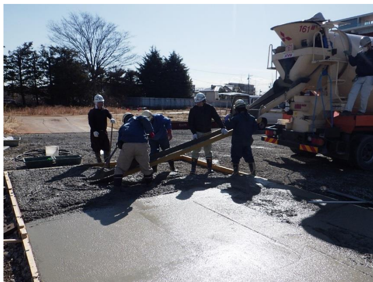
図 3.5-49 均しコンクリート打設状況
