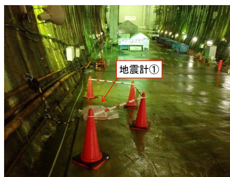
(2) 地震計① (移設後)
