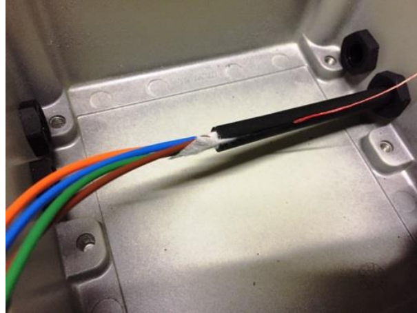
図 2.4-5 温度センサーケーブル
