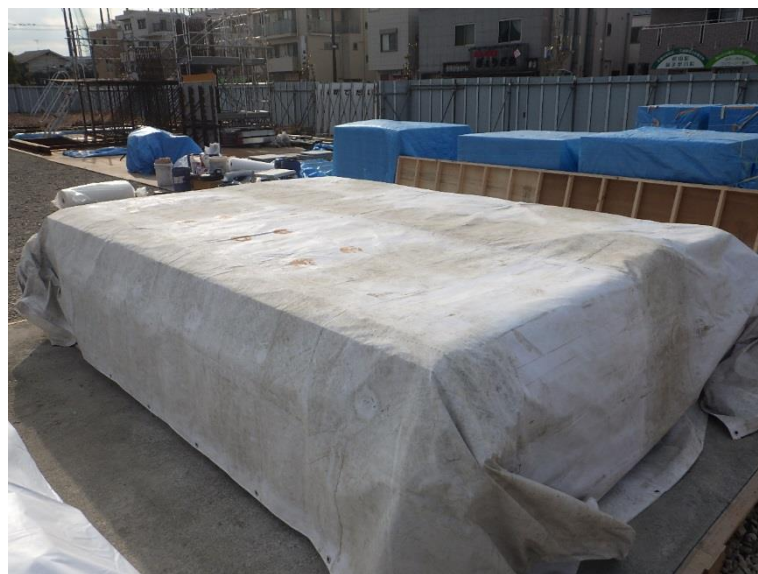
図 3.5-66 湿潤・保温養生完了
