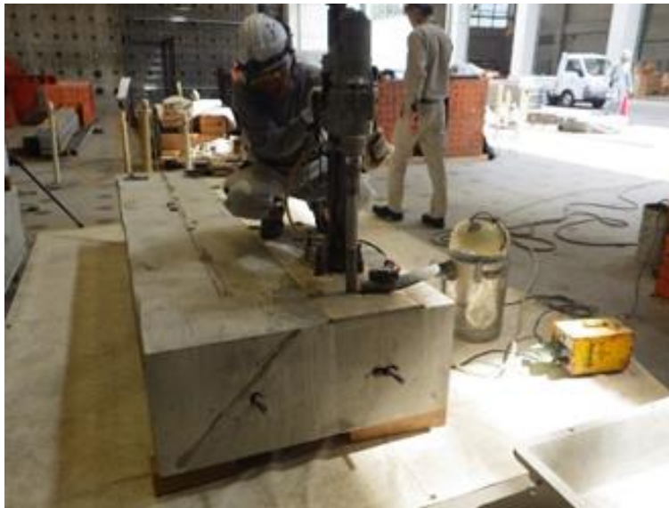
図 2.5-15 コアの削孔状況
