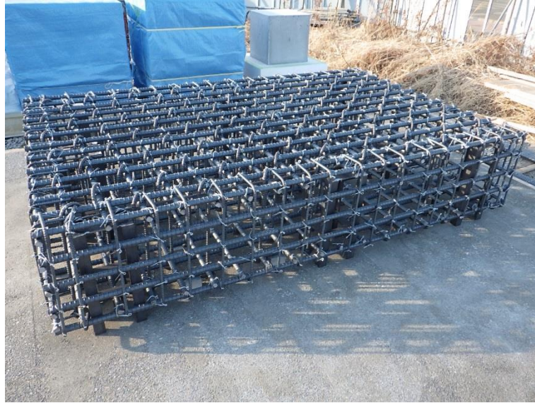
図 3.5-55 鉄筋組立完了
