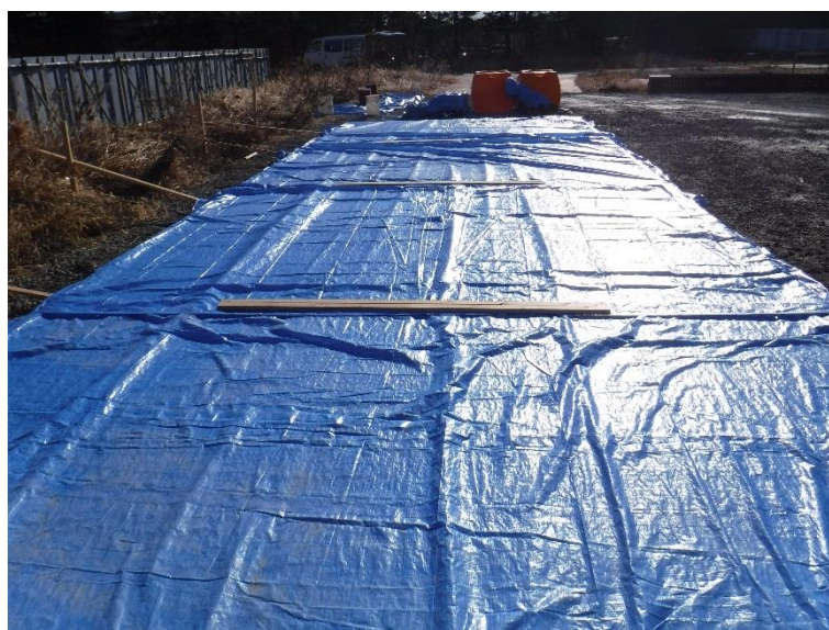
図 3.5-50 均しコンクリート養生状況
