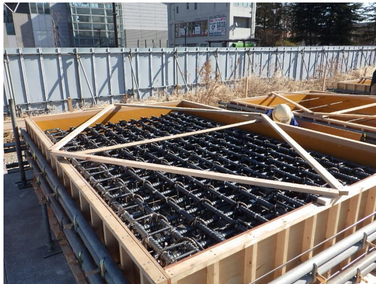
図 3.5-56 鉄筋コンクリート試験体型枠組立状況
