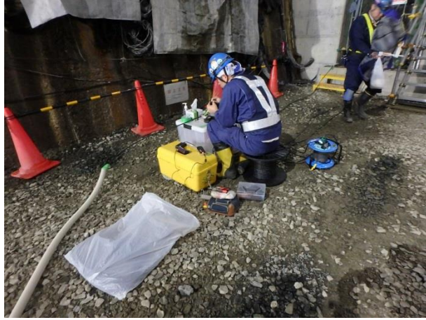
写真 3.5-20 融着接続作業（ピット付近）
