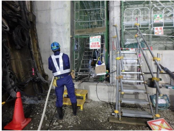
写真 3.5-21 ケーブル配線作業（ピット下部）
