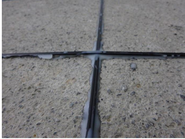
写真 3.5-9 設置後センサー（交差部；上部）
