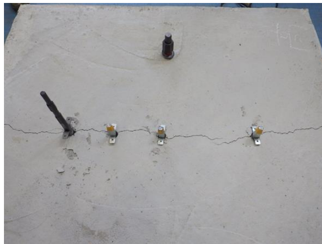
図 2.5-41 ひび割れの発生状況 (①～④貫入後)
