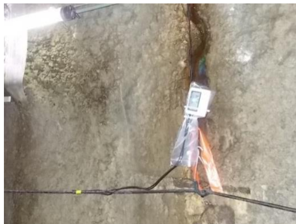
写真 3.5-33 温度計設置状況 (坑道沿い)
