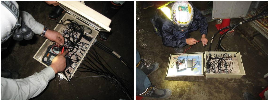
図 4.1-103 接続ボックス地点におけるケーブル点検状況
