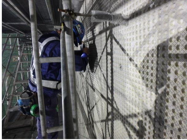
写真 3.5-11 センサー仮止め作業（手前）
