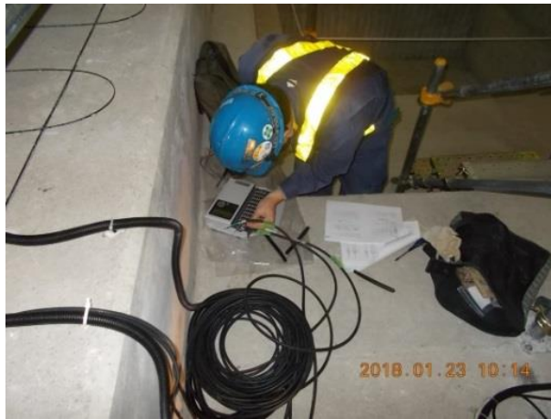
写真 3.5-25 データロガーへの接続作業（上部）
