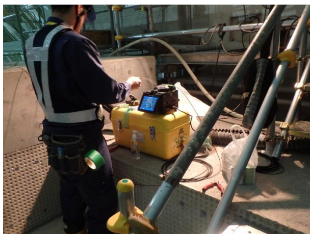
写真 3.5-16 融着接続作業（ピット）
