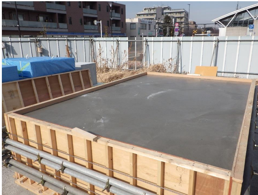
図 3.5-62 鉄筋コンクリート試験体打設完了
