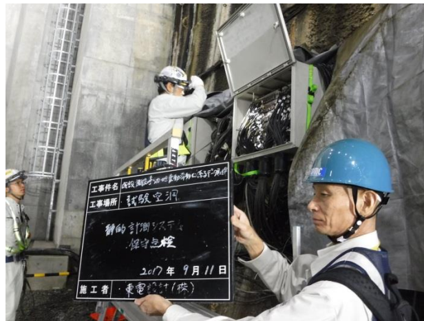
図 4.1-104 スwitchボックスでの模擬入力状況
