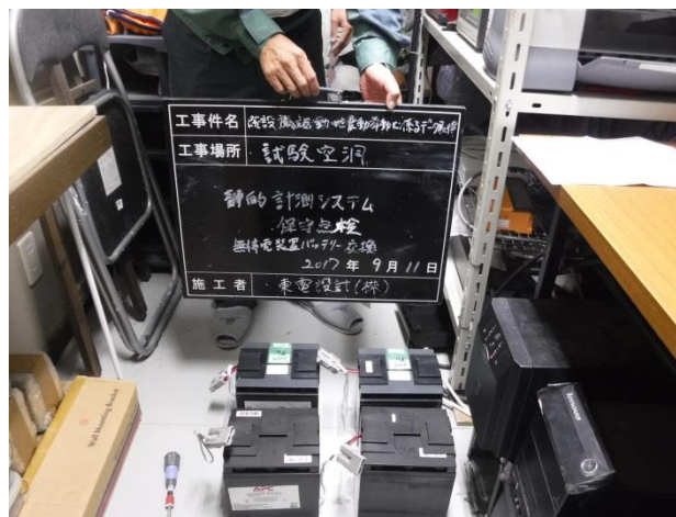
図 4.1-105 無停電装置の交換
