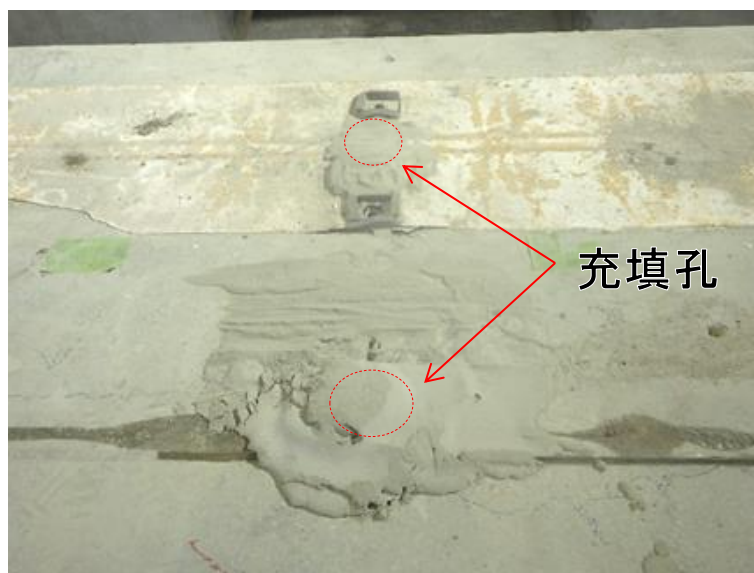
図 2.5-20 静的破砕剤充填箇所の状況(1/2)
