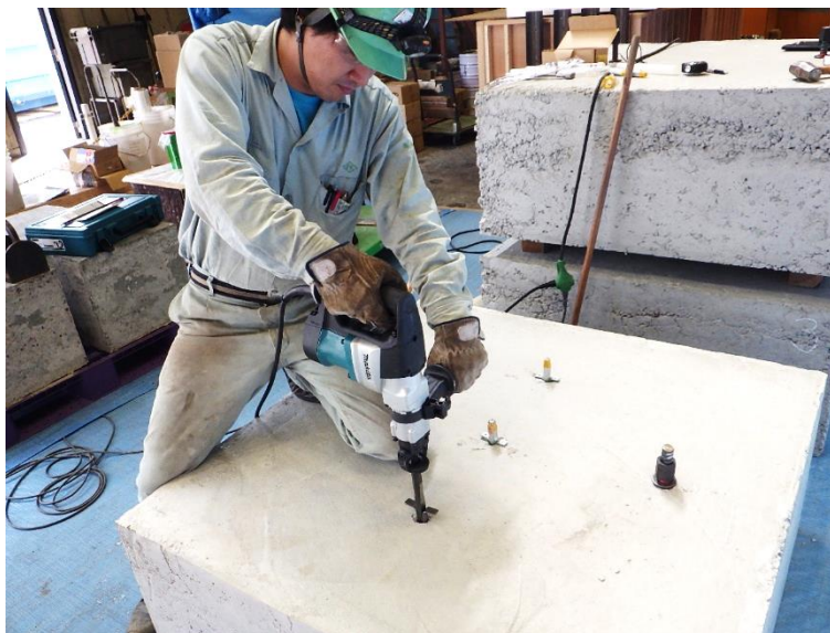
図 2.5-38 電動セリ矢の貫入状況
