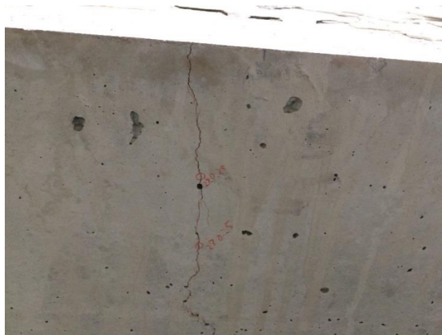
図 2.5-28 供試体中央部側面のひび割れの発生状況 (2/2)
