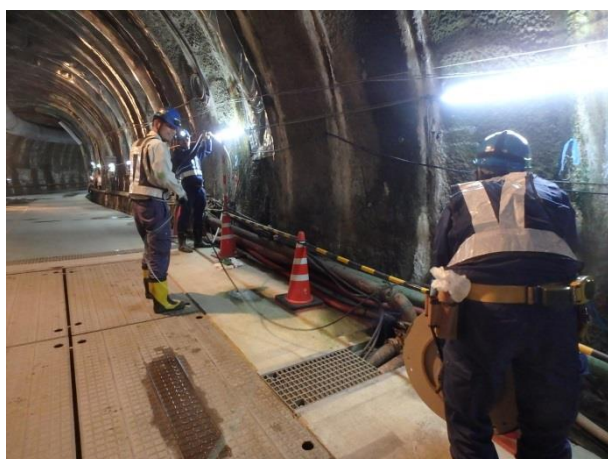
写真 3.5-17 ケーブル配線作業（計測小屋付近）
