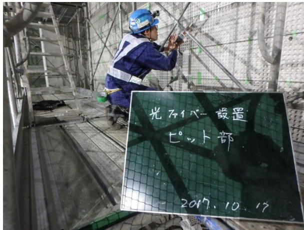
写真 3.5-12 センサー設置作業（手前）
