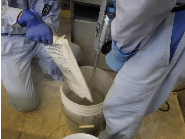
図 2.5-17 静的破碎剤の練混ぜ状況
