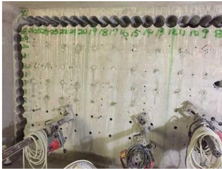
図 2.5-29 静的破砕剤を用いた解体工事の施工状況
