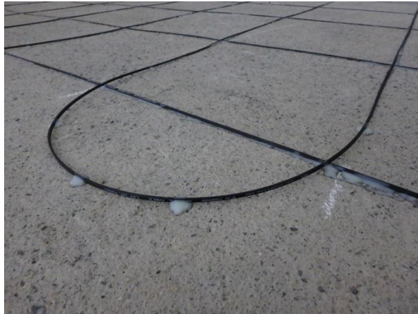
写真 3.5-10 設置後センサー（折り返し部；上部）
