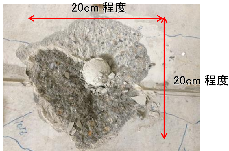
図 2.5-21 静的破砕剤充填箇所状況(2/2)
