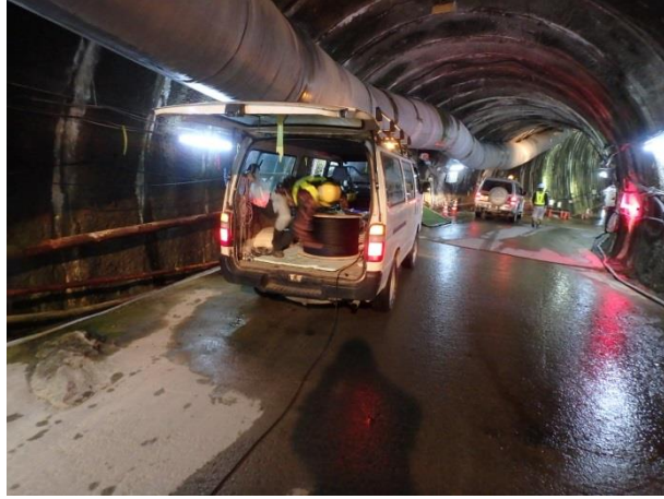
写真 3.5-28 温度計測用光ケーブル配線作業
