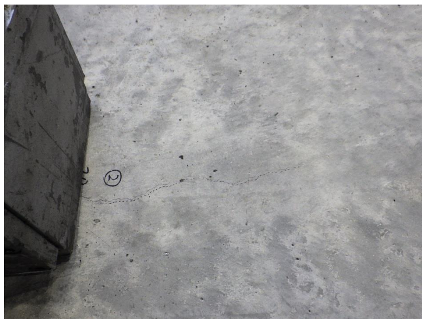
図 2.5-94 鉄筋コンクリート試験体ひび割れ発生状況 (①拡張後 1/2)
