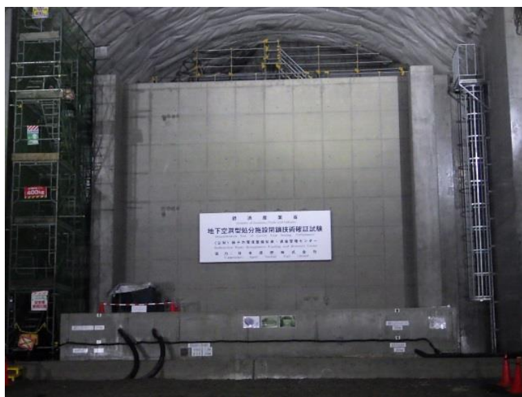
図 3.5-32 手前部コンクリートピット (2017年8月撮影)
