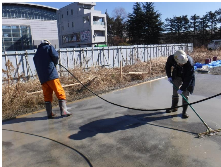
図 3.5-51 打継面処理状況
