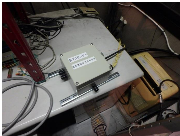
写真 3.5-22 端子箱（計測小屋）
