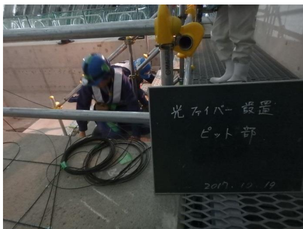
写真 3.5-19 センサー配線作業（上部）
