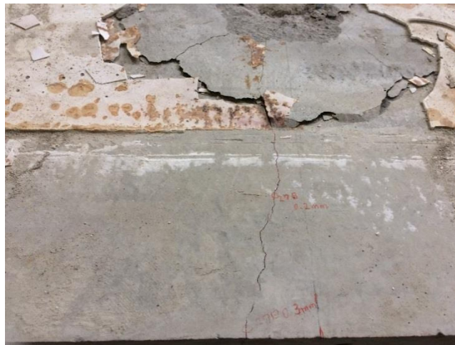
図 2.5-26 供試体中央部上面のひび割れの発生状況
