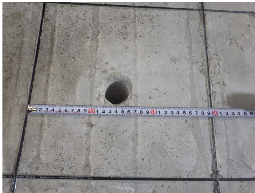
図 2.5-76 削岩機による削孔仕上がり状況
