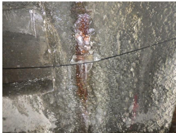
写真 3.5-34 温度計測用光ケーブルの凍結状況（坑道沿い）
