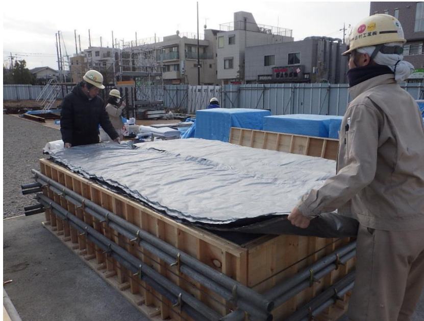
図 3.5-65 保温養生マット敷設状況
