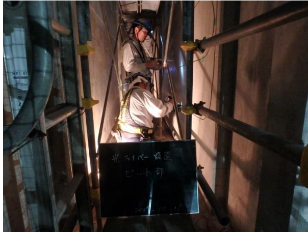
写真 3.5-4 センサー設置作業（側部）
