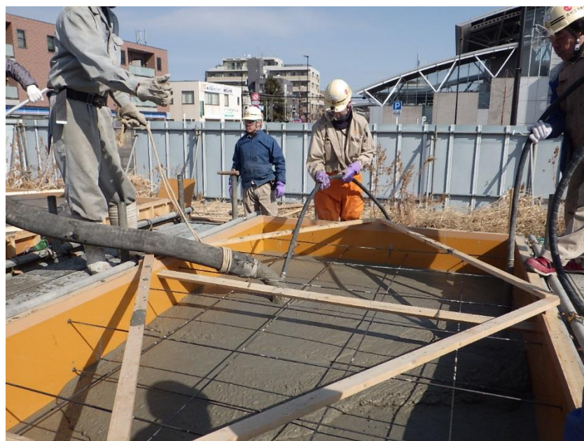
図 3.5-60 無筋コンクリート試験体打設状況
