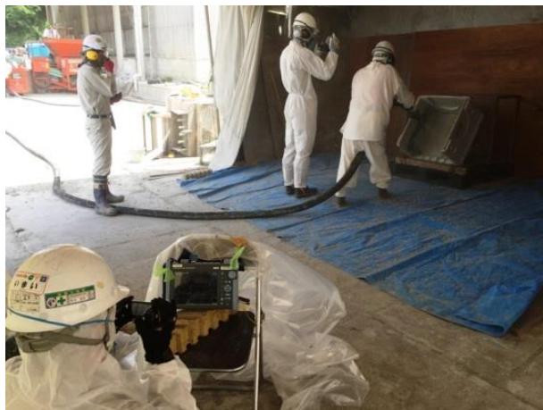
図 2.4-19 吹付施工
