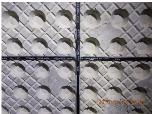
写真 3.5-13 設置後センサー近影（手前）
