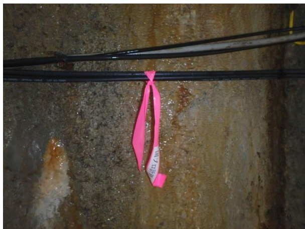
写真 3.5-30 配線後の温度計測用光ケーブル
