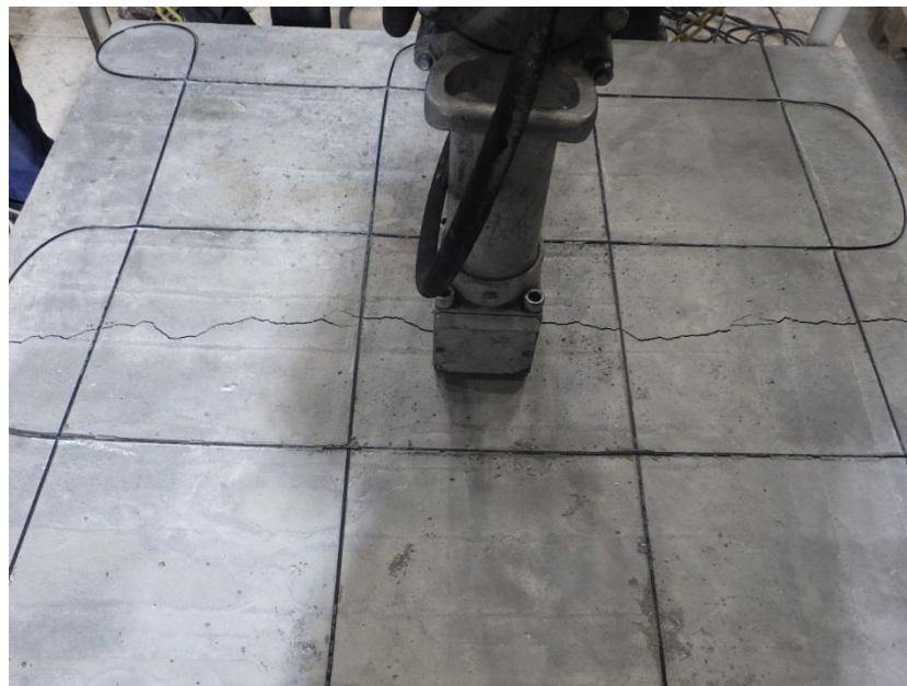
図 2.5-91 ひび割れ発生状況 (2mm 以上)
