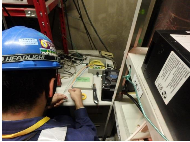
写真 3.5-31 端部処理（計測小屋）
