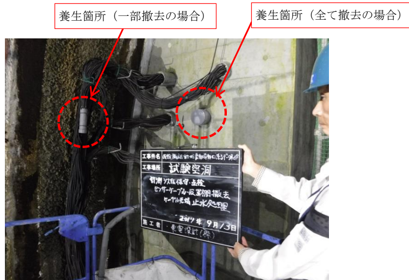
図 4.1-110 ケーブル先端の養生状況
