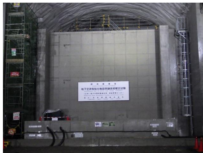
図 2.5-4 手前部コンクリートピット (2017年8月撮影)
