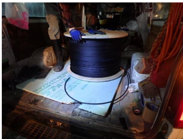
写真 3.5-27 温度計測用光ケーブル
