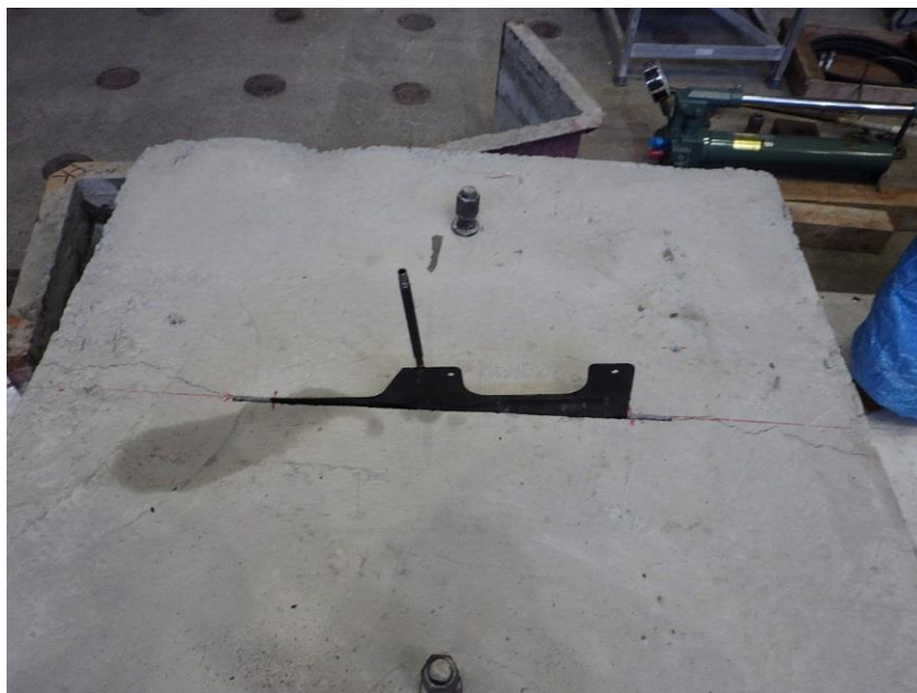
図 2.5-59 試験体①のひび割れ発生状況 (1/3)
