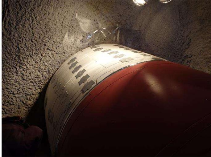
図 2.2.4-10 疑似 PEM 設置状況（発砲スチロール組立終了）
