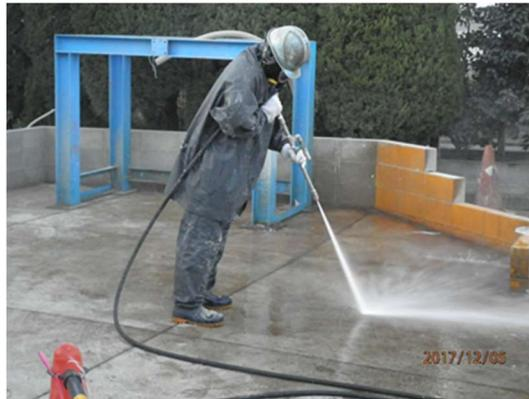
図 5.1.3-1 ジェット噴流（直射ノズル、水圧 20MPa）
