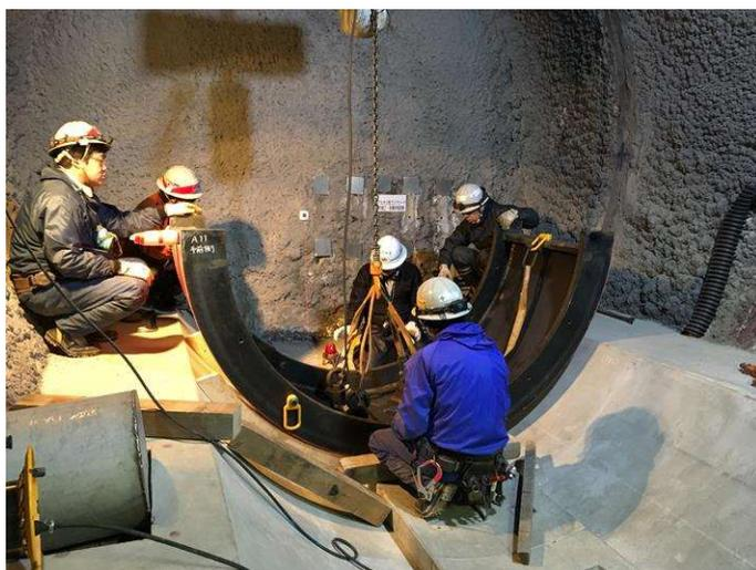
図 2.2.4-5 模擬 PEM 設置状況（A11 設置）
