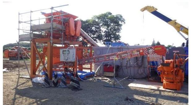
(h) 含水比調整後 吹付け機に投入
