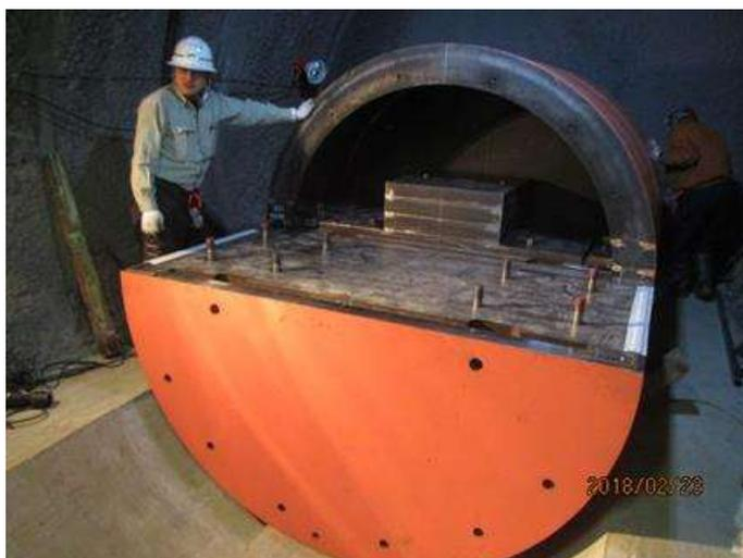
図 2.2.4-7 模擬 PEM 設置状況 (A21 設置)
