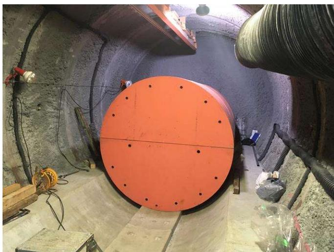
図 2.2.4-8 模擬 PEM 設置状況 (C23 設置)
