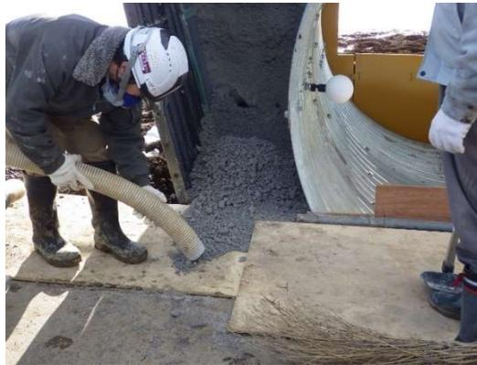
図 4.3.7-23 リバウンド材回収の様子
