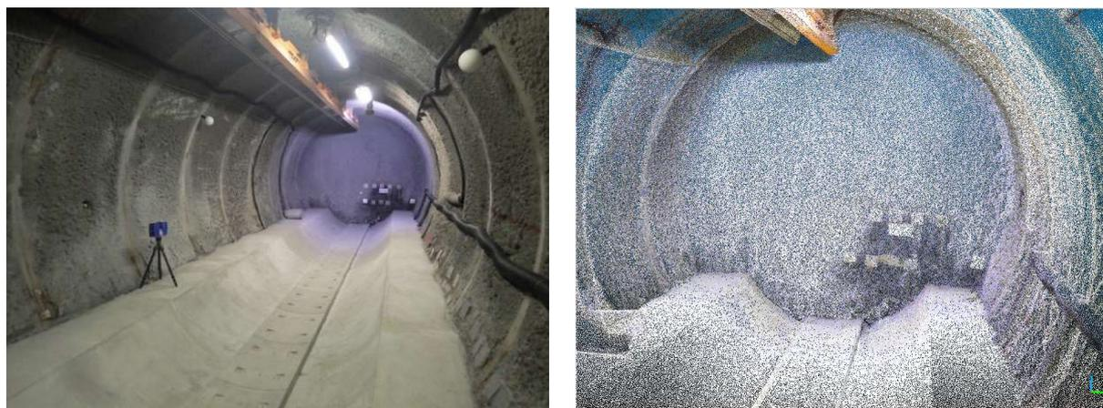
図 2.2.2-1 3D レーザースキャナによる試験坑道2の内空形状の取得
