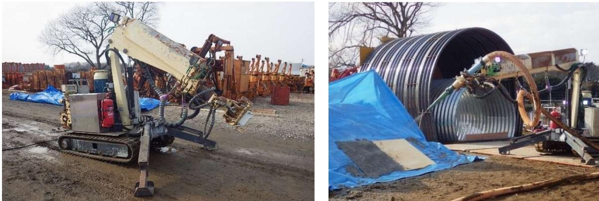
図 2.4.3-7 伸縮アームを有する吹付装置による吹付け施工試験
