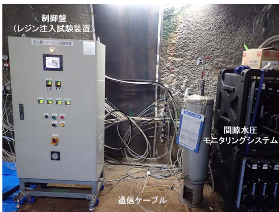
図 4.3.3-2 レジン注入試験装置の制御盤とモニタリングシステムへの接続
