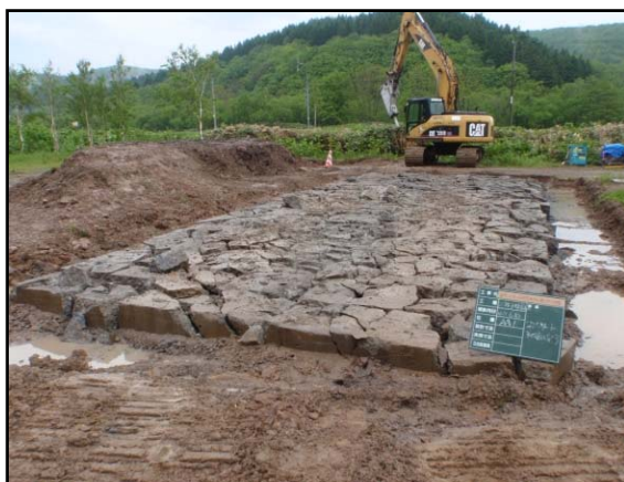
図 5.4.1-7 コンクリート基礎破砕状況(2)
