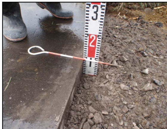
図 5.4.2-6 舗装厚測定状況(2)
