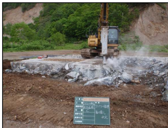
図 5.4.1-8 セーラー部破砕状況(1)
