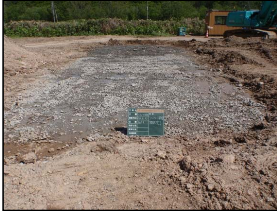
図 5.4.3-2 準備作業完了状況
