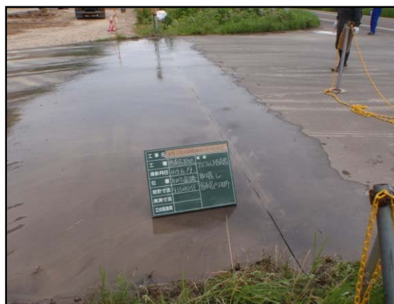
図 5.4.2-4 舗装切断作業状況(2)
