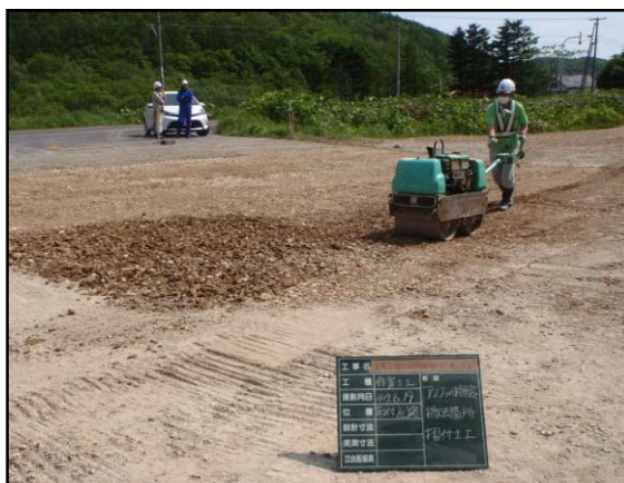
図 5.4.2-9 摺付箇所転圧状況(1)
