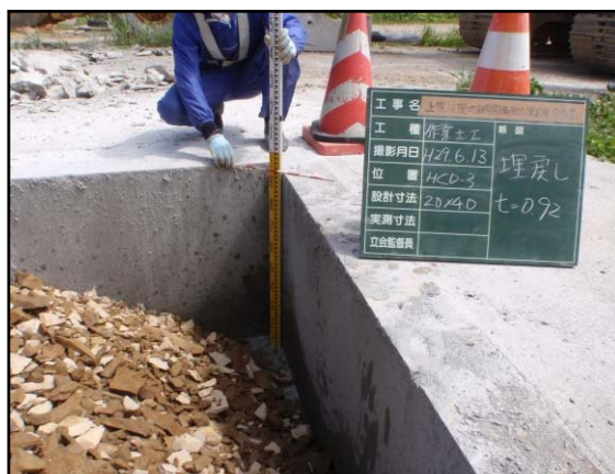
図 5.3.2-12 埋め戻し状況
