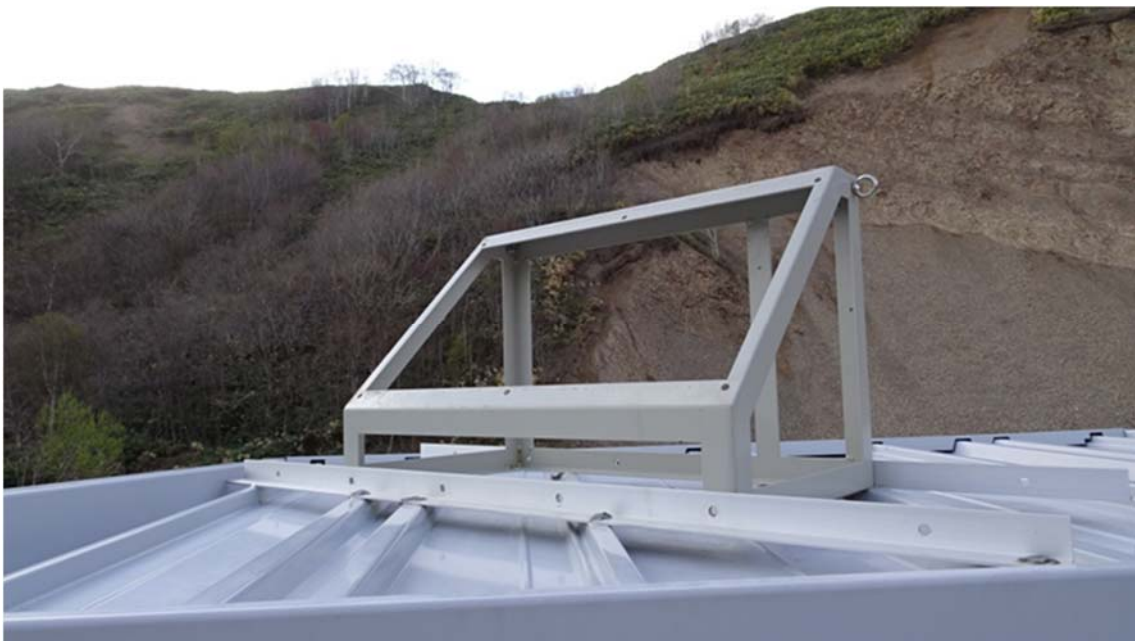
図 5.1.5-2 既存小屋上部 (太陽光パネルのみ取り外し後)
