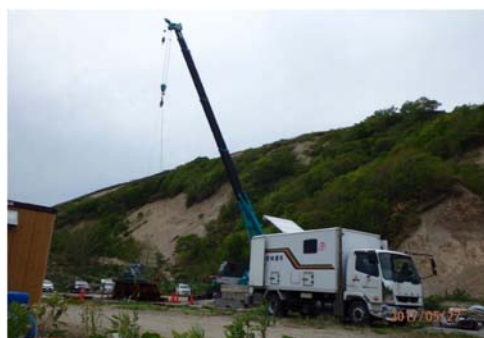
図 5.3.2-1 キャリパー検層測定状況
