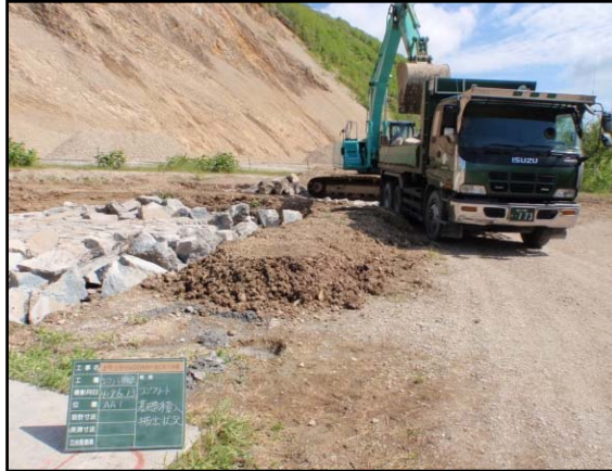
図 5.4.1-12 コンクリート塊積込状況(1)
