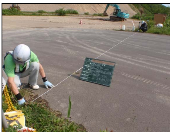
図 5.4.2-1 切断ライン設置作業状況 (1)
