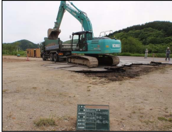
図 5.4.2-7 アスファルト塊積込状況
