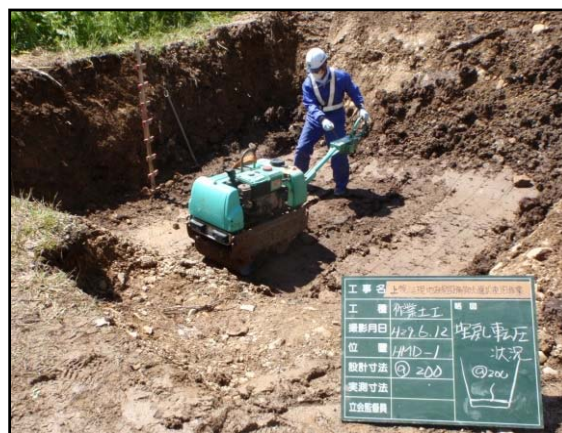
図 5.3.3-11 埋め戻し状況（転圧）
