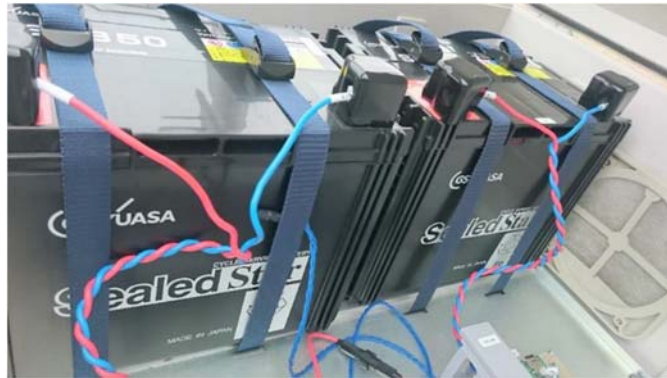
図 5.1.2-4 バッテリー周辺
