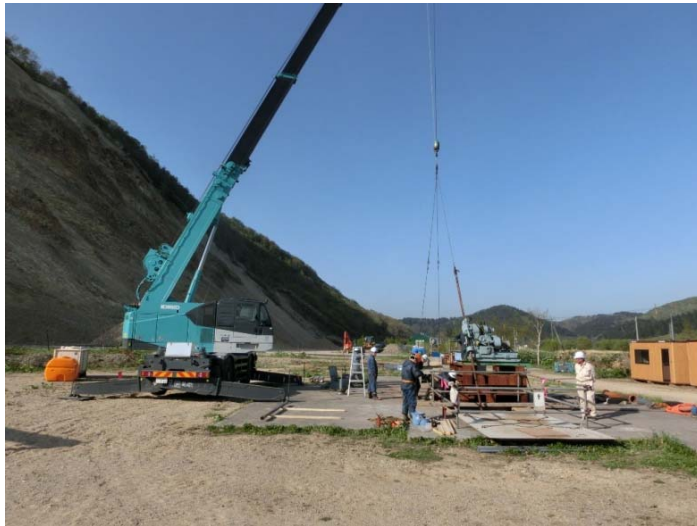
図 5.2.3-10 モニタリングシステム回収状況③
