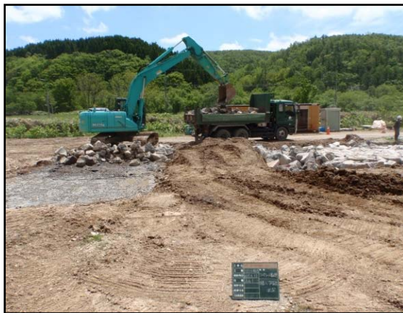
図 5.4.1-13 コンクリート塊積込状況(2)
