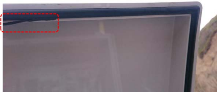
図 5.1.2-8 ケース B 蓋パッキン
