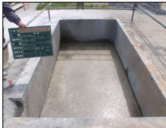
図 5.3.2-11 コンクリート打設完了状況
