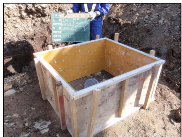
図 5.3.3-8 鉄板溶接した孔口と型枠設置状況
