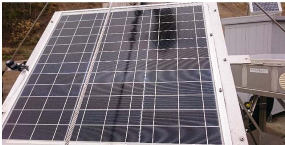
図 5.1.7-3 太陽光パネル
