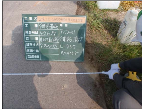
図 5.4.2-2 切断ライン設置作業状況(2)
