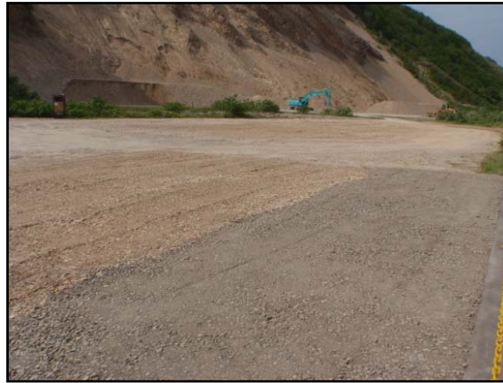
図 5.4.3-5 整地作業完了状況(1)
