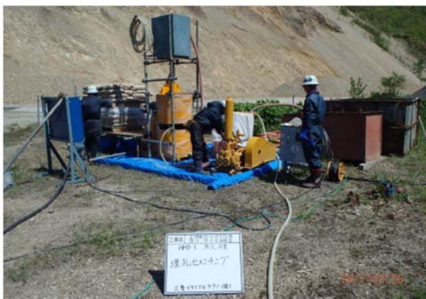
図 5.3.3-1 セメントスラリー注入状況
