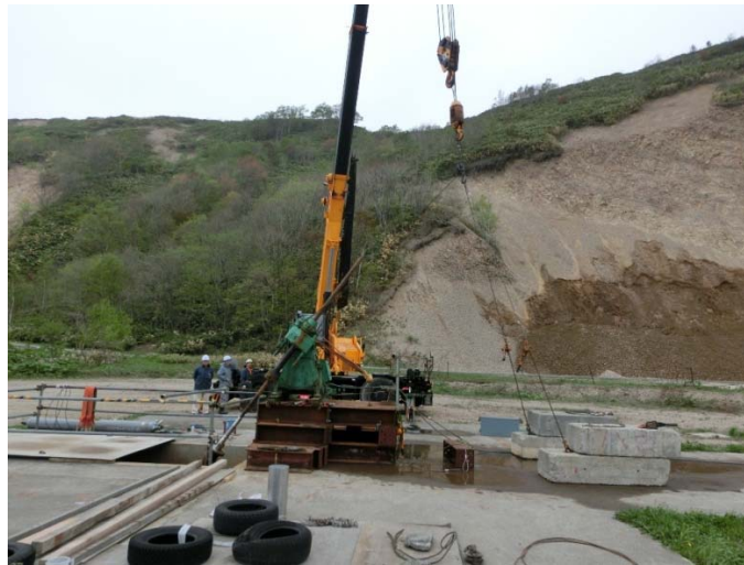
図 5.2.3-7 モニタリングシステム回収状況（全景）
