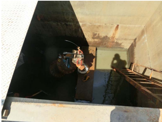
図 5.2.3-12 立ち上げ管回収後の坑口状況
