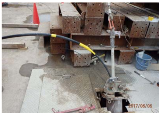
図 5.3.2-5 プラグパッカー設置状況
