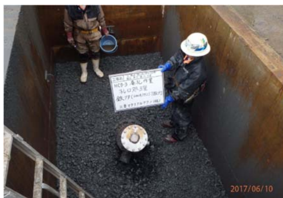
図 5.3.2-9 碎石投入完了状況
