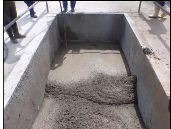
図 5.3.2-10 コンクリートによる埋孔状況
