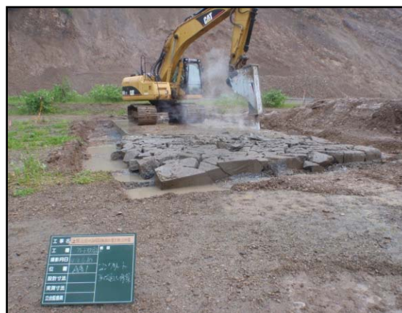
図 5.4.1-6 コンクリート基礎破碎状況(1)
