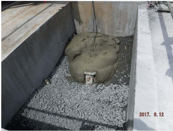
図 5.3.2-10 コンクリートによる埋孔状況
