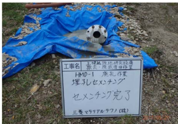
図 5.3.3-3 セメンチング完了状況
