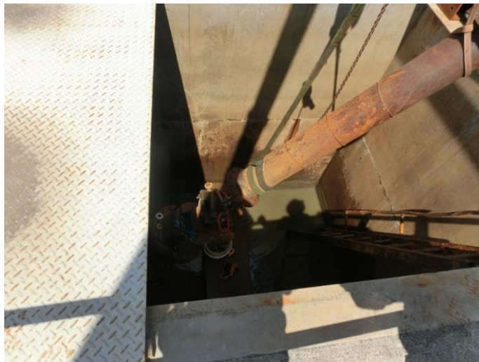
図 5.2.3-11 立ち上げ管回収状況
