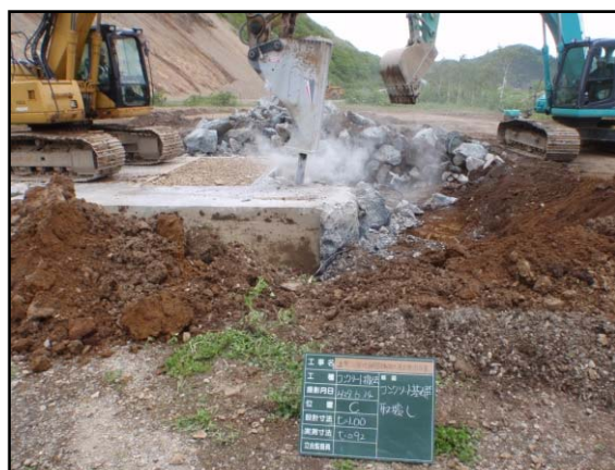
図 5.4.1-9 セーラー部破砕状況(2)
