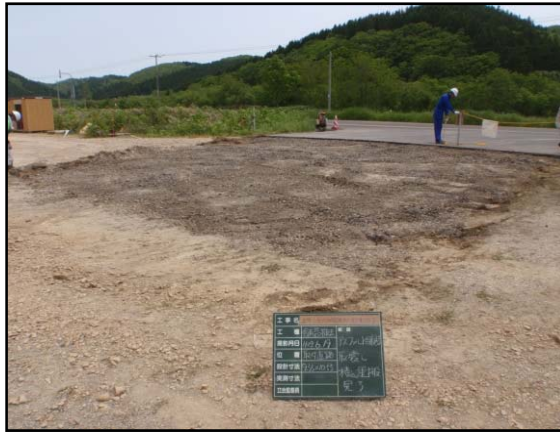
図 5.4.2-8 アスファルト撤去作業完了状況
