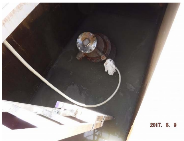
図 5.3.2-7 高圧セメンチング実施状況（HCD-3 孔）
