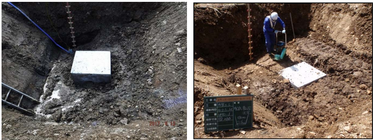
図 5.3.3-10 HMD-1 孔口コンクリート被覆、埋戻し状況
