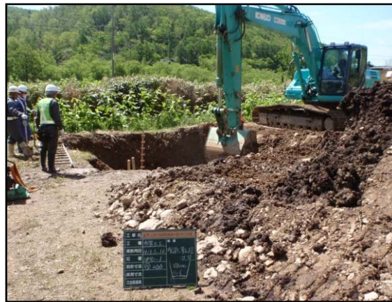
図 5.3.3-9 埋め戻し状況
