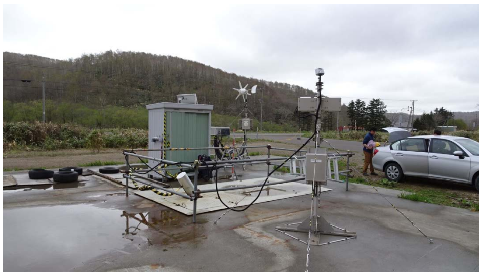
図 5.1.1-2 無人計測システム撤去作業前全景
