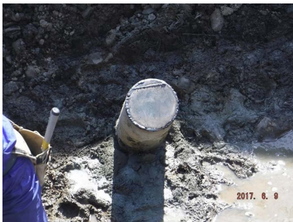
図 5.3.3-8 鉄板溶接した孔口と型枠設置状況
