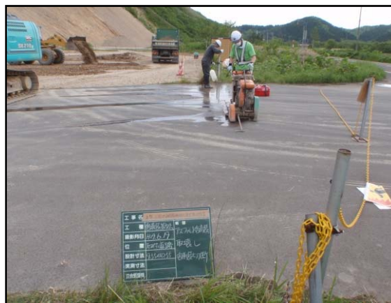
図 5.4.2-3 舗装切断作業状況(1)
