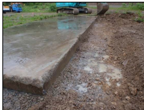
図 5.4.1-4 コンクリート基礎周辺掘削状況
