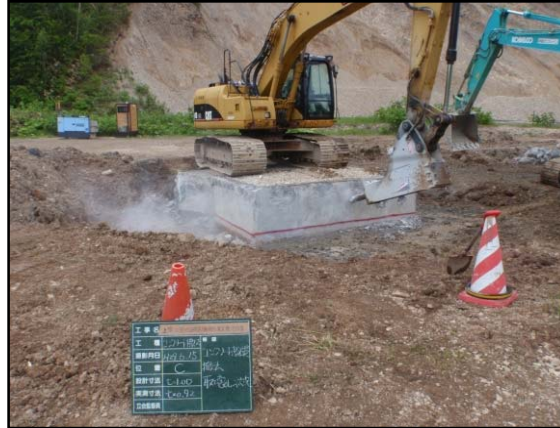
図 5.4.1-10 セーラー部破碎状況 (3)
