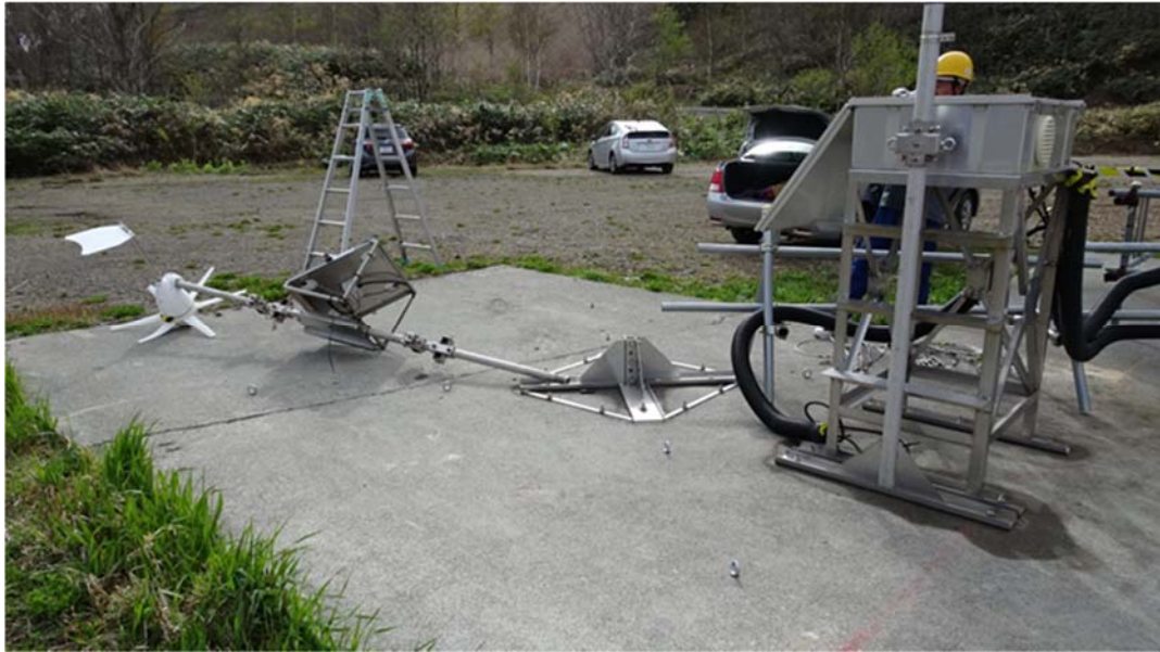
図 5.1.4-2 風力・太陽光ポール（ポール倒し作業後）
