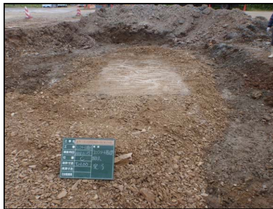
図 5.4.1-11 セーラー部破碎完了状況
