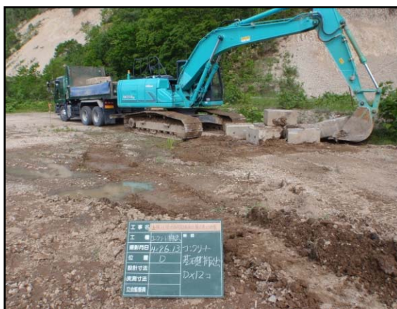
図 5.4.1-14 コンクリート塊積込状況(3)
