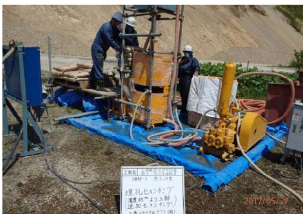
図 5.3.3-2 追加セメントスラリー注入状況
