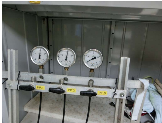
図 5.2.3-4 パッカー収縮作業状況②
