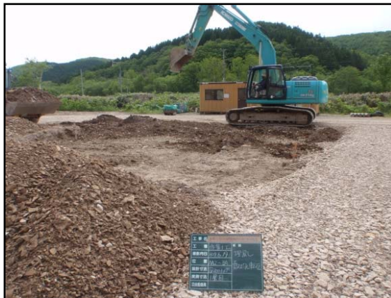
図 5.4.3-3 埋戻し作業状況
