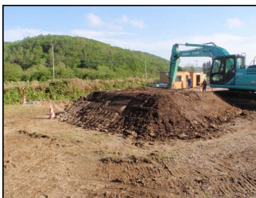
図 5.3.3-5 掘削土一時仮置き状況
