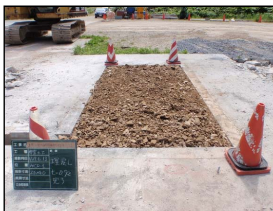
図 5.3.2-13 埋め戻し完了状況
