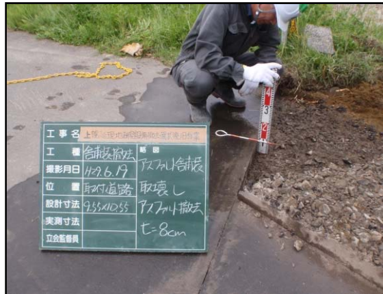
図 5.4.2-5 舗装厚測定状況(1)
