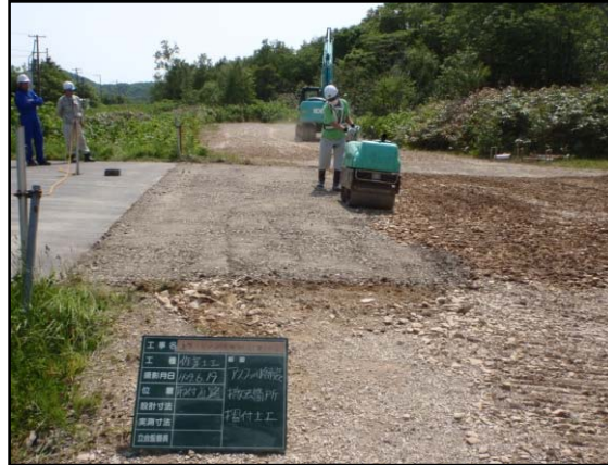
図 5.4.2-10 摺付箇所転圧状況 (2)
