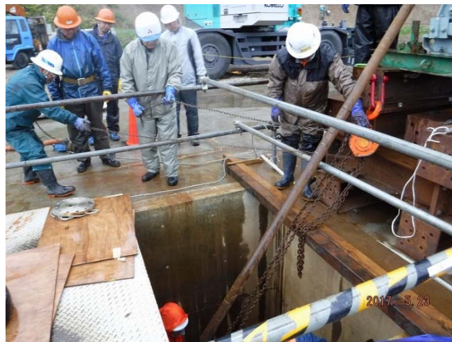
図 5.2.3-13 モニタリングシステム回収状況（パッカー⑤強引）
