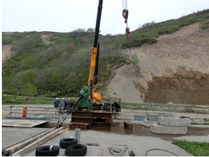
図 5.2.3-9 モニタリングシステム回収状況②
