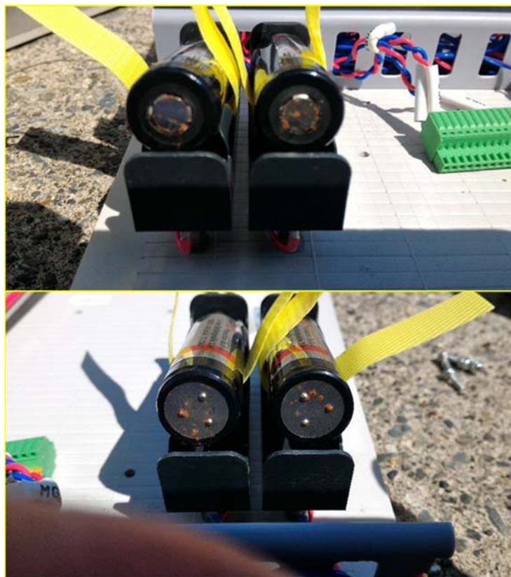
図 5.1.3-6 バッテリー部腐食状況
