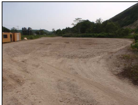
図 5.4.3-6 整地作業完了状況(2)
