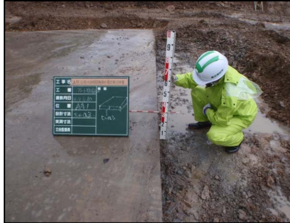
図 5.4.1-5 コンクリート基礎厚測定状況
