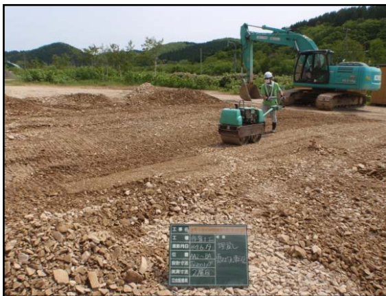
図 5.4.3-4 転圧作業状況
