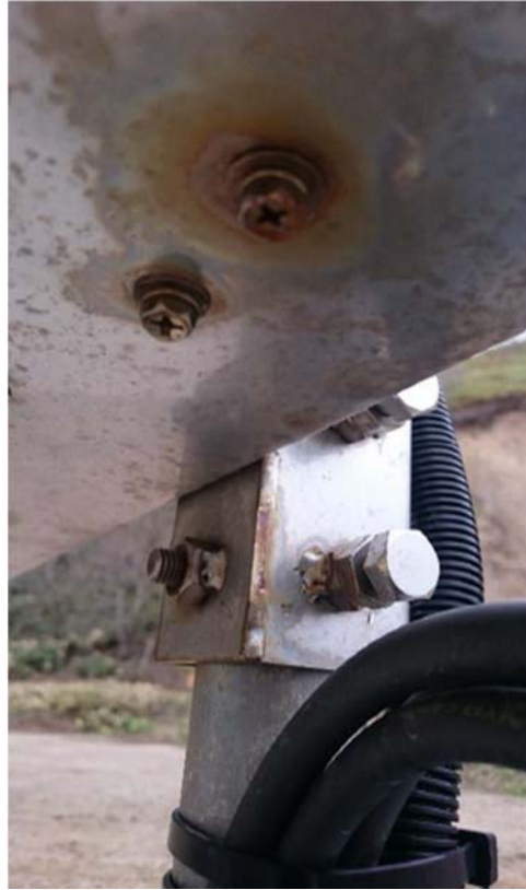
図 5.1.9-2 ステンレス設備外装（代表：太陽光設置角検証用）
