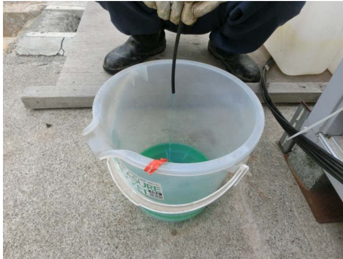
図 5.2.3-3 パッカー収縮作業状況①
