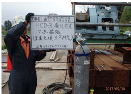
図 5.3.2-6 プラグパッカー拡張状況
