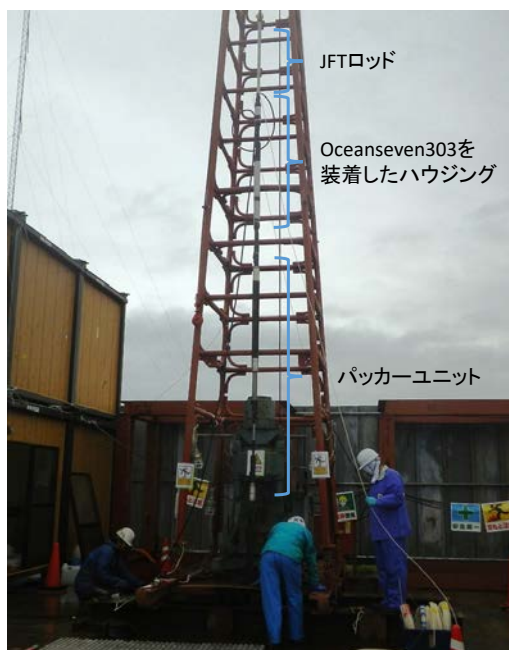
図 3-7 孔内への挿入状況
