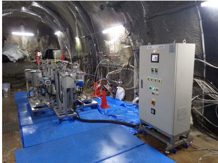
図 5.3.2-1 原位置レジンを注入試験装置
