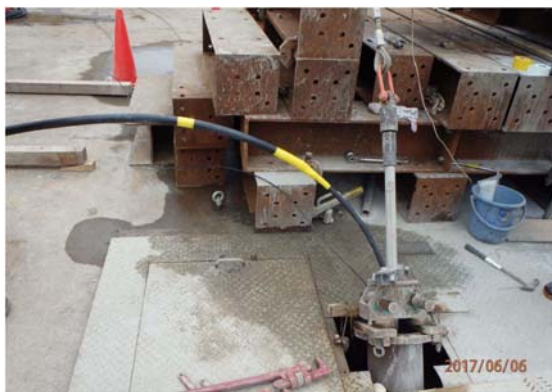
図 5.2-22 プラグパッカー設置・拡張状況
