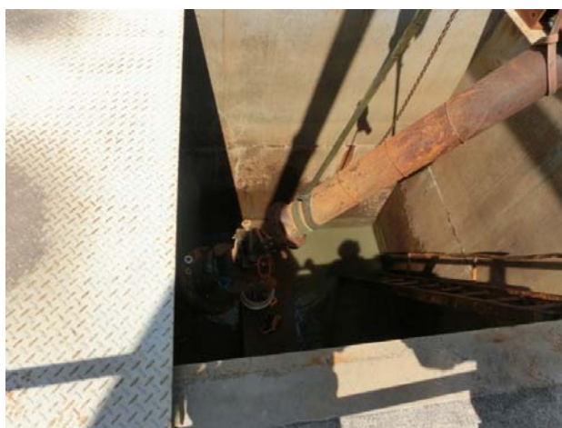
図 5.2-7 立ち上げ管回収状況
