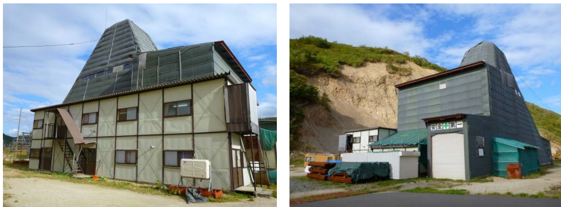
図 5.1-3 現場事務所（組立式プレハブハウス）及び防寒施設
