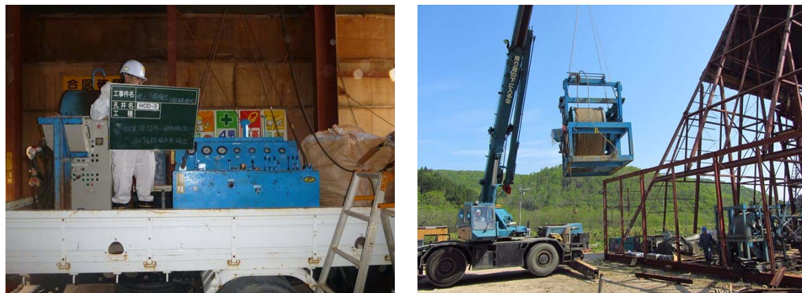
図 5.1-7 試錐機操作盤・掘削用アーマードケーブルウィンチ搬出状況
