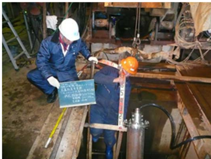
図 3.4-13 孔内モニタリングシステム設置完了
