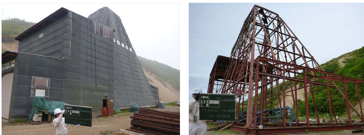
図 5.1-5 外装シート取り外し前と取り外し後
