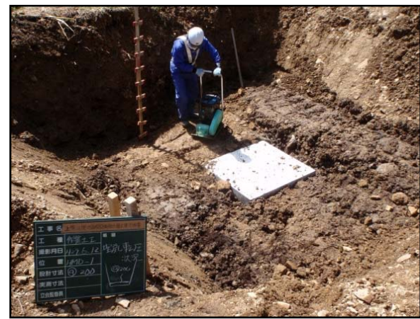
図 5.2-28 HMD-1 孔口コンクリート被覆、埋戻し状況
