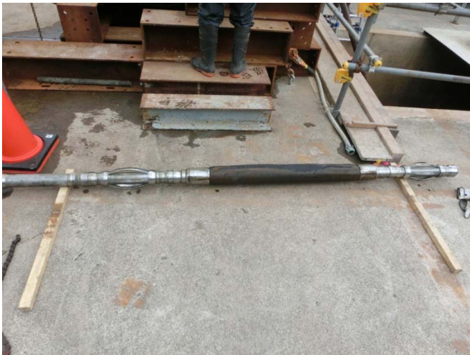
図 5.2-13 回収したパッカー (パッカー③)
