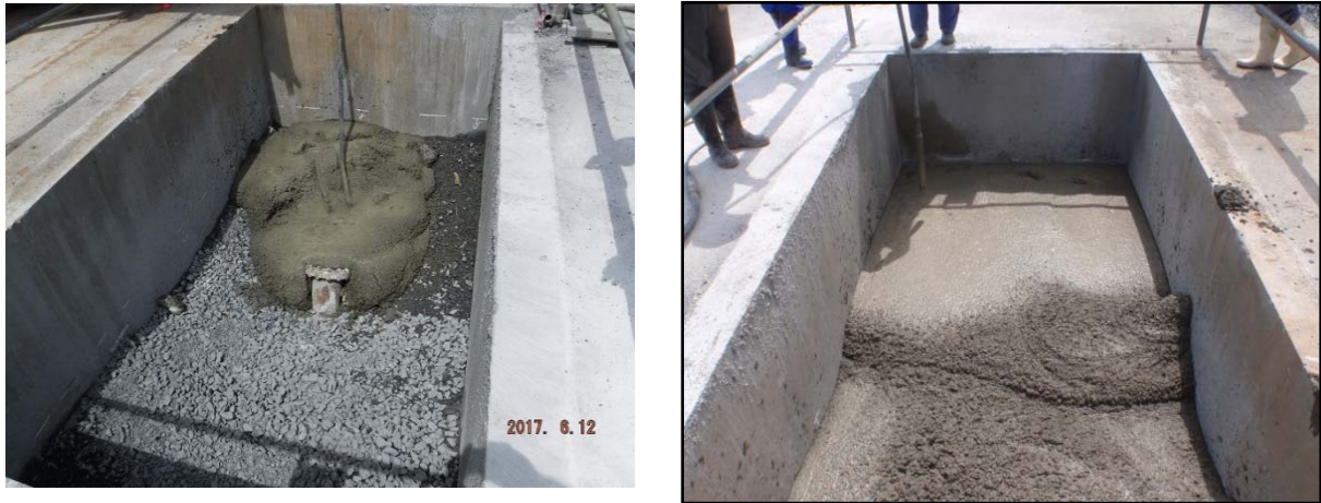
図 5.2-24 コンクリートによる埋孔状況
