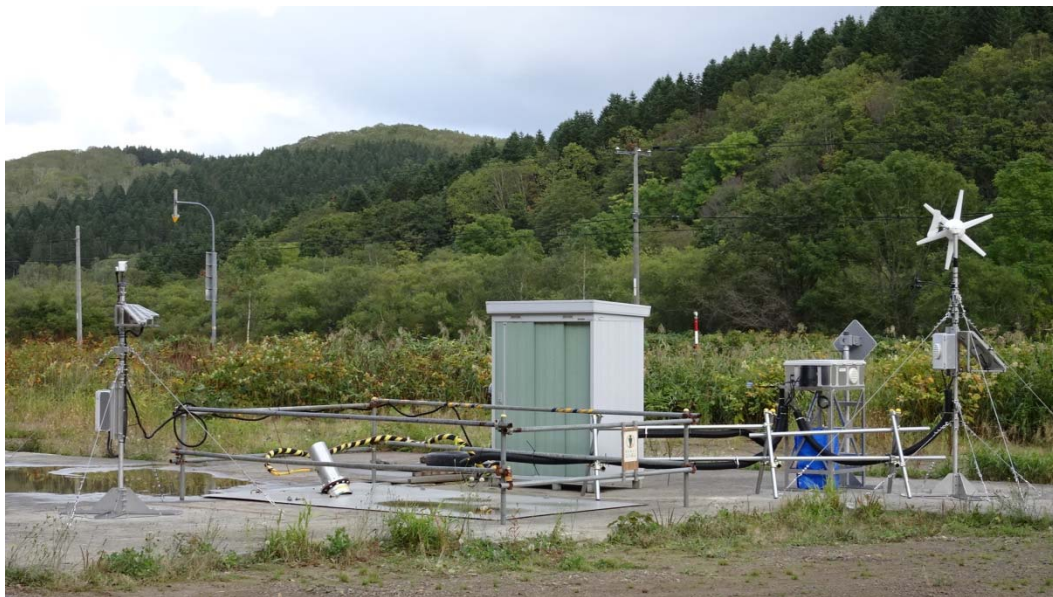
図 3.5-7 無人計測システム現地据付後の状況 (HCD-3 孔)
