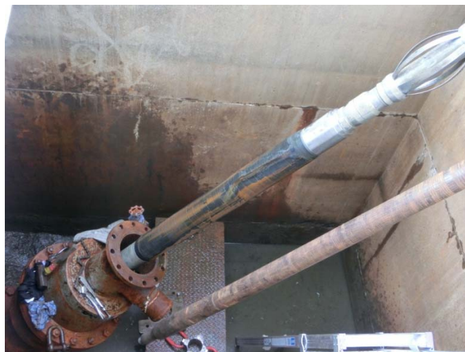
図 5.2-10 バッカー回収状況
