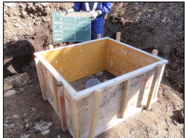
図 5.2-27 鉄板溶接した孔口とセメントスラリー被覆準備 (型枠設置)
