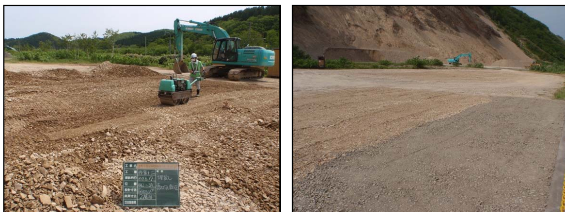
図 5.2-30 埋戻し・転圧作業状況ならびに整地作業完了状況
