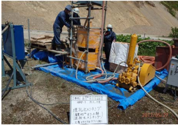
図 5.2-26 セメンチング実施状況 (HMD-1 孔)
