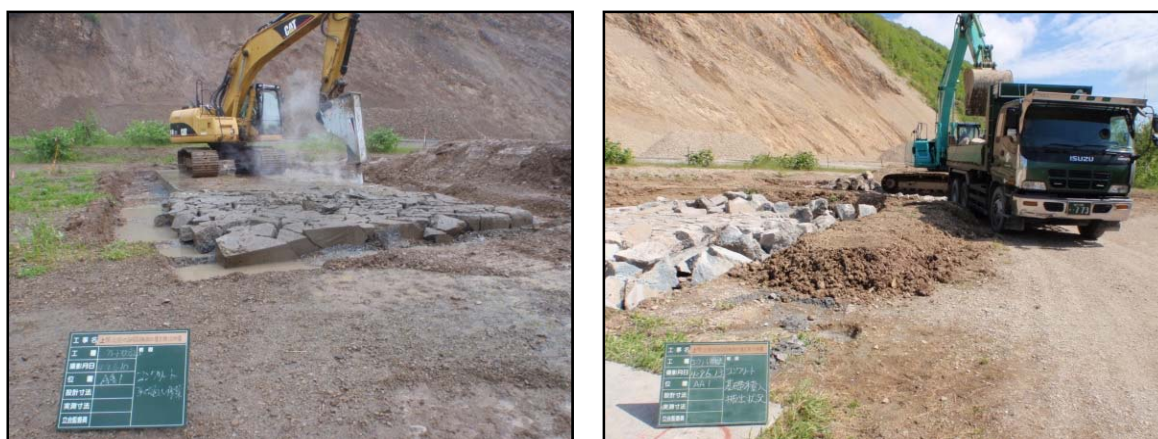
図 5.2-29 コンクリート基礎破碎ならびにコンクリート塊積込・搬出状況
