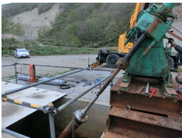
図 5.2-6 モニタリングシステム回収状況①
