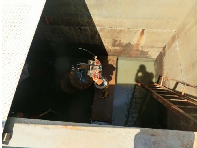
図 5.2-8 立ち上げ管回収後の坑口状況
