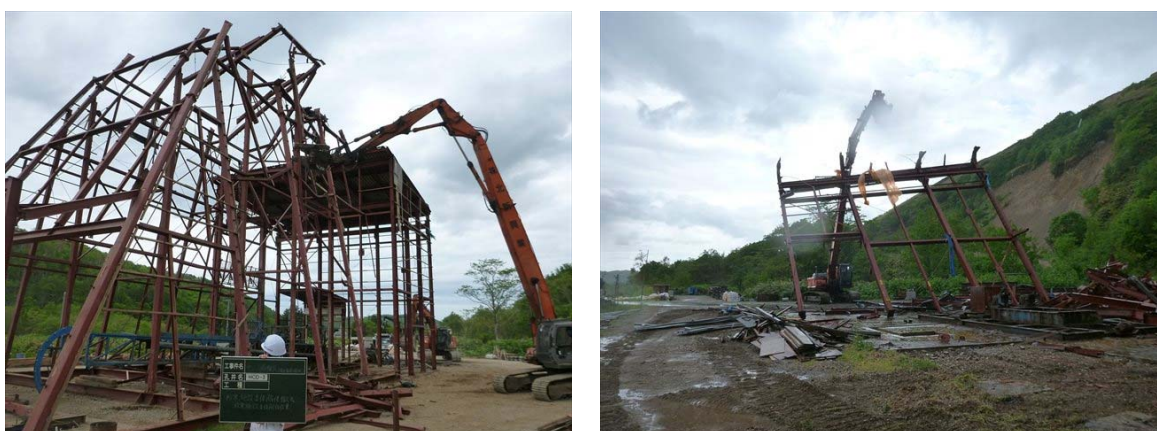
図 5.1-6 防寒施設本体解体作業状況
