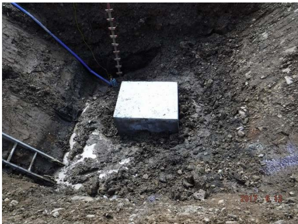
図 5.2-28 HMD-1 孔口コンクリート被覆、埋戻し状況
