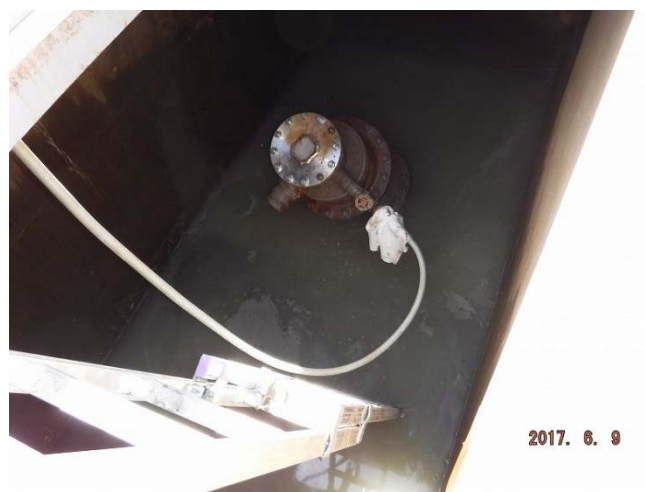
図 5.2-23 高圧セメンチング実施状況（HCD-3 孔）
