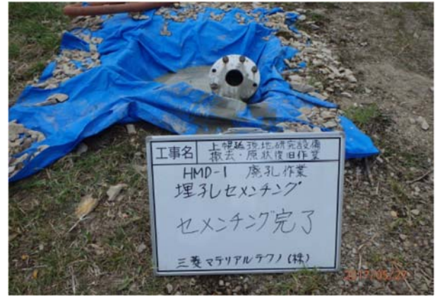
図 5.2-26 セメンチング実施状況 (HMD-1 孔)
