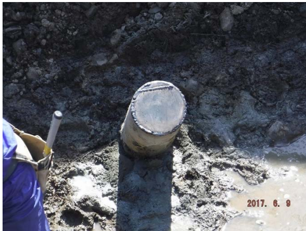
図 5.2-27 鉄板溶接した孔口とセメントスラリー被覆準備 (型枠設置)
