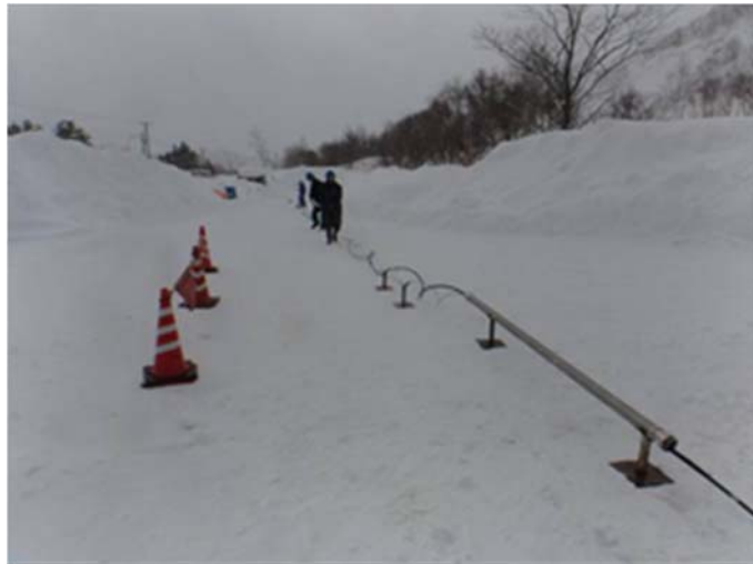
図 3.4-12 設置作業状況(3)
