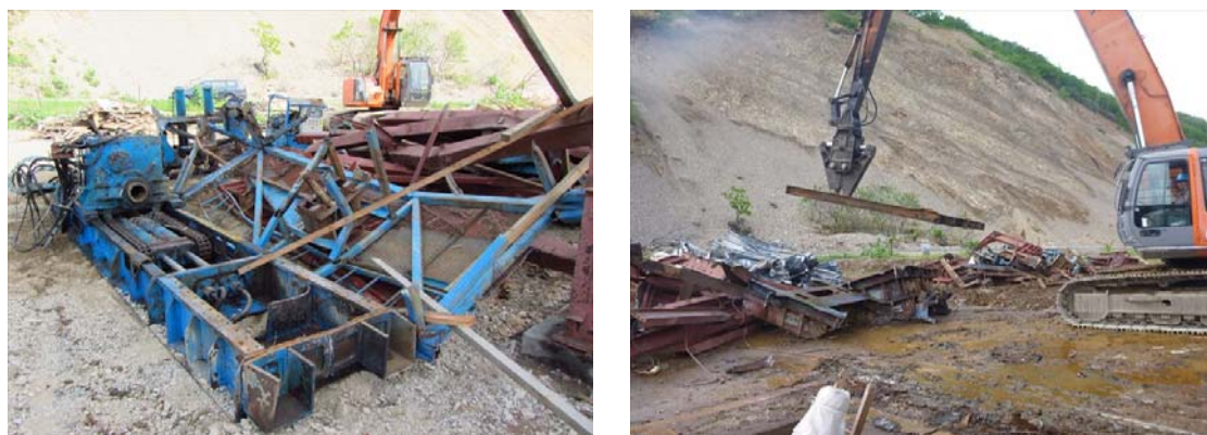
図 5.1-8 試錐機本体・マスト基礎鋼解体撤去状況
