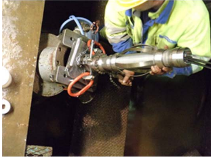
図 3.4-11 設置作業状況(2)
