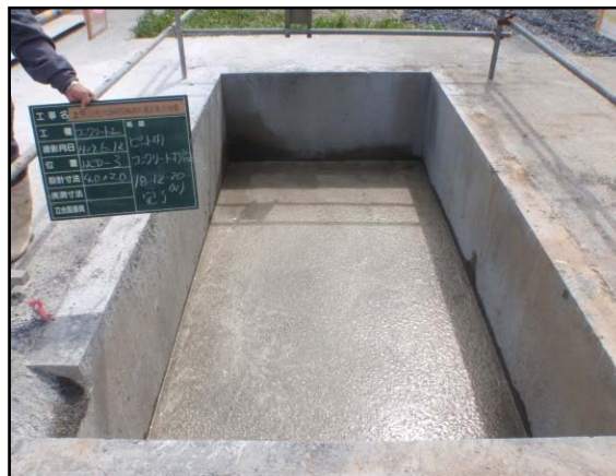
図 5.2-25 コンクリート打設完了状況
