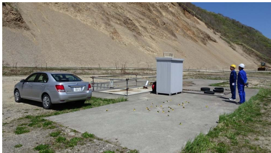
図 5.2-2 無人計測システム撤去作業完了後の全景
