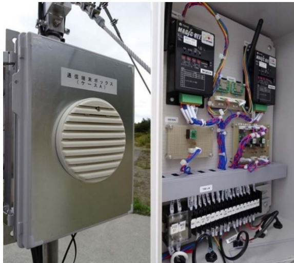
図 4.6-18 ケース A 及びケース A 内部
