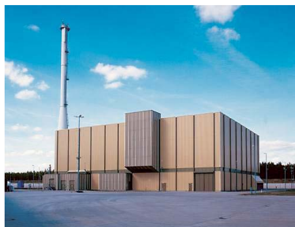
使用済燃料のパイロット・コンディショニング施設
