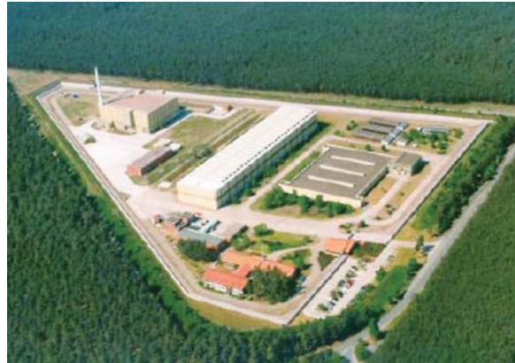
ゴアレーベンの中間貯蔵施設
