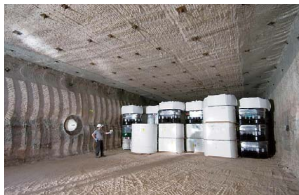
廃棄物隔離パイロットプラント（WIPP）での廃棄物定置状況 （DOE WIPPウェブサイトより引用）
