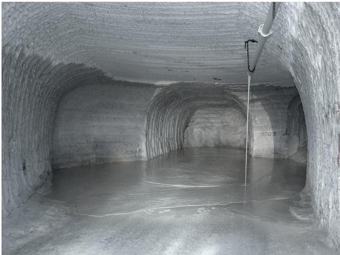
図 8.2-4 アッセ鉱山におけるソーレル・コンクリートによる空洞の埋戻し
