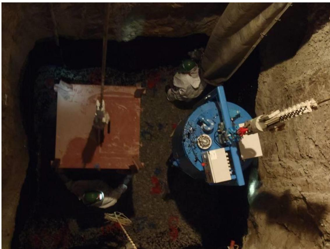
図 8.2-7 ERAM 施設内の大規模試験シーリング材建設中の砂利層へのビチューメンの注入
