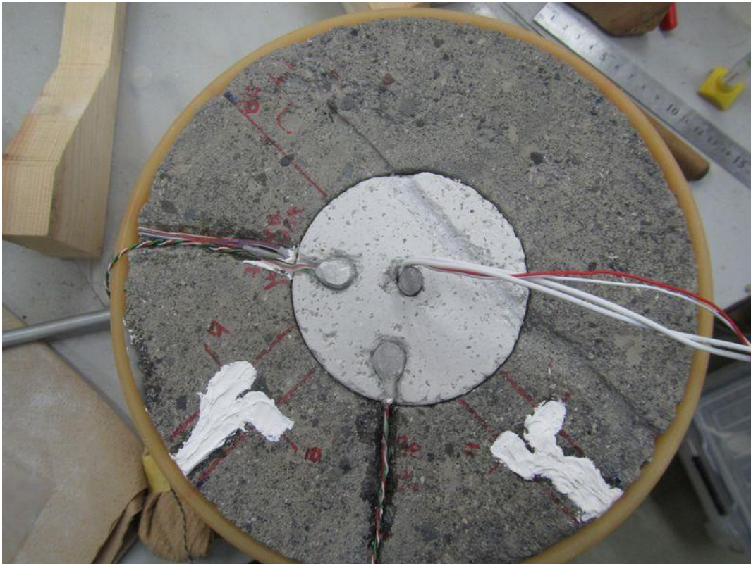
図 4.6.1-31 緩衝材・模擬オーバーパックの処分孔への設置状況
