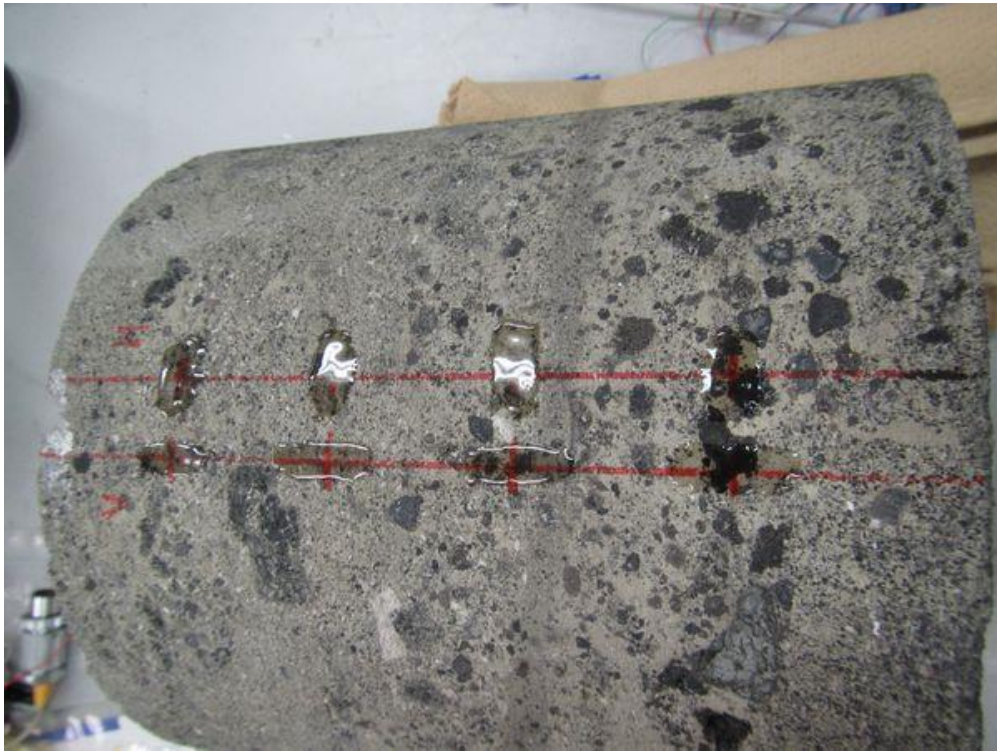
図 4.6.1-23 下地剤塗布状況
