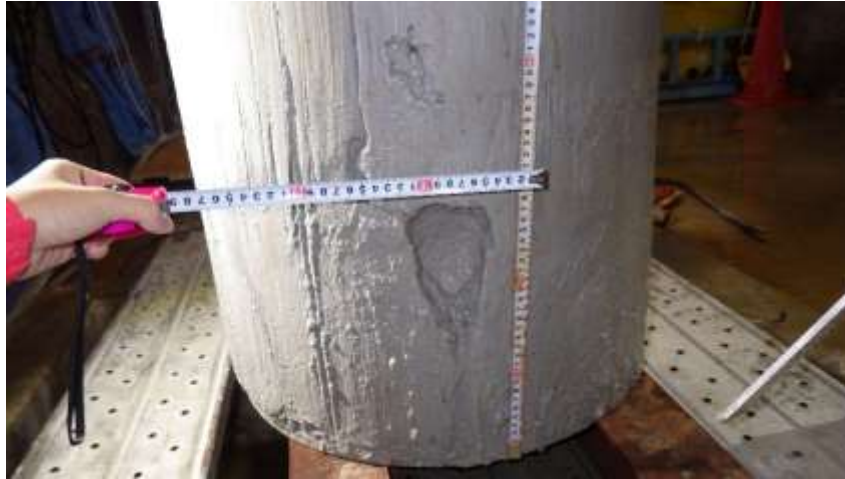
図 5.2.4-7 水みちと見られる箇所寸法の測定
