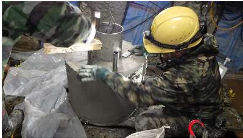
図 5.2.7-9 緩衝材の状態（上から 3 段目）
