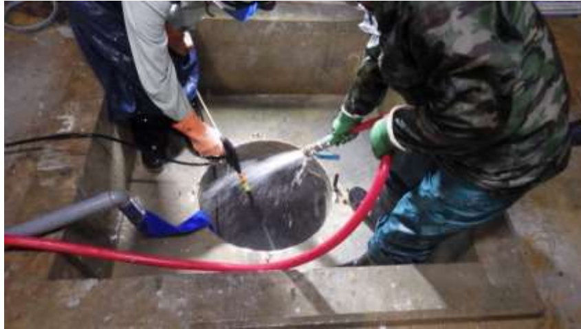
図 5.2.4-13 試験孔内の洗浄状況
