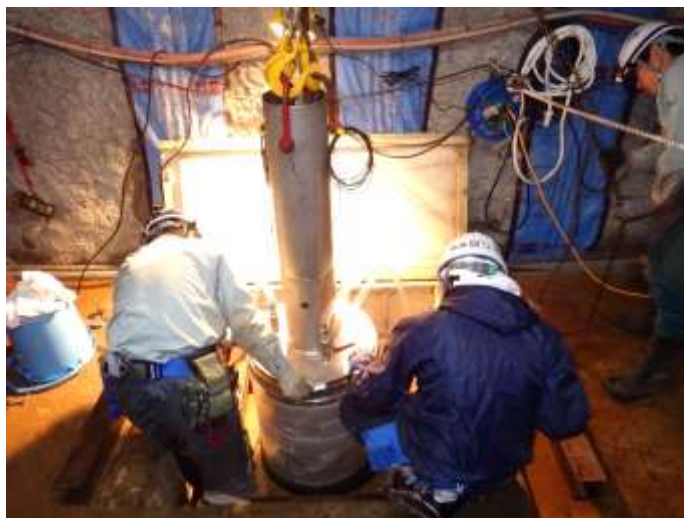
図 5.2.5-5 試験体設置状況
