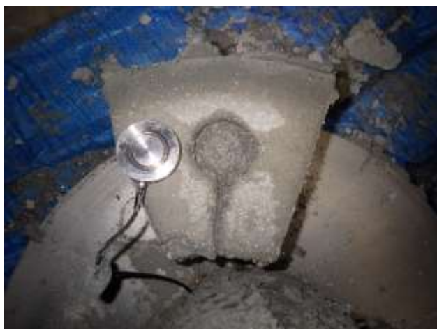
図 5.2.5-15 下部土圧計周辺の浸潤状況
