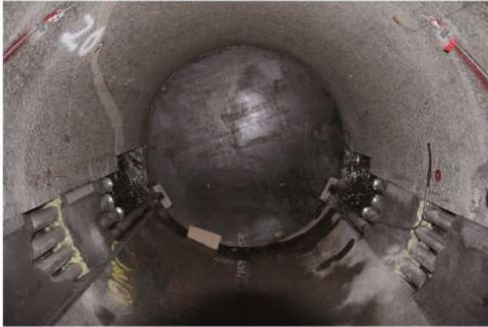
図4-18. 横坑内に設置されたスーパーコンテナ。ケーブルは全て引き込まれた状態となっている。スーパーコンテナが横坑にぴったりと合っている状況を明瞭に見て取れる。定置装置が次の構成要素の設置時にスーパーコンテナを確実に検知できるように、スーパーコンテナの左側の下に小さな紙が置かれている。
