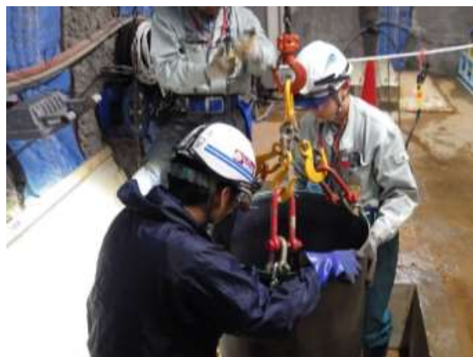
図 5.2.5-4 保護カバー設置状況
