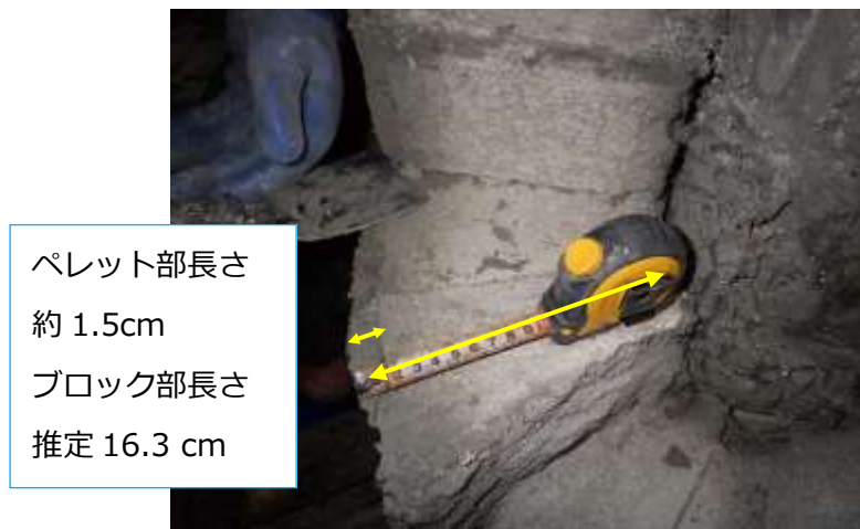
図 5.2.6-7 緩衝材の状態（上から3段目）
