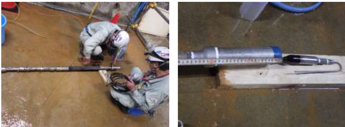
図 5.2.5-1 注水区間水圧計組立状況（左）／ 組立完了（右）
