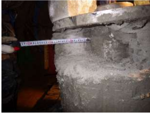
図 5.2.5-13 最上段の緩衝材ブロックの浸潤状況
