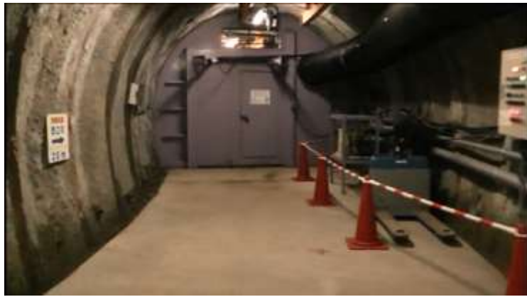
図 3.4.1-4 幌延 URL 350m 西立坑風門 (2016年7月6日撮影)
