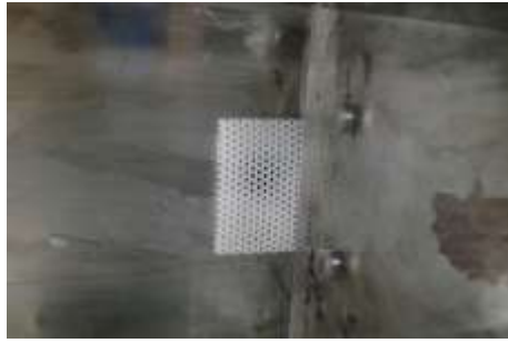
(a)排水穴の養生
