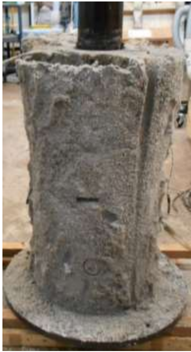
0° (溶接部、隙間側)
