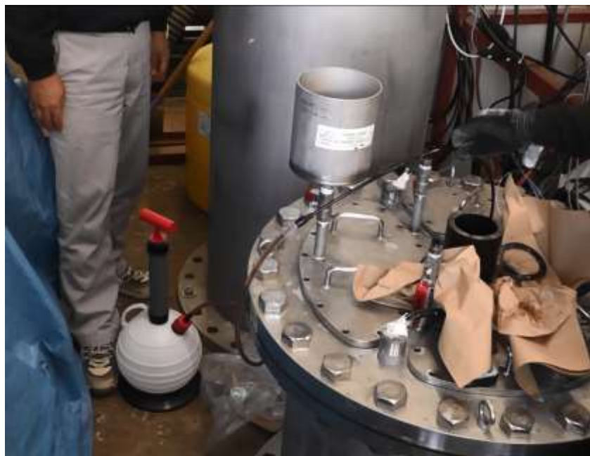
図 3.3.4-4 オイル抜きの様子
