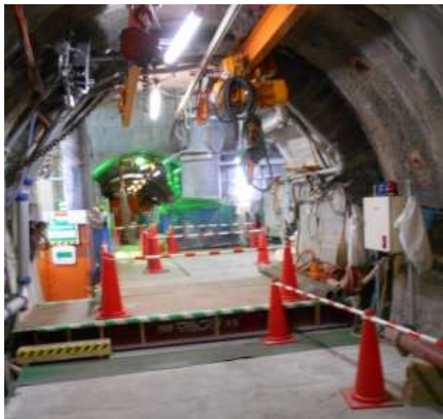
図 3.4.1-5 幌延 URL 東立坑ステージ (2016年11月29日撮影)
