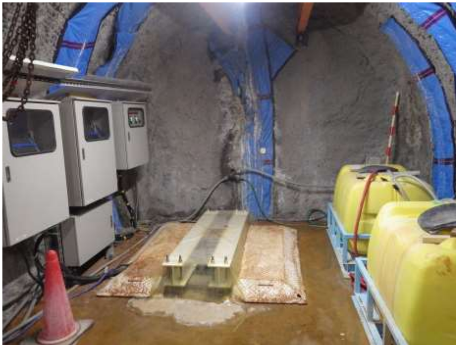
図 3.4.1-2 幌延 URL 試験坑道 5 試験孔 1 付近 (2016 年 12 月 7 日撮影)
