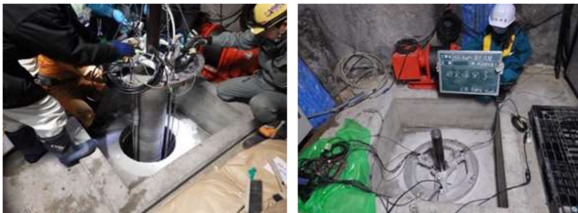
図 3.1.2-10 幌延 URL 工学規模試験 試験体設置状況
