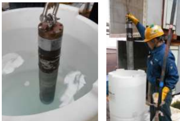
図 3.3.4-21 中和・防錆作業
