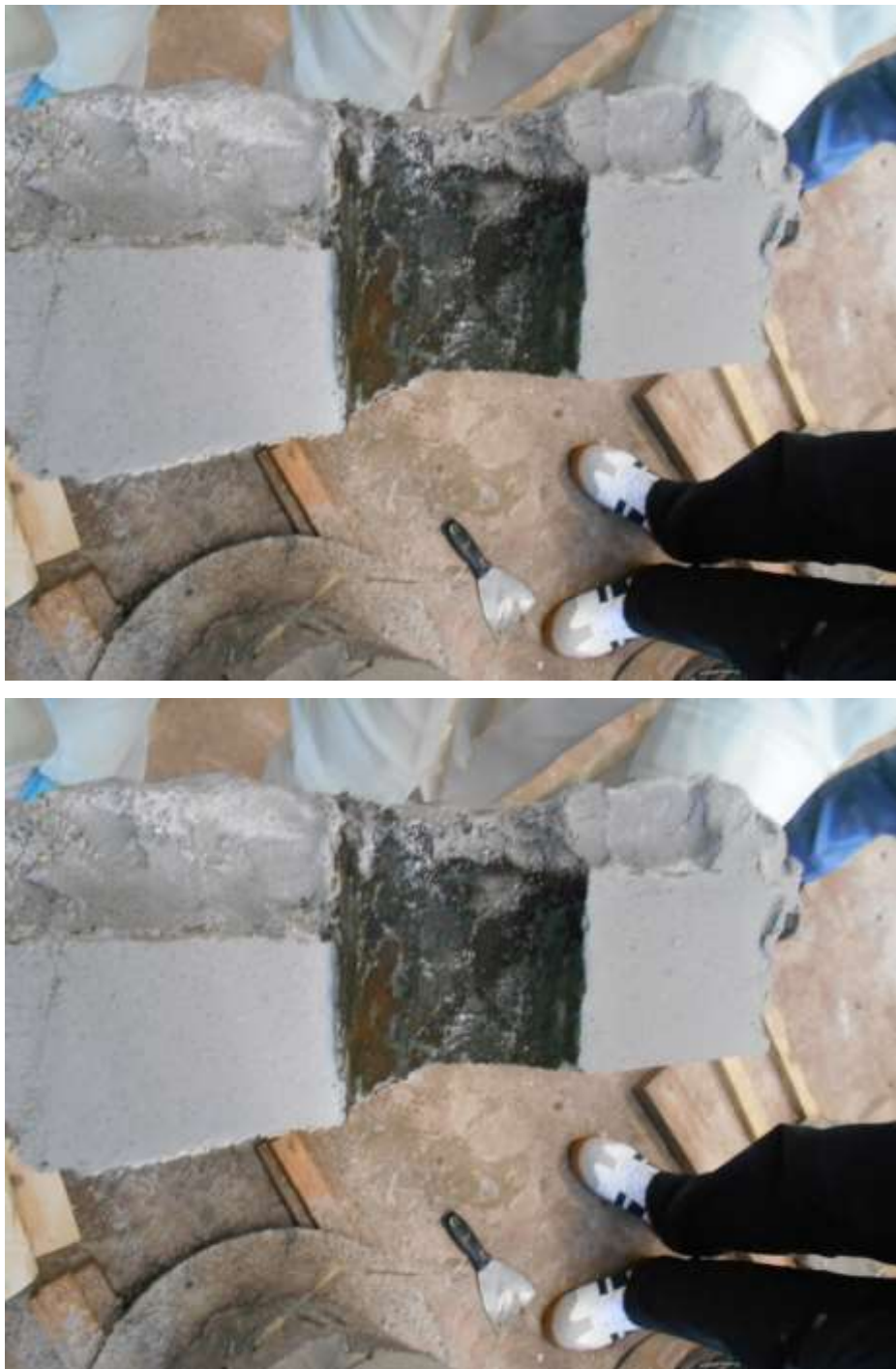
図 3.3.4-12 緩衝材ブロック切断解体後の様子（4 段目 90° 付近）
