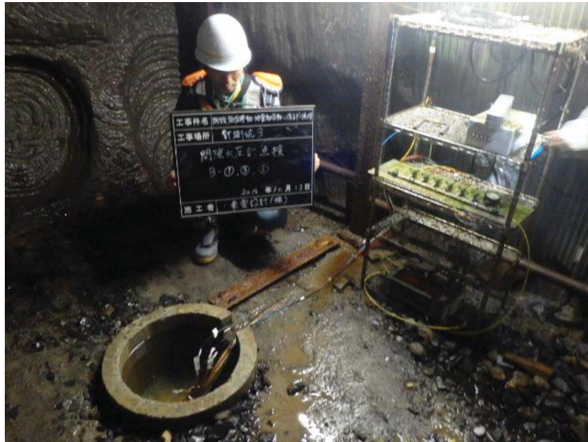
図 1.3-3 間隙水圧計点検完了（計測坑 B）（1/2）
