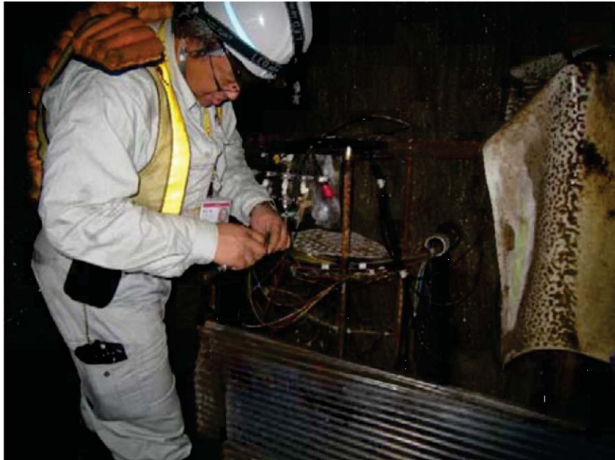
図 1.3-5 間隙水圧計点検再設置作業（計測坑 C）（1/2）
