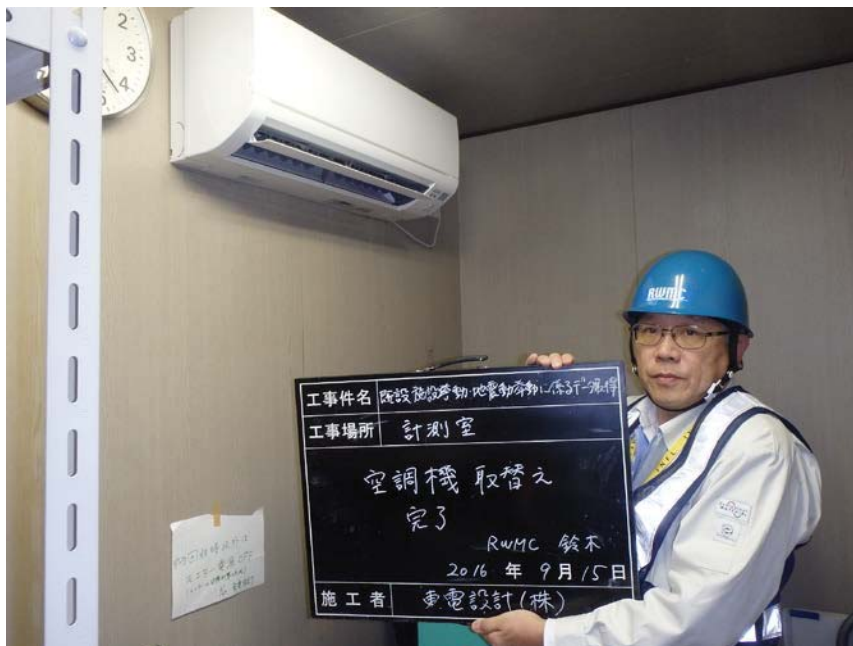
図 1.5-3 計測器室の空調機の取替え (1/2)
