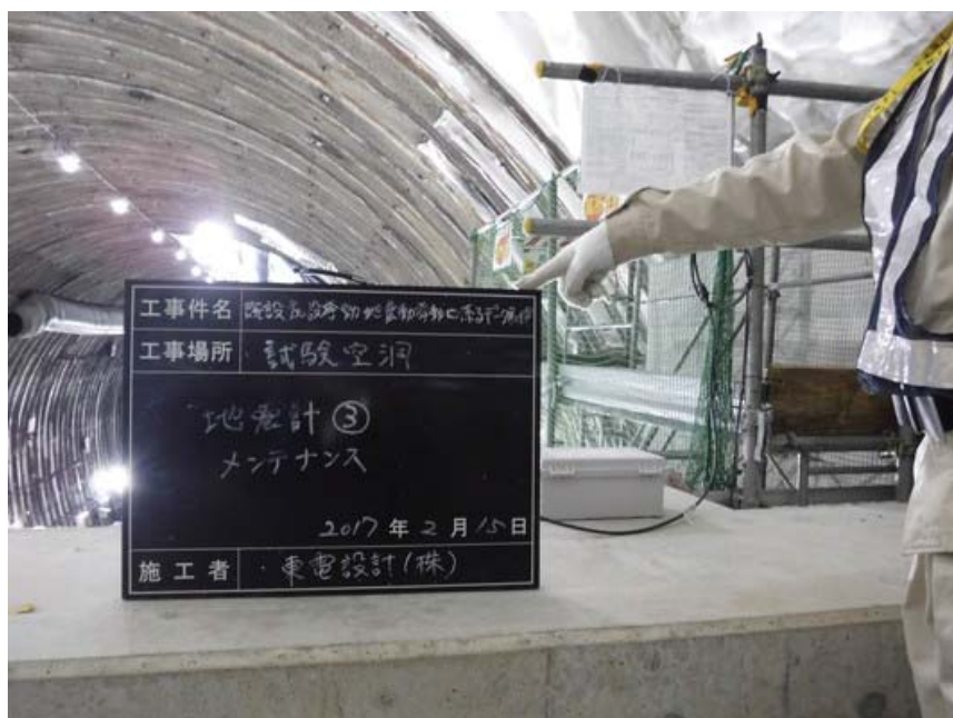
図 1.1-5 地震計③メンテナンス (1/2)
