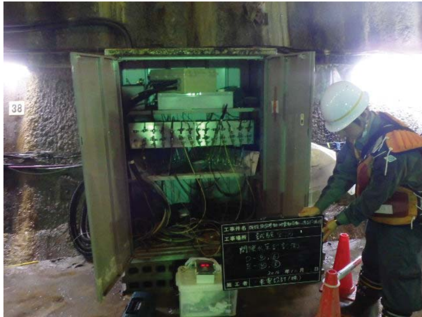
図 1.2-7 間隙水圧計計測 (D-4、D-6、E-4、E-5) (1/2)
