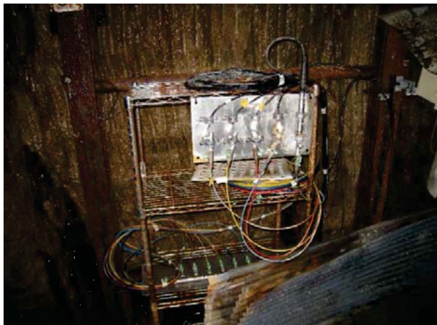
図 1.3-6 間隙水圧計点検完了（計測坑 C）（2/2）
