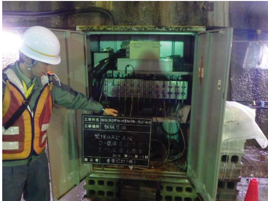
図 1.3-7 間隙水圧計点検完了（試験空洞 D、E）（1/2）
