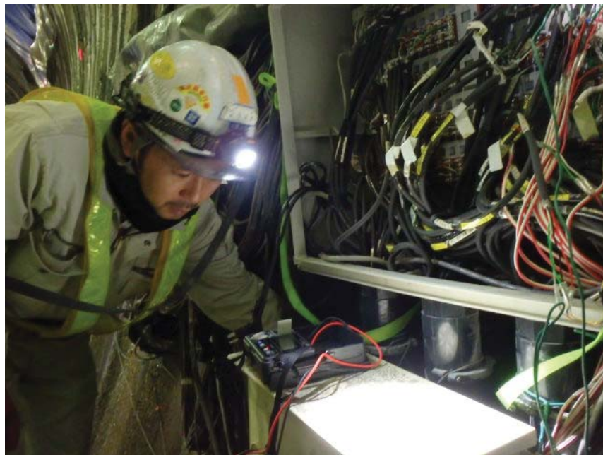
図 1.5-6 計測システムの漏電調査 (2/2)
