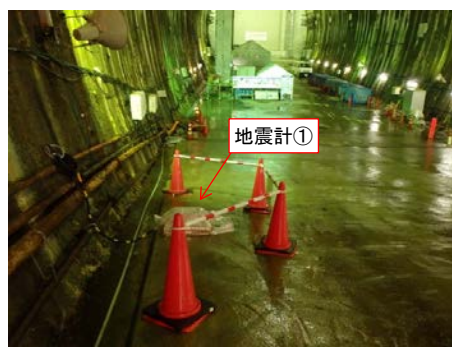
(2) 地震計① (移設後)
