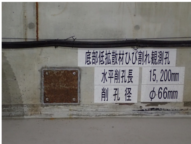
図 4.1-35 観察孔鉄板養生後
