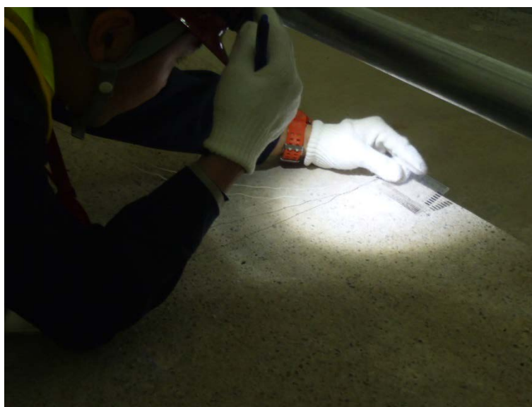
図 4.1-11 ひび割れ幅の測定状況
