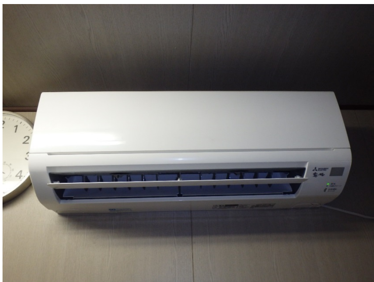
図 4.1-80 空調機設置状況
