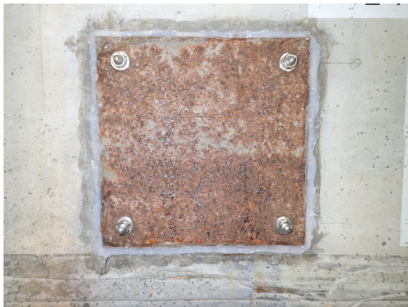
図 4.1-36 観察孔鉄板養生後（拡大）
