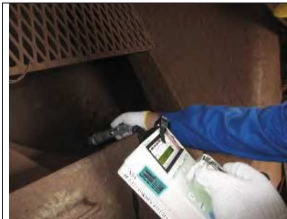
建屋集塵機造粒ダスト
