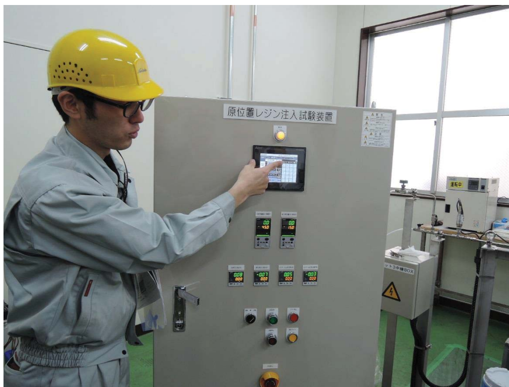
図 5.3-66 制御盤の外観とタッチパネルによる操作状況
