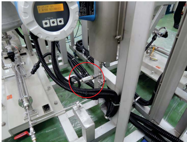
図 5.3-62 フラッシュダイアフラム式圧力センサーの外観写真
