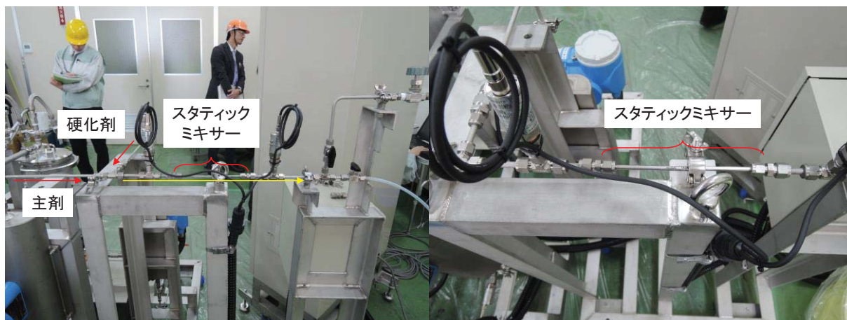
図 5.3-65 ユニット3（ミキシングユニット）の外観写真
