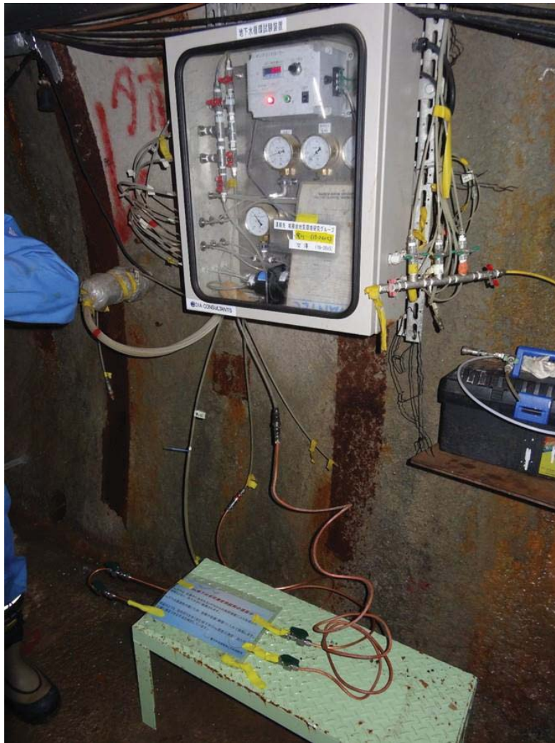
図 6.3.3-5 循環式の設置状況
