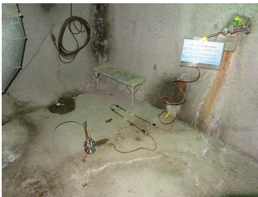
図 6.3.3-4 圧力制御式の設置状況
