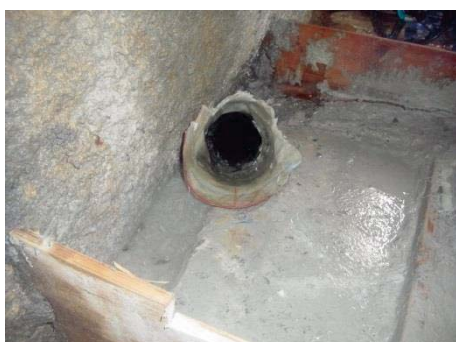
g. 施工後の孔内状況
