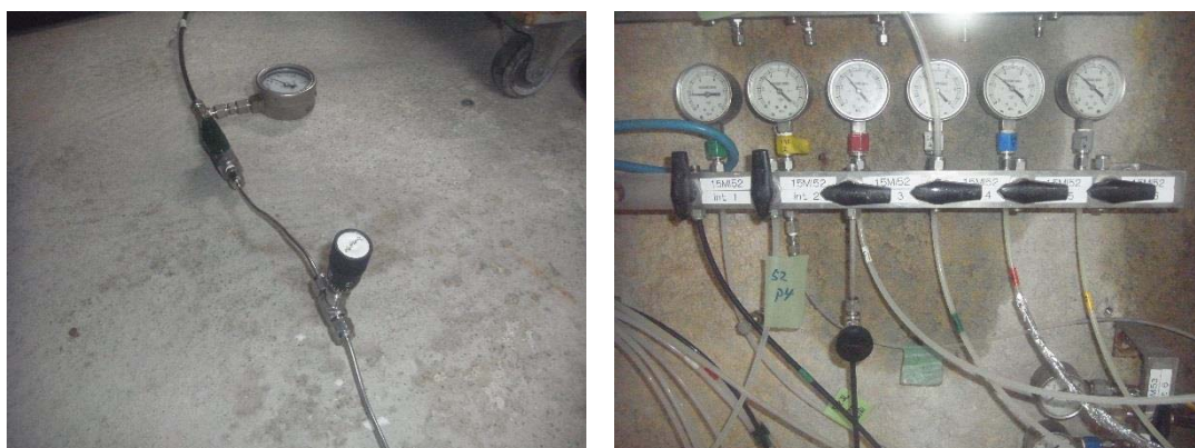
図 4.3.7-3 揚水流量制御に用いたニードルバルブ
