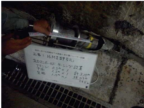
b. ケーシング挿入状況
