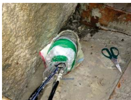
f. パッカー加圧状況（硬化養生）
