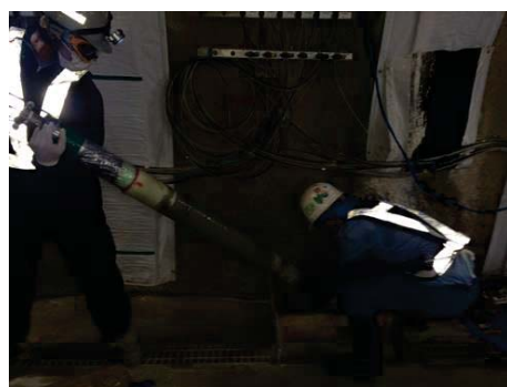
e. パッカー挿入状況
