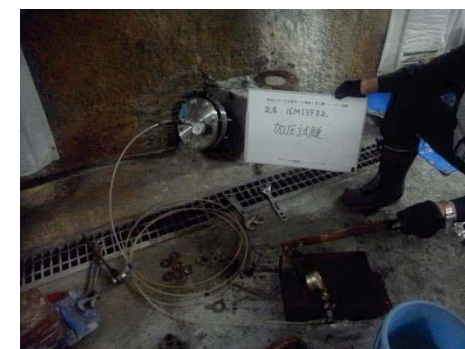
e. 加圧試験実施状況
