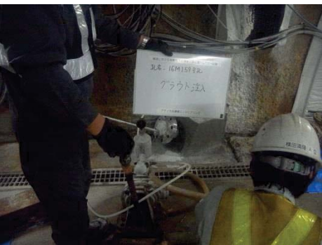
d. グラウト注入状況
