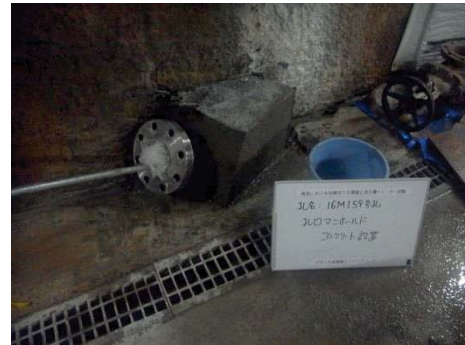
c. コンクリートブロック設置状況
