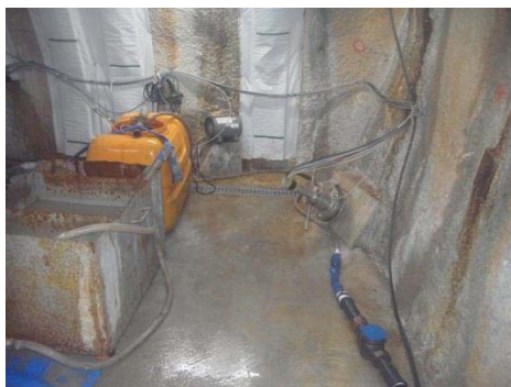
c. 樹脂製タンクおよび水道メーター
