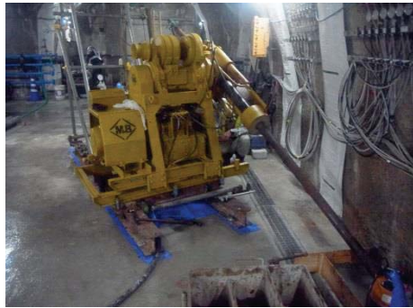
a. φ86mm (1 段階目) 掘削状況
