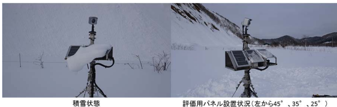
図 7.4-4 設置角評価用太陽光パネルへの積雪
