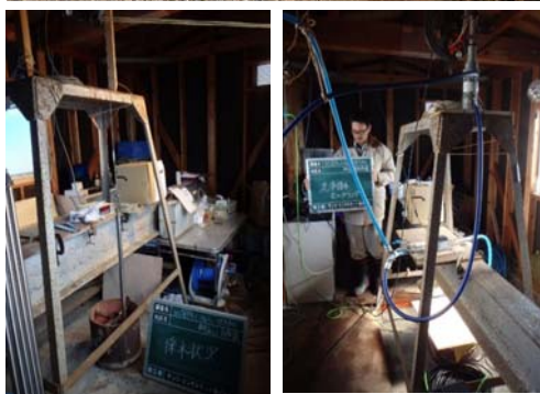
(2) 井戸小屋の内部
