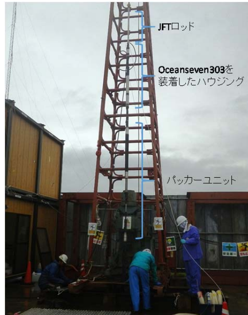
図 3-7 孔内への挿入状況
