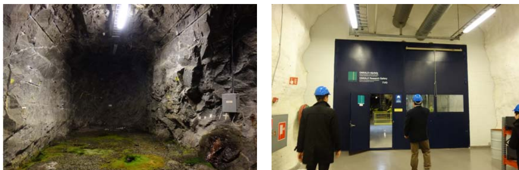
図 3.2-2 デモトンネルと地質・サイズがほぼ同じオンカロリサーチギャラリーの様子
