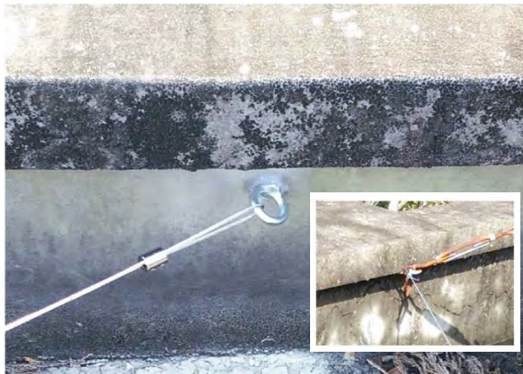
アンカーの施工状況
