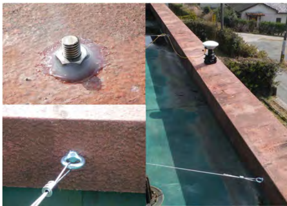
穿孔箇所とワイヤーの施工状況
