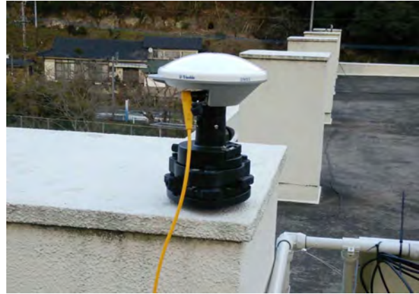
アンテナの設置状況
