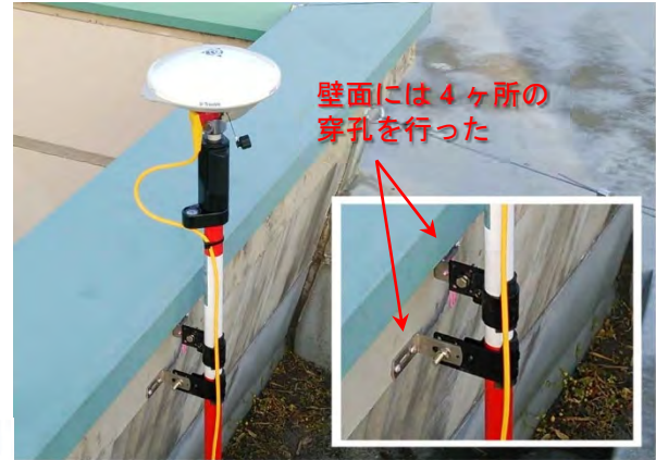
アンテナの設置状況
