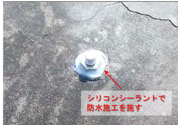
アンテナ設置のために施工したボルト
