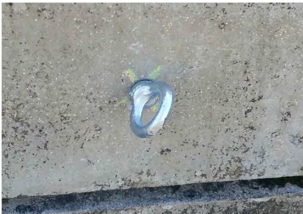
穿孔箇所にアンカーを施工
