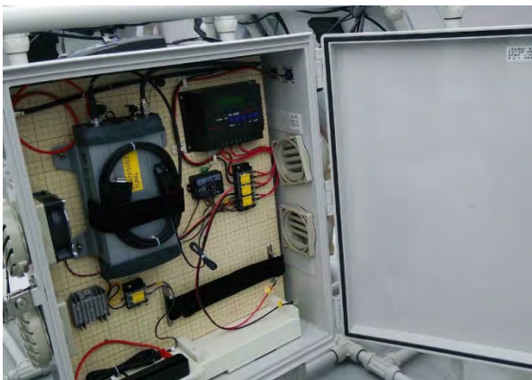
架台内の装置
