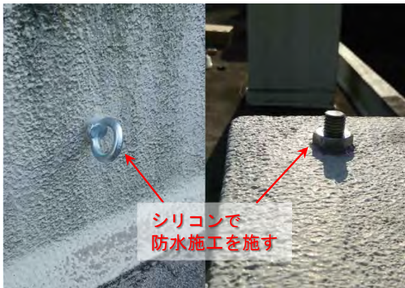
穿孔箇所(左)とアンテナ用ボルト(右)
