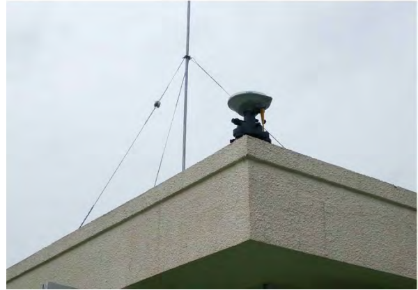
アンテナの設置状況
