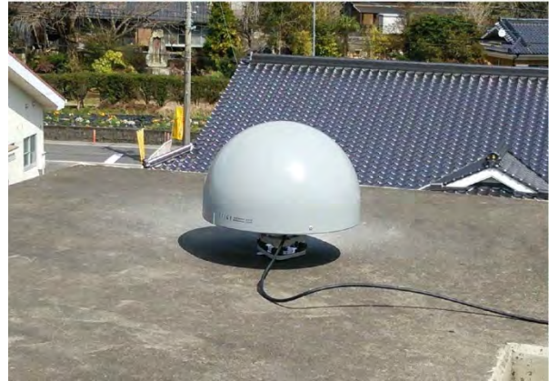
アンテナの設置状況
