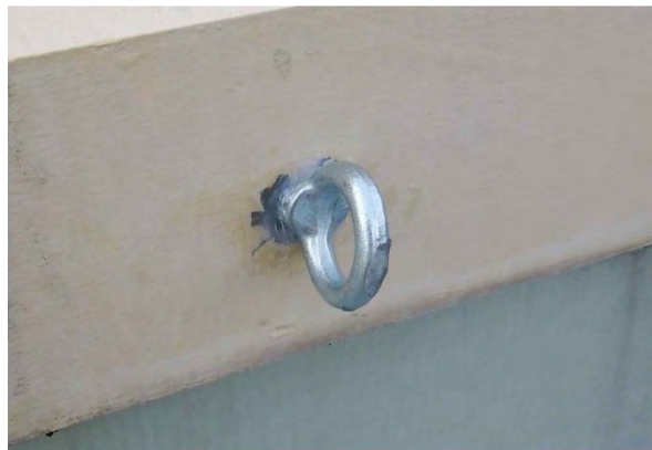
穿孔箇所にアンカーを施工
