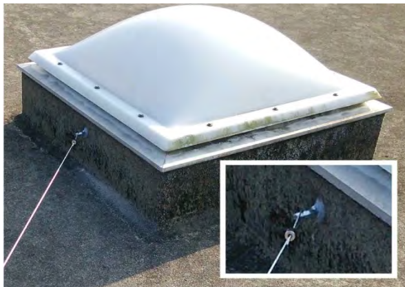
穿孔箇所アンカーを施工
