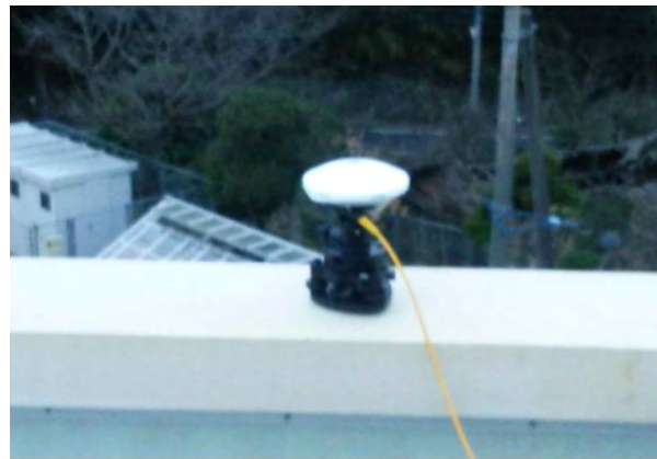
アンテナの設置状況
