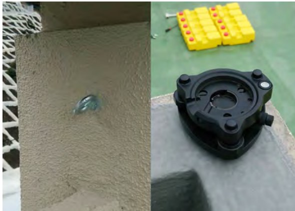
穿孔箇所(左)とアンテナ設置場所(右)
