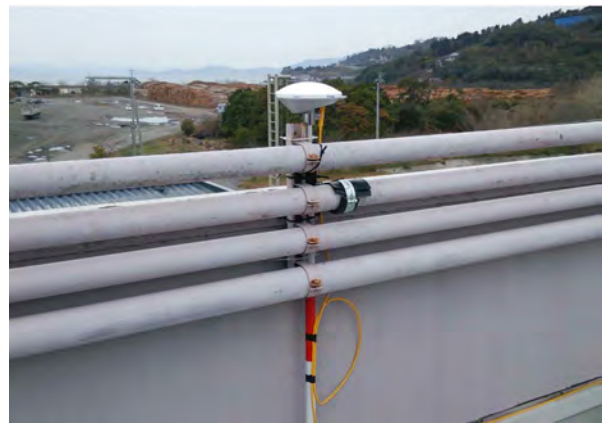
アンテナの設置状況
