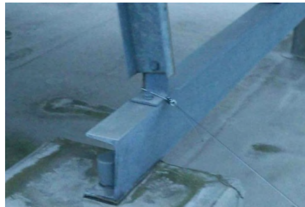
既設のソーラーパネル土台にワイヤーを固定
