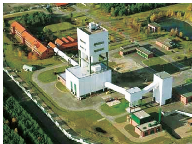
ゴアレーベンの立坑 (DBE社)
