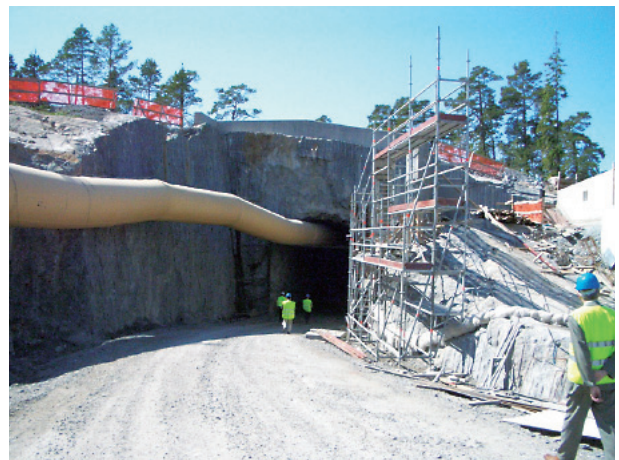
地下特性調査施設 (ONKALO) の入口
