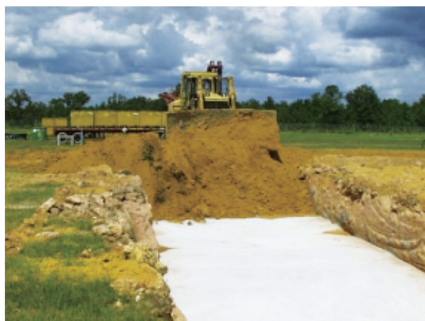
スリット式トレンチ処分(左) と埋め戻し(右) (DOEウェブサイトより引用)
