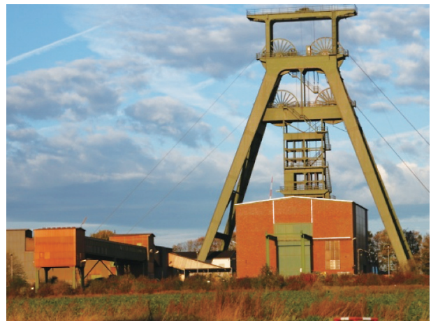
コンラッド処分場の立坑1
