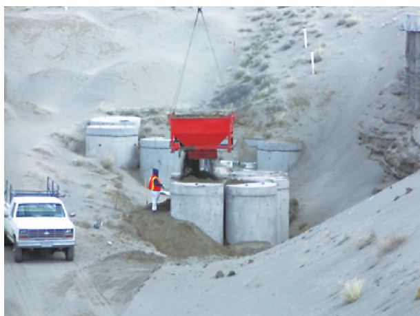
トレンチ処分の状況 (クラスB)
