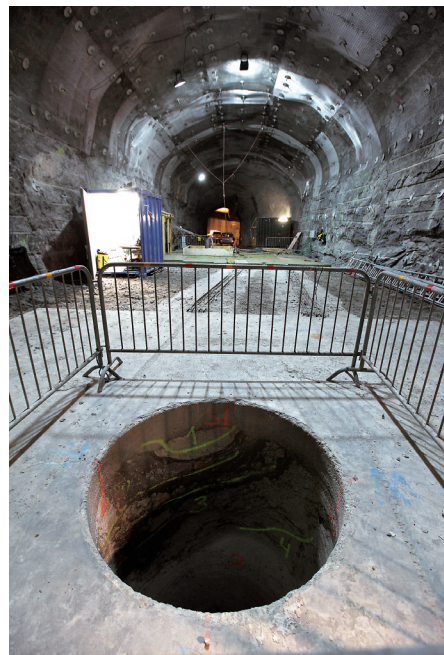
オルキルトの地下特性調査施設内の坑道と試験処分孔 （写真提供：ポシヴァ社）
