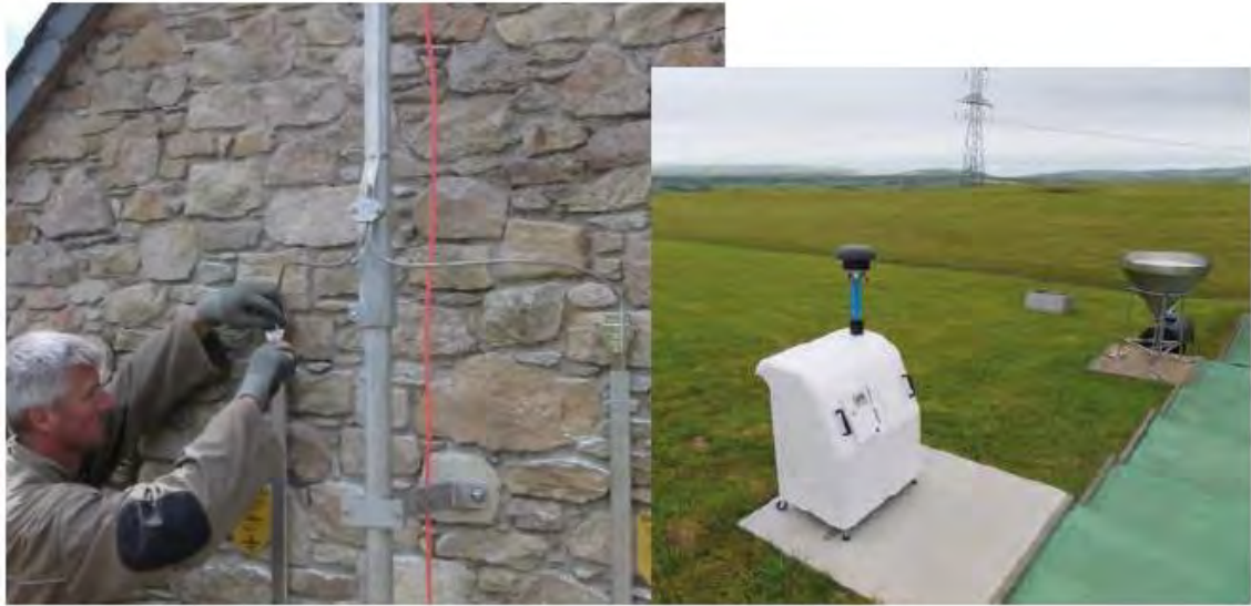
図 3.3-7 CSM の新しい気象観測機器の据付け
