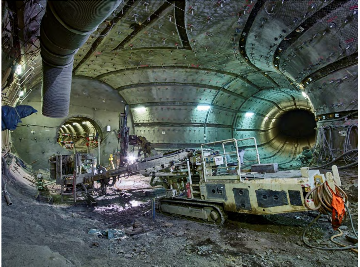
図 8.2-8 コンラッドでの定置輸送坑道の建設
