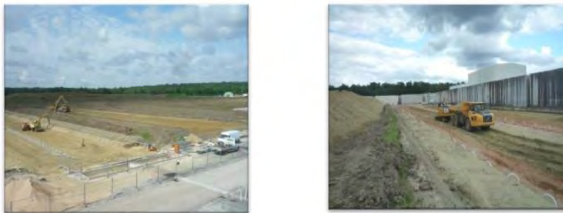
図 3.3-1 CSA のステージ 9 における土木工事
