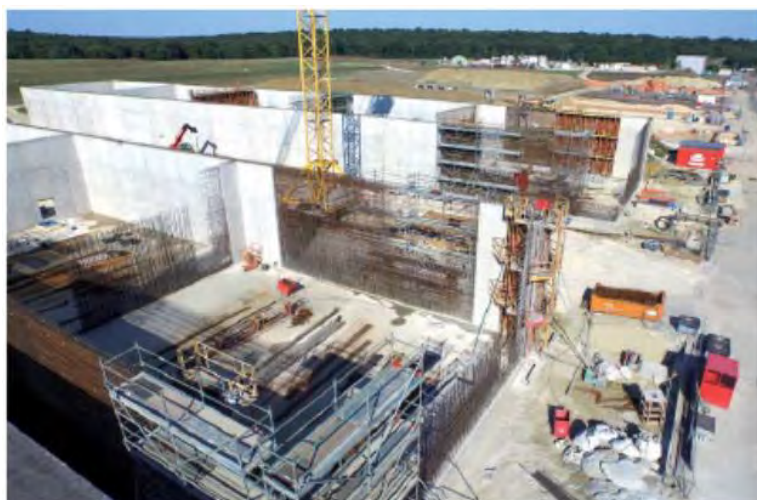
図 3.3-5 Ciresの廃棄物処理施設の建設
