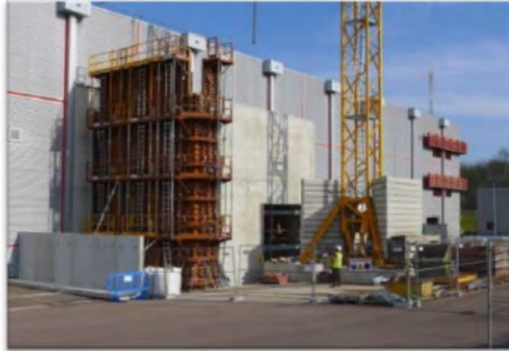
図 3.3-2 CSA の廃棄物パッケージ検査施設の建設
