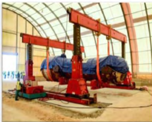
図 3.3-3 Cires での圧力容器の処分
