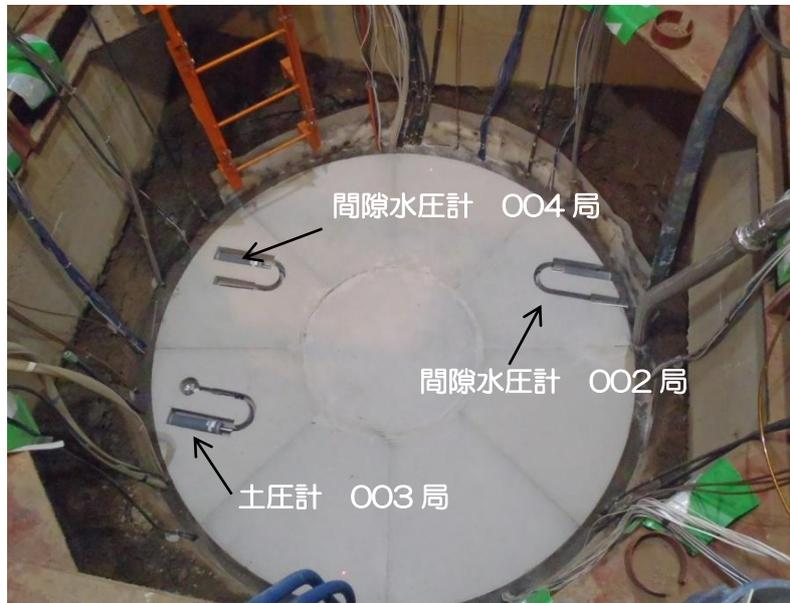
図 2.2.5-1 緩衝材ブロックへの小型送信器の設置状況
