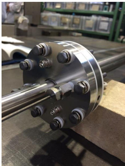
図 3.4.3-5 取り付けフランジ部 (据付後上部側)
