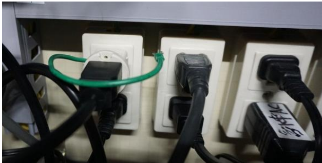
図 3.6.1-17 2極変換アダプタ適用後 (左:使用箇所 (左端上部)、右 : アダプタ形状)
