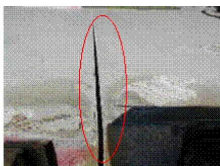
(a) 垂直方向のブロックのズレの例
