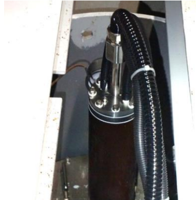
図 3.4.3-14 オイル充填・フランジ再取り付け後の外観
