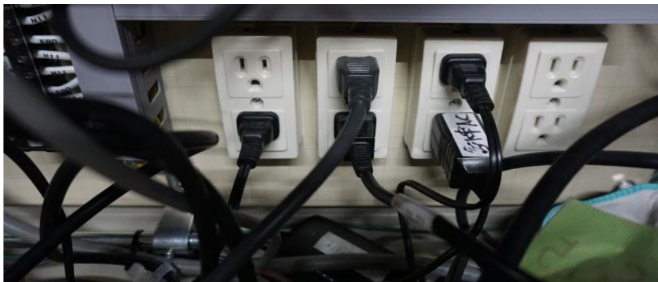
図 3.6.1-16 接続先コンセント (3 極アース式)
