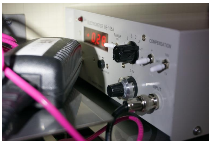
図 3.6.1-19 エレクトロメータ測定状況
