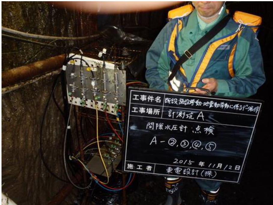
図 1.4-1 間隙水圧計点検完了 (計測坑 A) (1/2)
