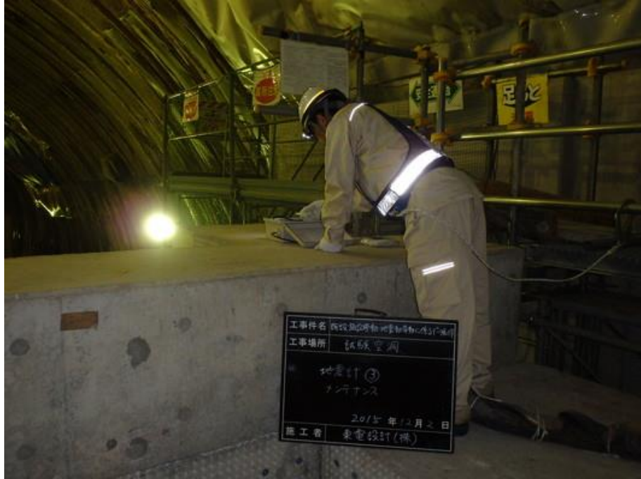
図 1.1-3 地震計③メンテナンス (1/2)
