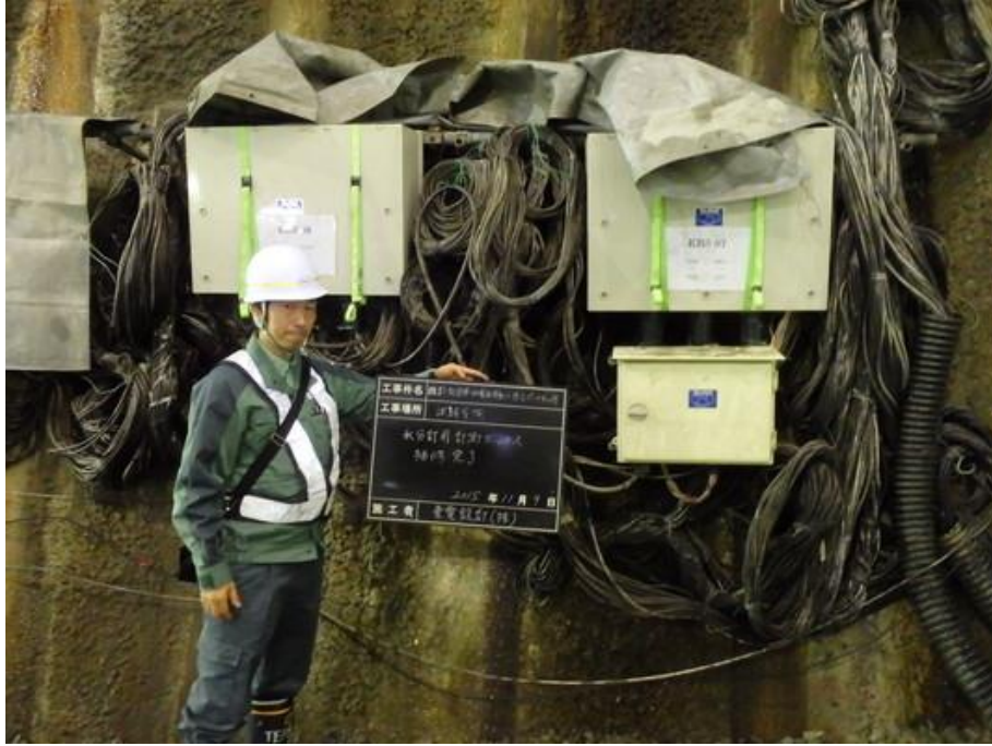
図 1.3-2 計測ボックス補修完了 (1/2)
