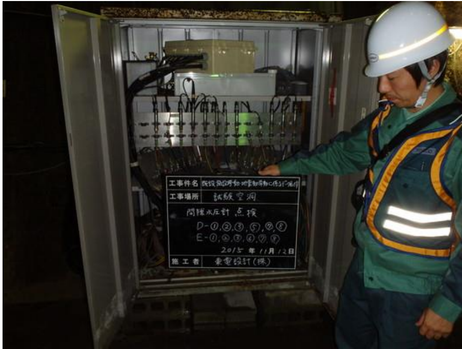
図 1.4-4 間隙水圧計点検完了（試験空洞 D、E）（1/2）
