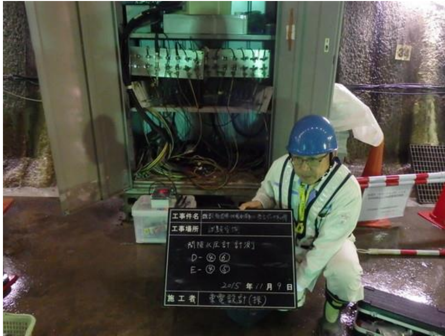
図 1.2-4 間隙水圧計計測 (D-4、D-6、E-4、E-5) (1/2)
