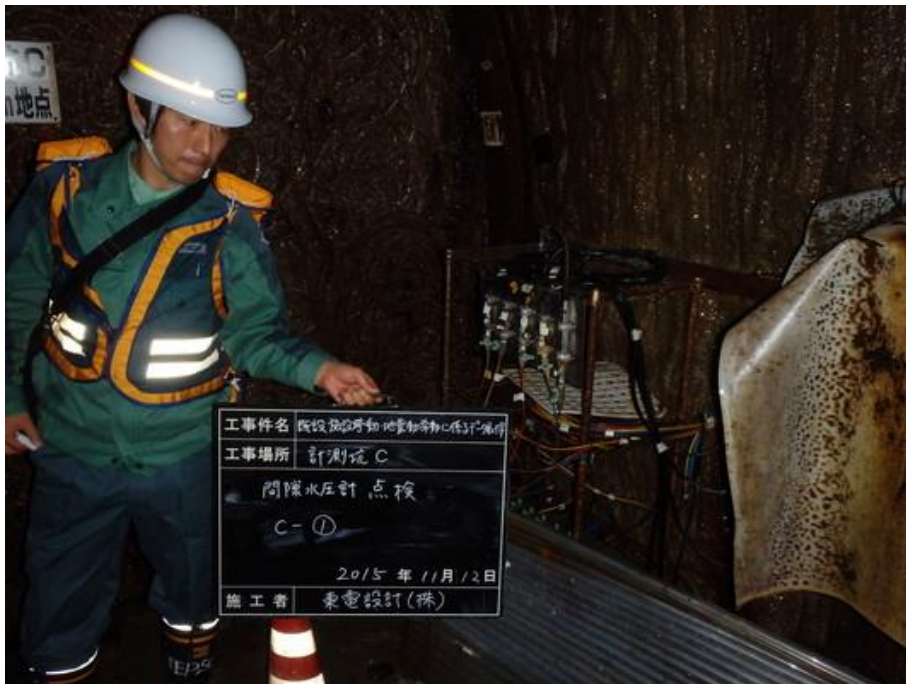
図 1.4-3 間隙水圧計点検完了（計測坑 C）（1/2）
