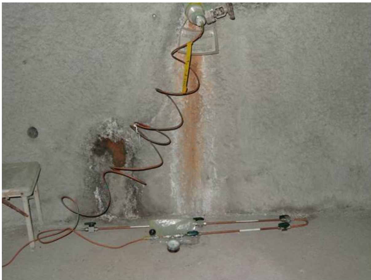
図 7.3.3-3 圧力制御式の設置状況
