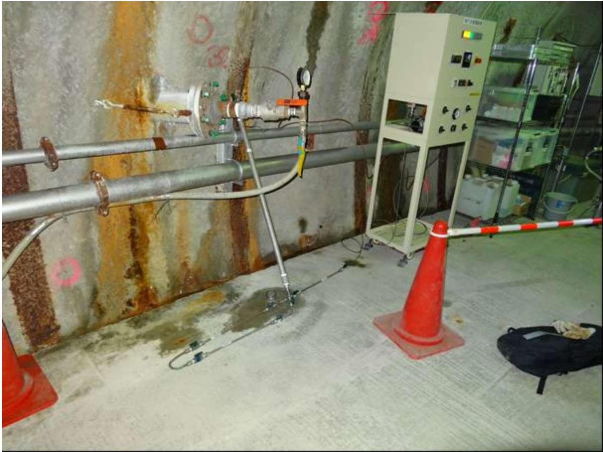
図 7.3.3-4 循環式の設置状況
