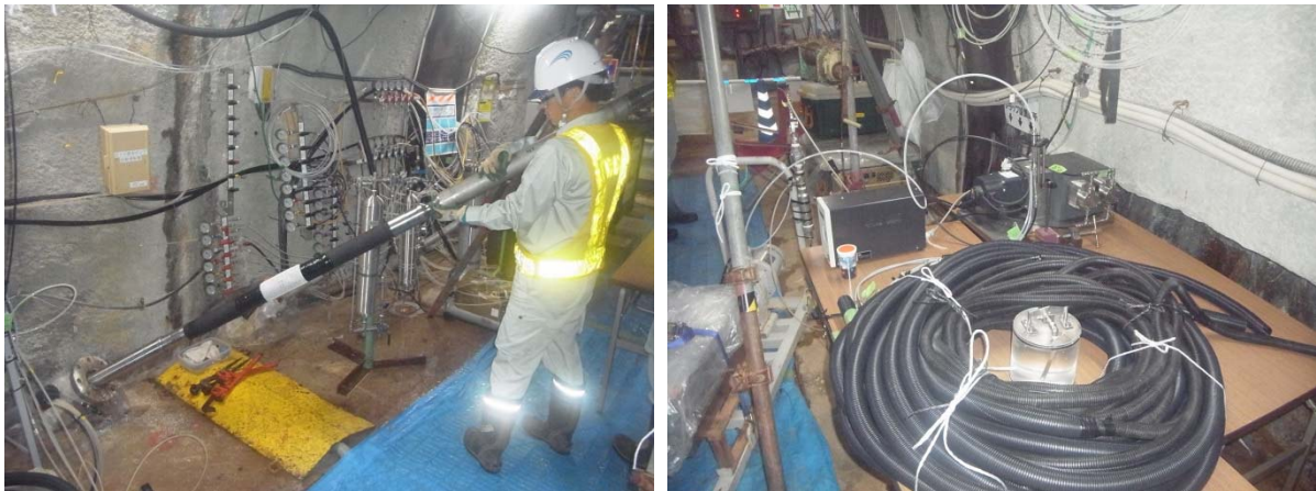
図 6.4.4-9 (左) トレーサー試験装置の挿入状況、 (右) ケーブル束を収納した蛇腹管
