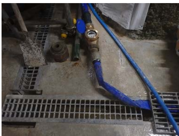
図 5.2.3-7 排水量管理（電磁流量計）
