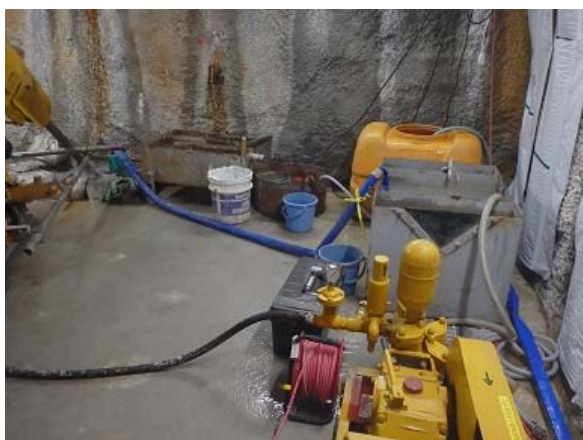
図 5.2.3-5 掘削水用タンク
