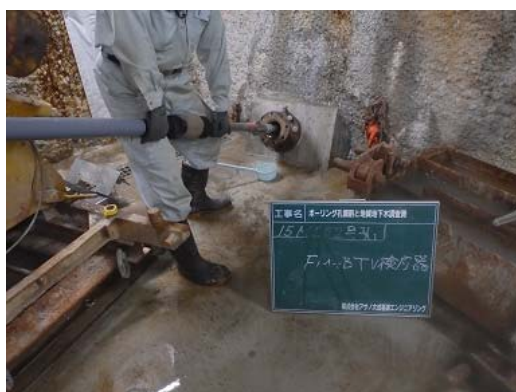
図 5.2.3-33 測定プローブ（BTV・フローメータ）の挿入状況
