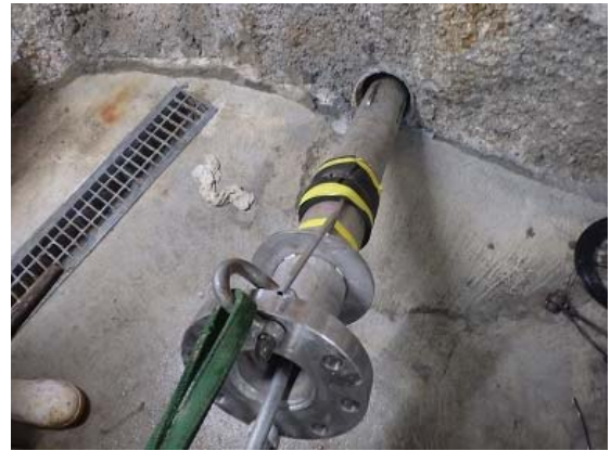
図 5.2.3-13 ケーシング挿入状況
