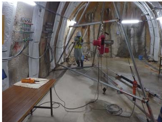
図 5.3.3-2 間隙水圧モニタリング装置 設置状況
