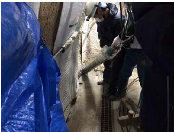
図 5.2.3-20 パッカー挿入状況
