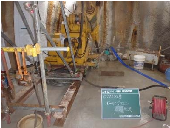
図 5.2.3-12 φ86mm (1 段目) 掘削状況
