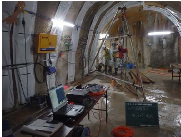
図 5.2.3-29 キャリパー検層状況
