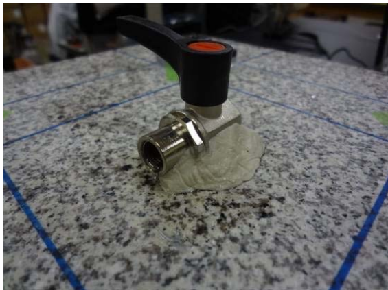
③ バルブの取付けと固定
