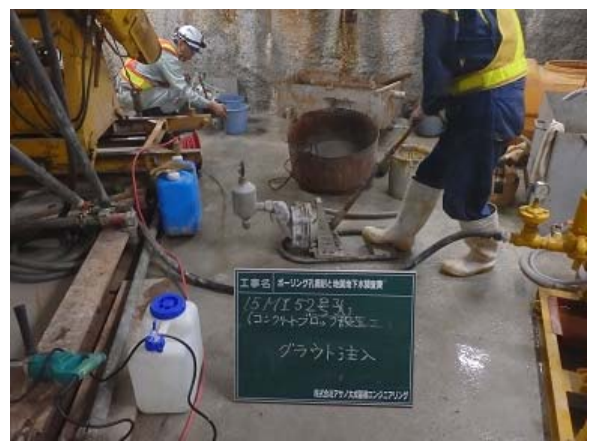
図 5.2.3-15 グラウト注入状況
