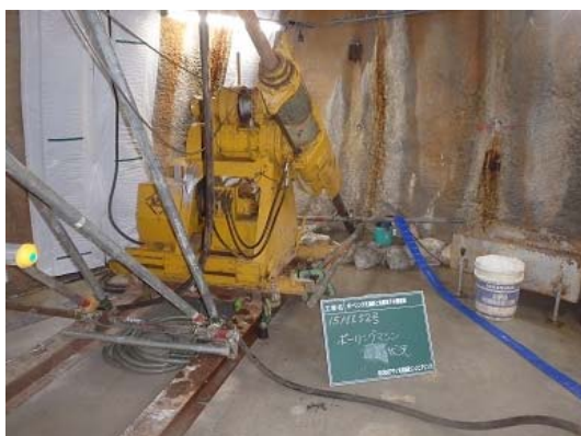
図 5.2.3-1 ボーリングマシン
