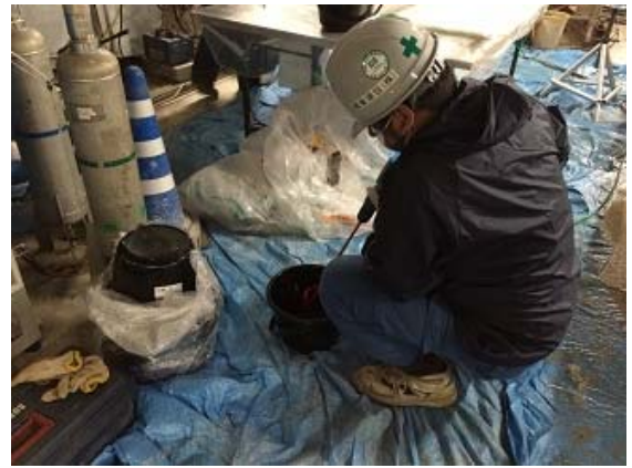
図 5.2.3-17 樹脂の攪拌状況
