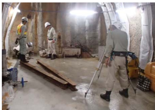
図 5.2.3-10 ボーリング孔口測量状況
