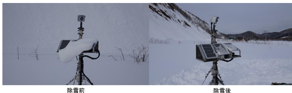
図 8.3-35 2/8 発生電力検証用太陽光パネル着雪状況
