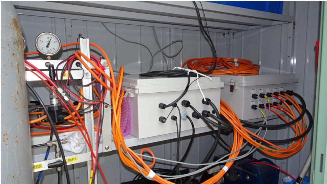
図 8.2-7 データロギングボックス設置後の既設計測小屋内状況
