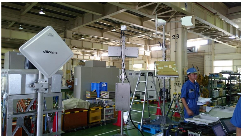
図 8.1-13 工場試験状況
