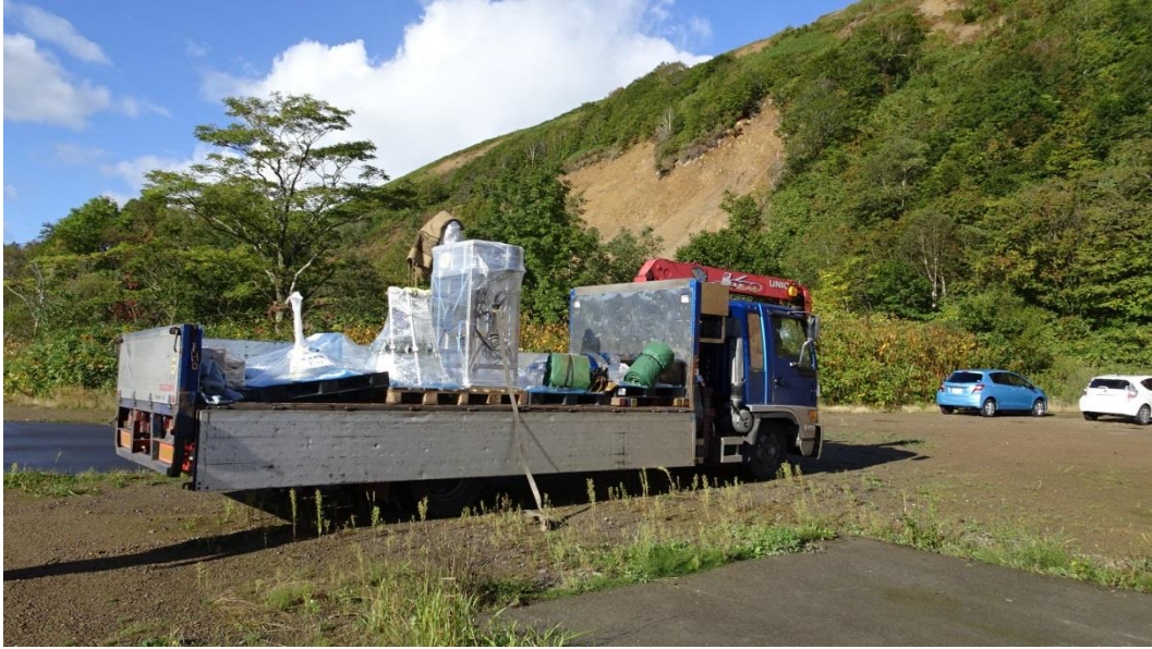
図 8.2-4 無人計測システム機器現場搬入状況
