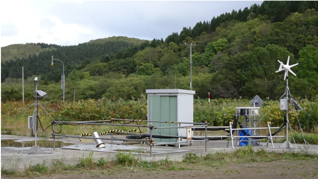
図 8.2-8 無人計測システム設置後の現場状況
