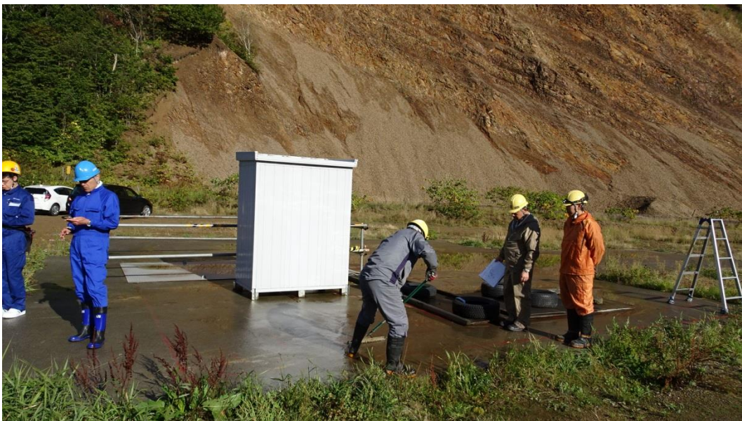
図 8.2-5 設置作業前現場状況
