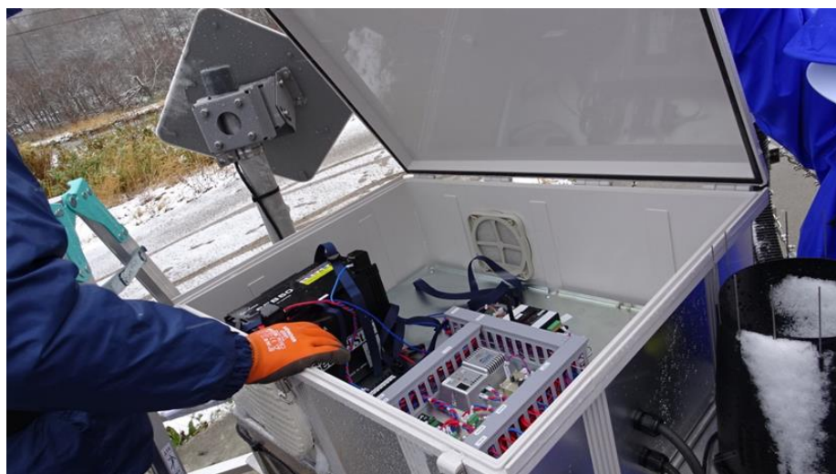
図 8.3-28 雨天時ケース B 内状況
