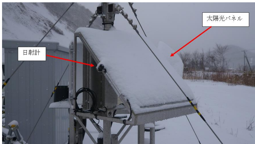
図 8.3-11 2015 年 12 月 25 日（積雪時）の太陽光パネルの着雪状態
