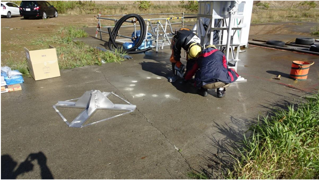
図 8.2-6 外装品取付作業状況
