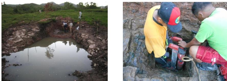
図 1.3.5-4 トレンチ(BBT02)の全容 (左) とコアリング作業 (右)
