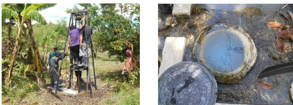
図 1.3.5-7 DH08 孔の掘削状況 (左) と Well-1 (近傍の自噴井) の白濁 (右)
