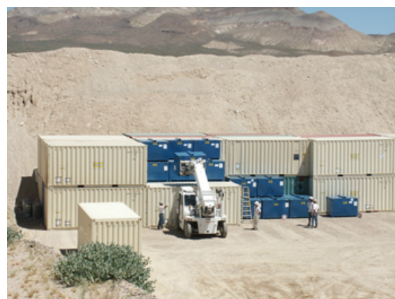
廃棄物セルへの廃棄物の定置作業
