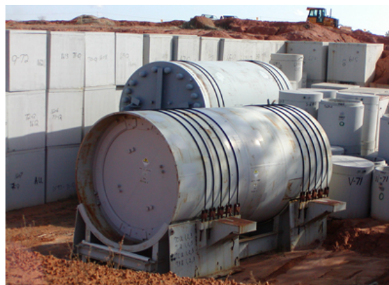
トレンチでの廃棄物定置状況
