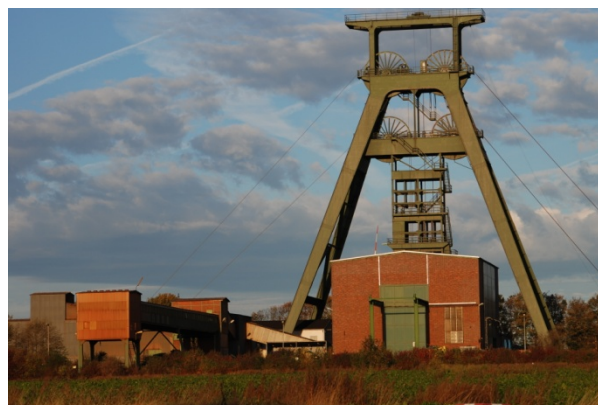
コンラッド処分場の立坑1
