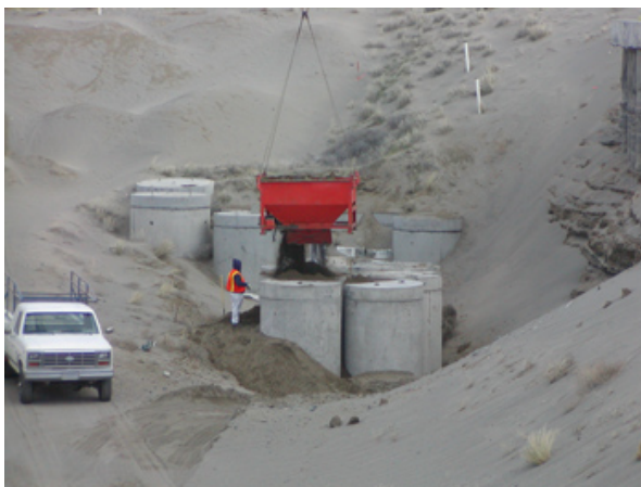
トレンチ処分の状況 (クラス B)
