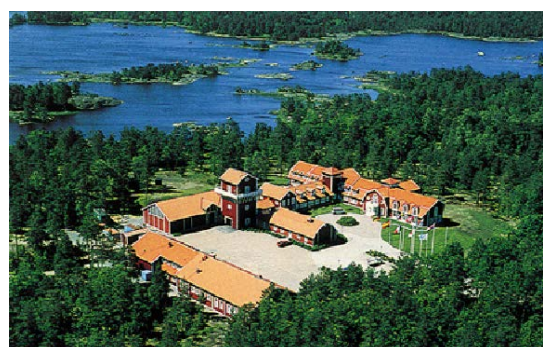
エスポ岩盤研究所の地上部
